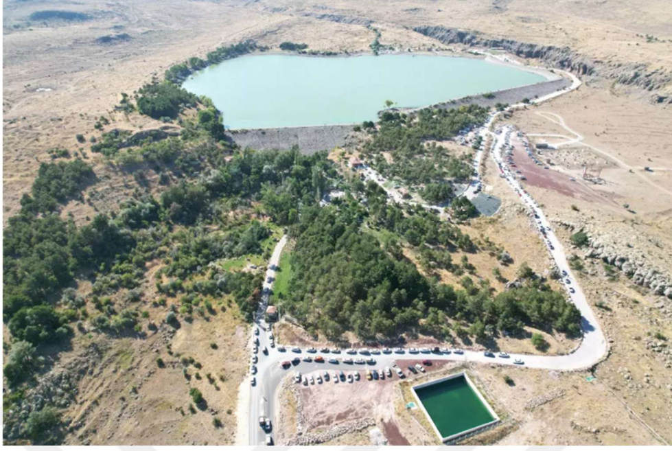
Şekil 4. Gebere Barajı (Url 2).
