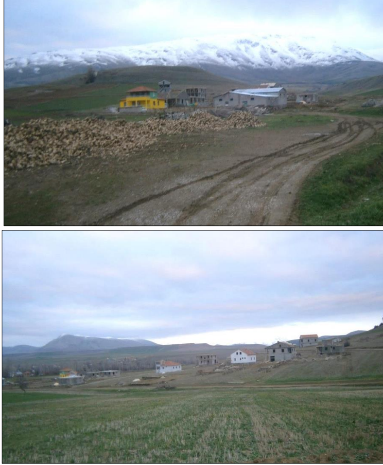
Şekil 4.14: Gümüşören Barajı yeniden yerleşim inşaatı
