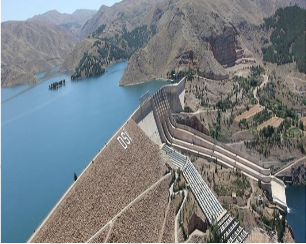
Şekil 1.1. Keban Barajı gövde görünümü
