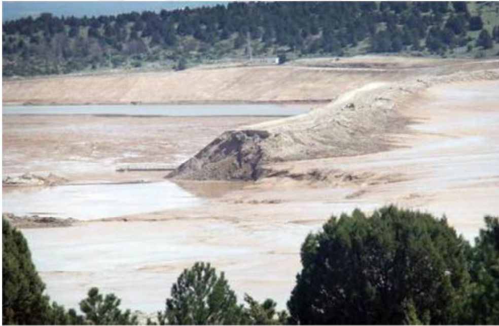
Şekil 1.16. Kütahya Gümüş Maden Atık Barajı’nın göçmesi-2011 ( http://www.sabah.com.tr/ )
