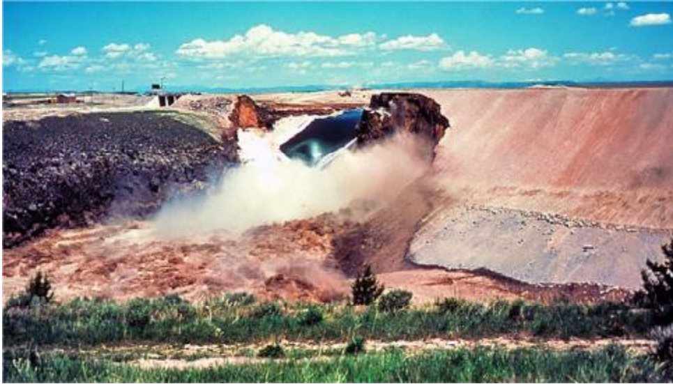
Şekil 1.7. Teton dolgu barajının yıkılması-1976 ( http://www.geol.ucsb.edu/ )
