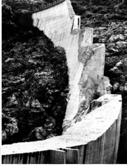
Şekil 1.6. Malpasset baraj yıkılması olayı-1959 (Nicholas, 2015)
