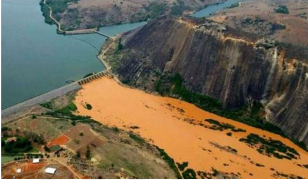
Şekil 1.17. Brezilya Minas Gerais Atık Barajı'nın yıkılması-2015 ( http://tr.euronews.com/ )
