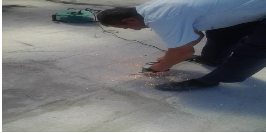
Şekil 3.12 Ahşap blokları yerleştirme öncesinde vida başlarının kesilmesi (Kişisel arşiv, 2013)
