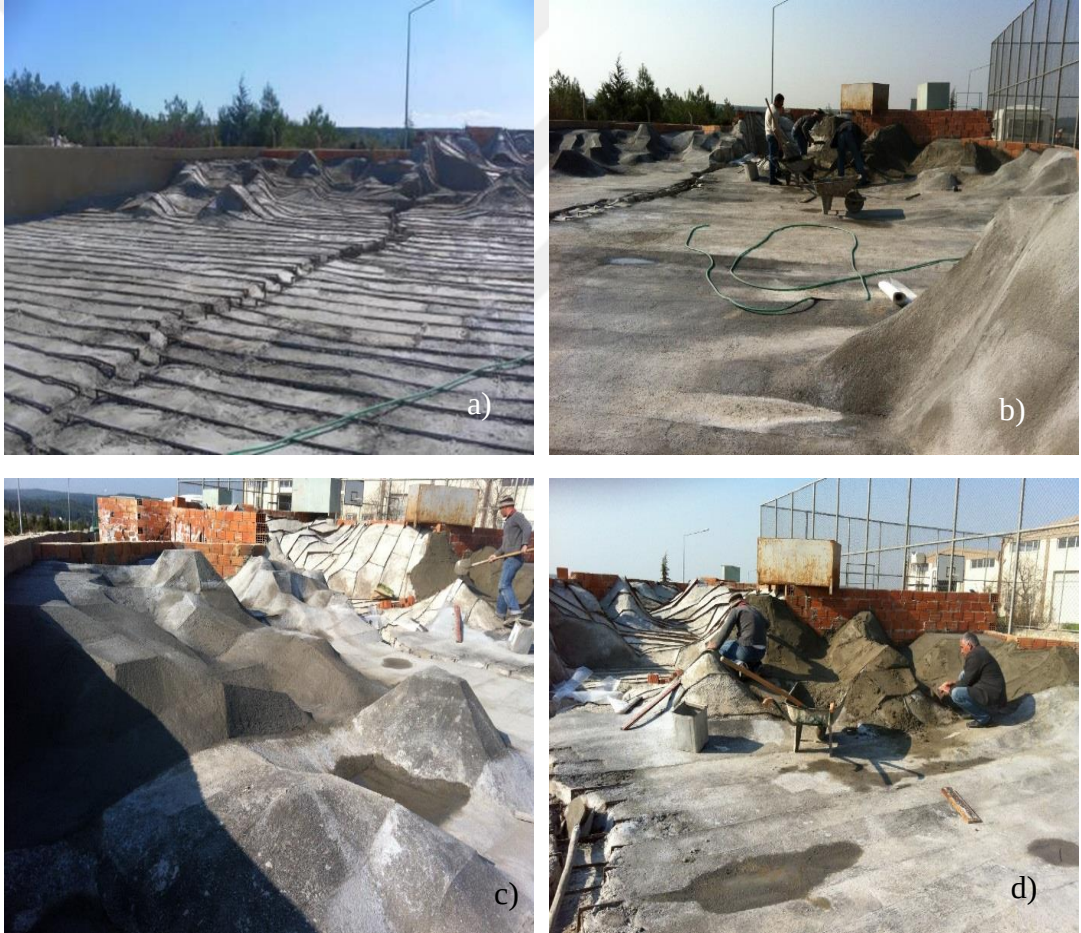
Şekil 3.10 (a) (b) (c) (d) Mansap bölgesinin betonlanması (Tübitak 110M240, 2013)
