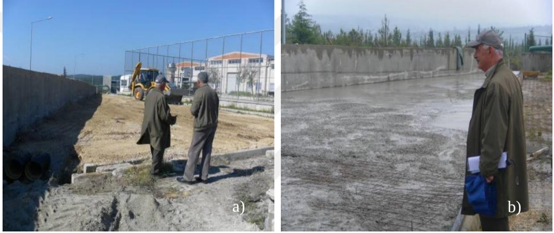
Şekil 3.3 (a) Dolgu malzemesinin serilmesi (b) Lamalar arası hasırlı donatı uygulaması ve beton dökülmesi (Tübitak 110M240, 2013)
