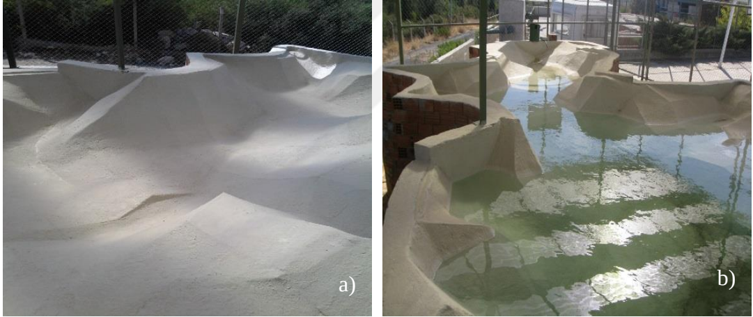
Şekil 3.17 (a) (b) Baraj gölünün yalıtımı yapıldıktan sonraki hali (Kişisel arşiv, 2013)
