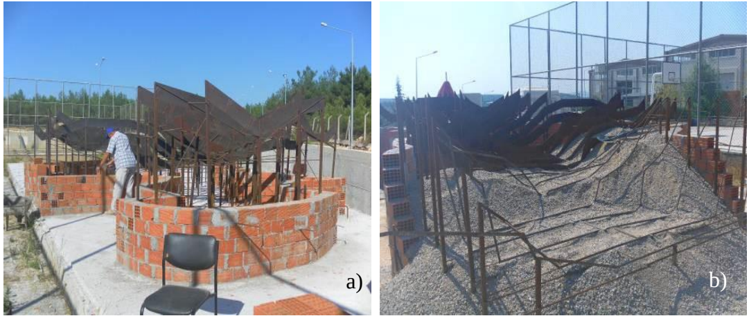
Şekil 3.6 (a) Baraj gölünün tuğla ile örülen duvarları (b) Dolgu malzemesi ile doldurulması (Tübitak 110M240, 2013)
