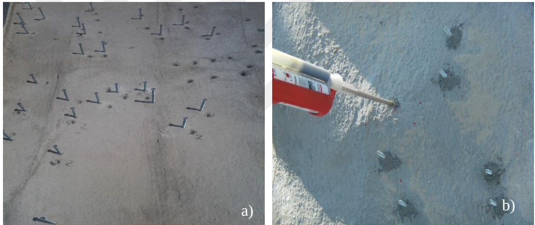
Şekil 3.11 (a) Evlerin konumunu gösteren işaretlemeler (b) Vidaların deliklere montajı (Tübitak 110M240, 2013)
