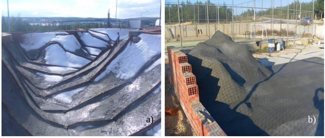
Şekil 3.7 (a) Betonlama işlemi (b) Beton üzeri şap tabakası imal edilmesi (Kişisel arşiv, 2013)
