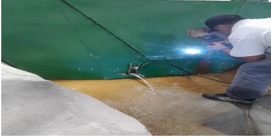
Şekil 3.18 Baraj gövdesine giren suyun tahliye edilmesi için yapılan tamirat (Kişisel arşiv, 2013)
