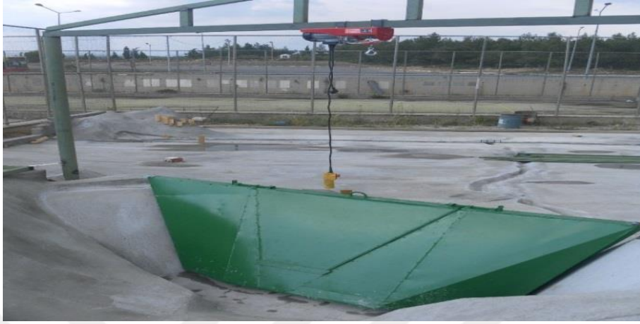
Şekil 3.16 Baraj gövdesine ve mekanizmasına ait detaylar (Kişisel arşiv, 2013)
