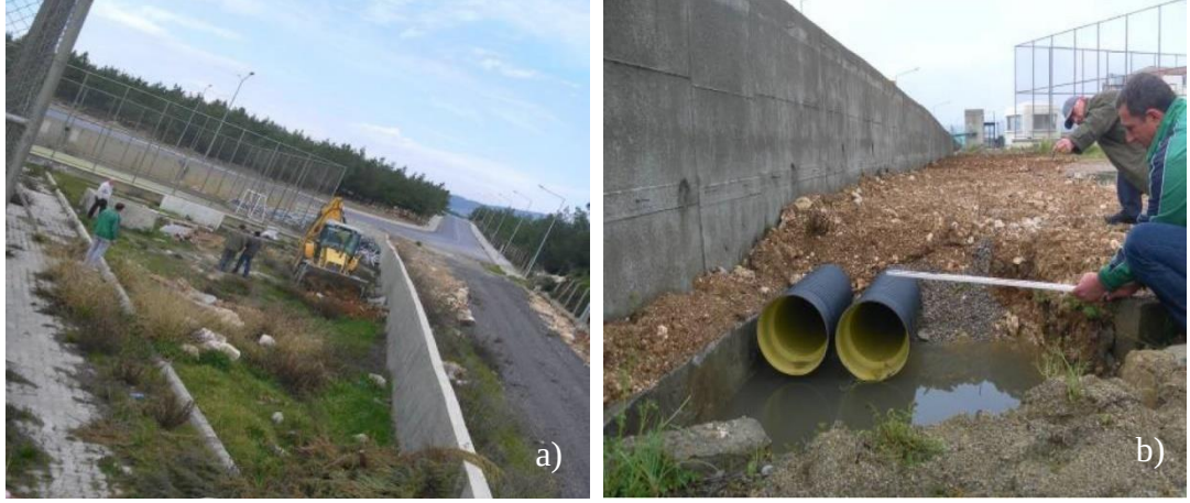
Şekil 3.2 (a) Model inşaatının yapıldığı alan (b) Drenaj boruları (Tübitak 110M240, 2013)
