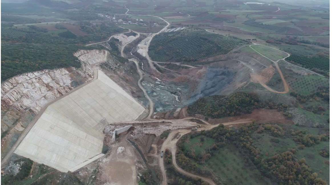
Şekil 3.5. Yeşildere Barajı mansap görünüşü
