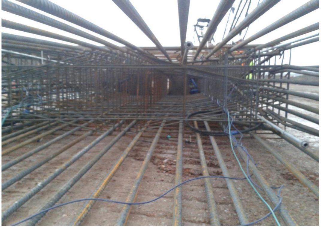
Şekil 7.20: Baret Donatısı ve Aletsel Gözlem Ekipmanlarının Montajı
