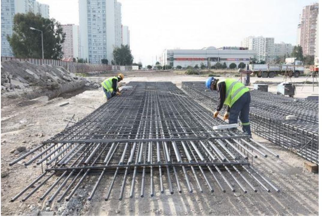
Şekil 4.5: Baret Kazık Donatısının Hazırlanması ( www.egezemin.com )
