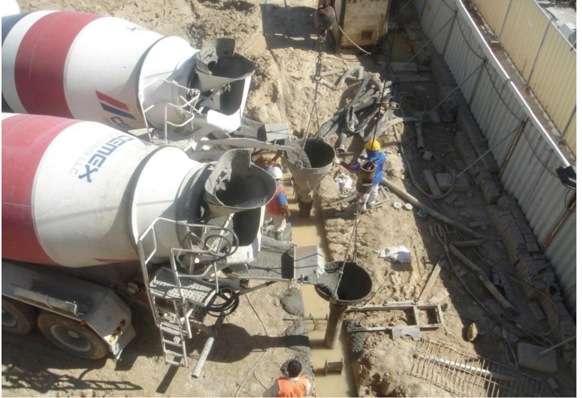
Şekil 4.8: Betonlama (Zetaş, 2011)
