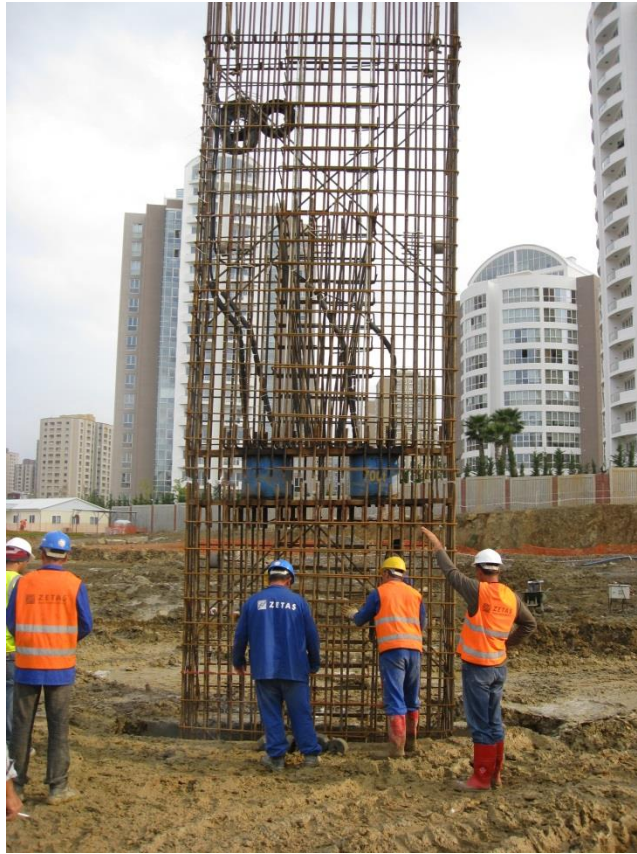
Şekil 5.15: Donatı Kafesinin Kuyuya İndirilmesi (Zetaş, 2009)
