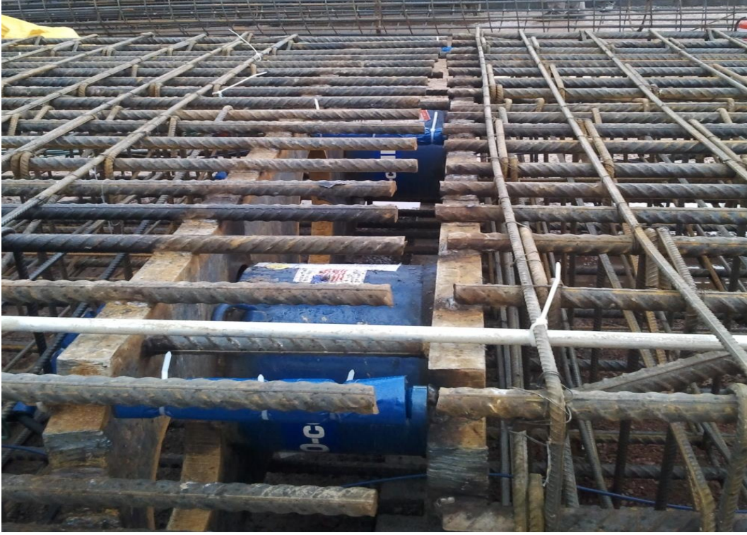
Şekil 7.18: O-Cell Hücresinin Montajı
