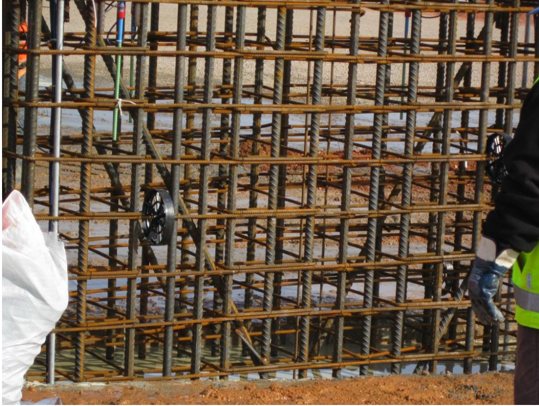
Şekil 7.23: Donatı Kafesi ve Yüklemeye Düzenekinin Kuyuya İndirilmesi
