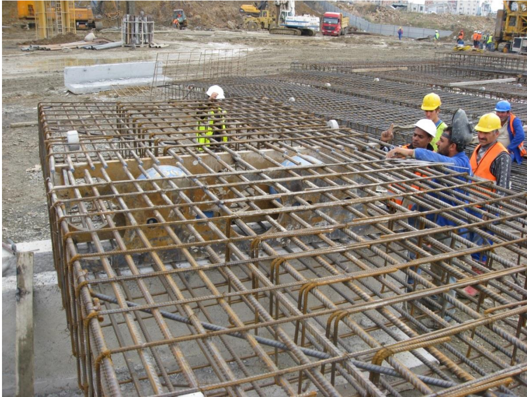
Şekil 5.12: Osterberg Hücresinin Montajı (Zetaş, 2009)
