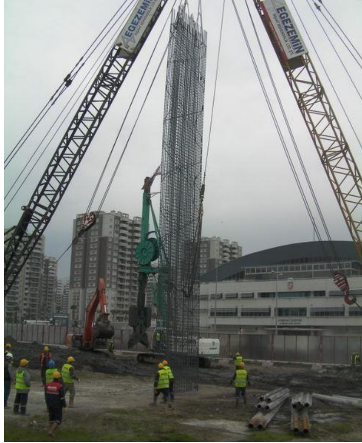
Şekil 4.6: Donatı Kafesinin Kuyuya İndirilmesi ( www.egezemin.com )
