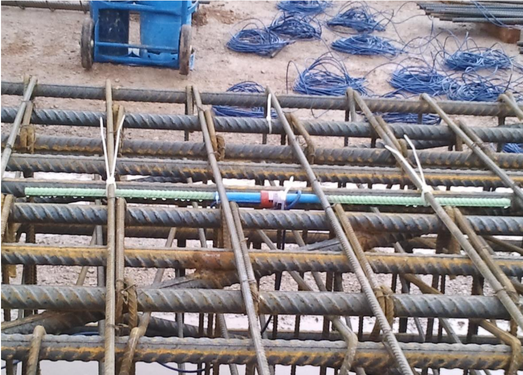
Şekil 7.19: Strain Gauge Yerleşimi
