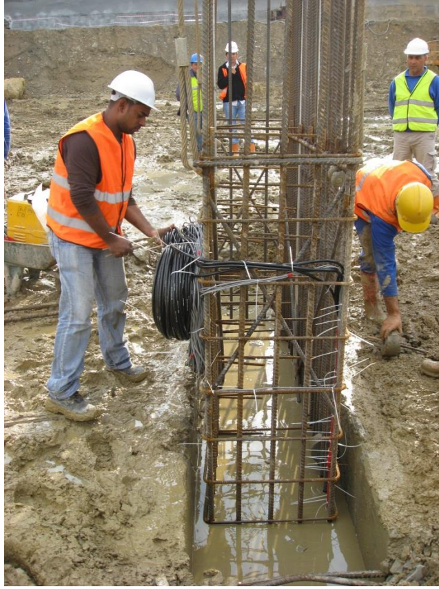
Şekil 5.14: Deney Kazığının Enstrümantasyonu (Zetaş, 2009)
