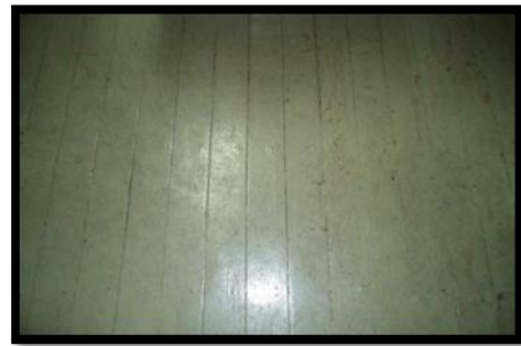
Resim 4.51. 1-11a mekânı zemin kaplaması [Gül, 2012]
