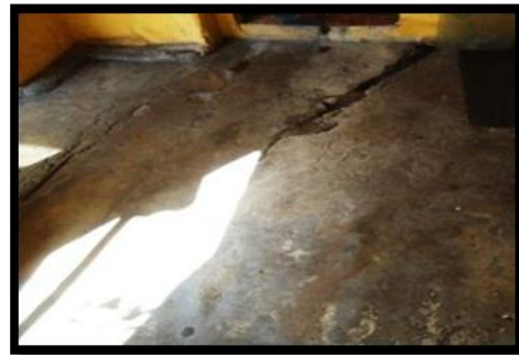
Resim 4.55. 1-14 mekânı zemin kaplaması [Gül, 2012]
