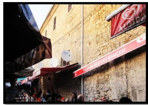
Resim 4.12. Güneybatı cephesi [Gül, 2012]
