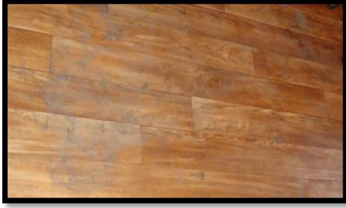
Resim 4.48. 1-09 mekânı zemin kaplaması [Gül, 2012]
