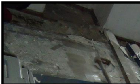
Resim 4.46. 1-07 mekânı zemin kaplaması [Gül, 2012]
