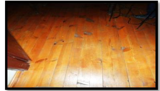
Resim 4.43. 1-04 mekânı zemin kaplaması [Gül, 2012]
