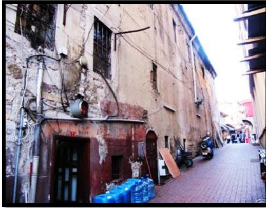
Resim 4.9. Güneydoğu cephesi [Gül, 2012]
