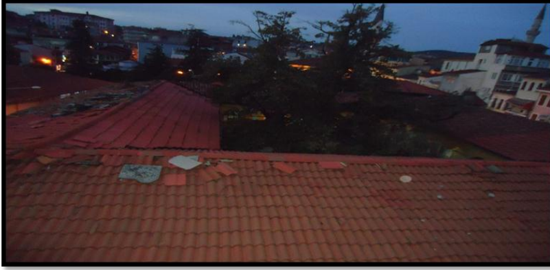
Resim 4.129. Çatı örtüsü [Gül, 2012]
