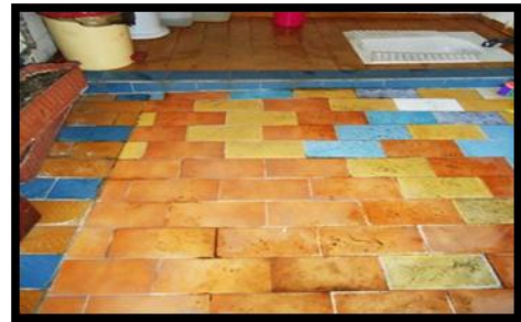
Resim 4.53. 1-13 mekânı zemin kaplaması [Gül, 2012]
