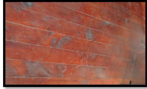
Resim 4.49. 1-10 mekânı zemin kaplaması [Gül, 2012]
