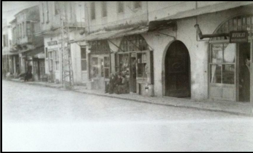
Resim 3.10. Taş Han Kuzeydoğu cephesi [Çetin Asma arşivinden, 1967]
