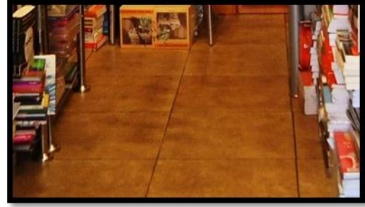
Resim 4.27. Z-02 mekânı zemin kaplaması [Gül, 2012]
