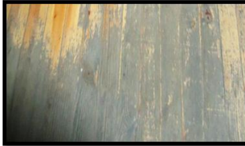
Resim 4.44. 1-05 mekânı zemin kaplaması [Gül, 2012]
