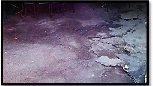
Resim 4.39. Z-10 mekânı zemin kaplaması [Gül, 2012]
