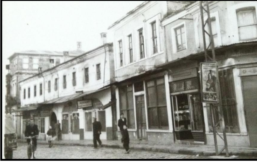
Resim 3.9. Taş Han Kuzeydoğu cephesi [Çetin Asma arşivinden, 1967]
