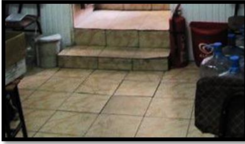
Resim 4.25. B-01 mekânı zemin kaplaması [Gül, 2012]
