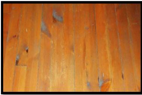
Resim 4.50. 1-11 mekânı zemin kaplaması [Gül, 2012]
