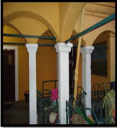
Resim 4.137. Kemer düzenindeki aksaklıklar [Gül, 2012]
