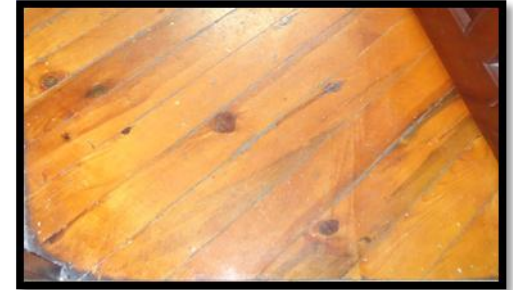
Resim 4.45. 1-06 mekânı zemin kaplaması [Gül, 2012]
