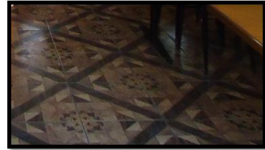
Resim 4.29. Z-05 mekânı zemin kaplaması [Gül, 2012]
