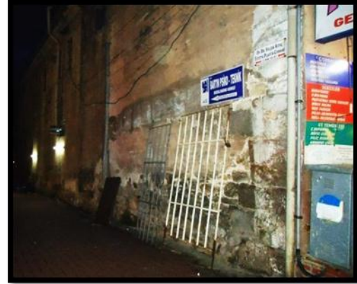
Resim 4.10. Güneydoğu cephesi [Gül, 2012]
