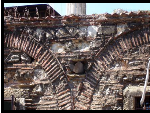
Resim 5.29. Varakçı Han duvar örgüsü [Akça, 2008]
