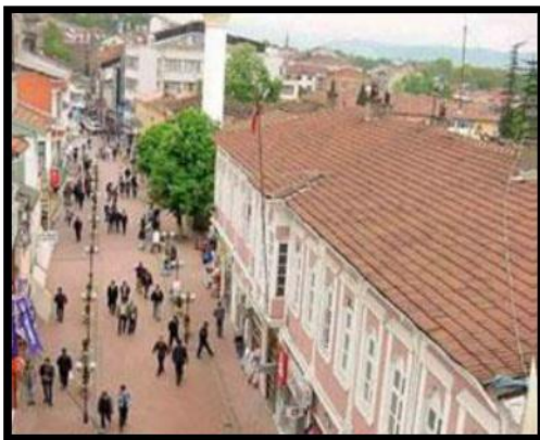
Resim 3.6. Eski belediye binası [44]
