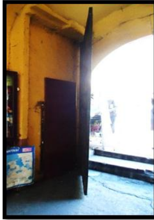
Resim 4.61. K2 kapısı sağ kanat [Gül, 2012]
