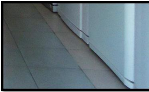
Resim 4.28. Z-04 mekânı zemin kaplaması [Gül, 2012]
