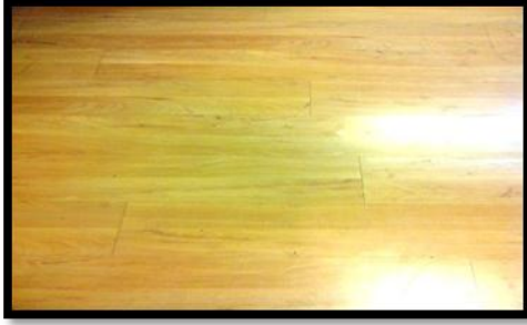
Resim 4.26. Z-01 mekânı zemin kaplaması [Gül, 2012]
