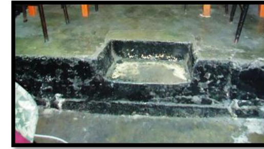
Resim 4.31. Z-06 mekânı zemin kaplaması [Gül, 2012]
