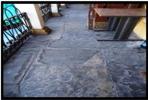
Resim 4.54. 1-14 mekânı zemin kaplaması [Gül, 2012]
