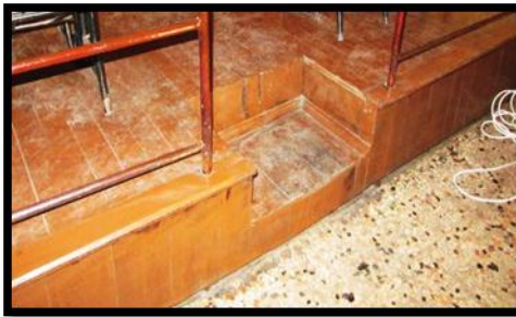
Resim 4.32. Z-07 mekânı zemin kaplaması [Gül, 2012]
