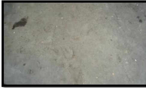
Resim 4.42. 1-03 mekânı zemin kaplaması [Gül, 2012]
