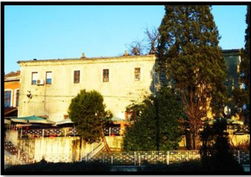
Resim 4.11. Güneybatı cephesi [Gül, 2012]
