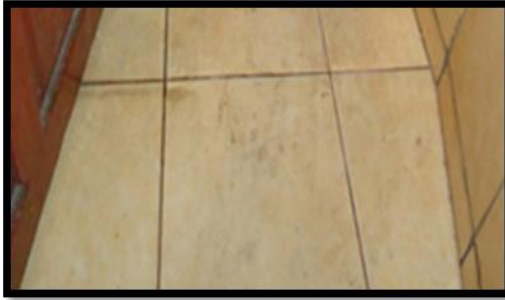
Resim 4.36. Z-07 mekânı zemin kaplaması [Gül, 2012]
