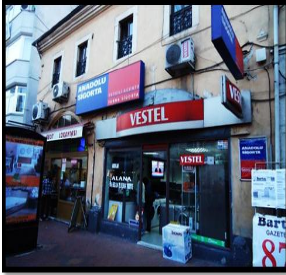
Resim 4.141. Kuzeydoğu cephesinde bozulmalar [Gül, 2012]
