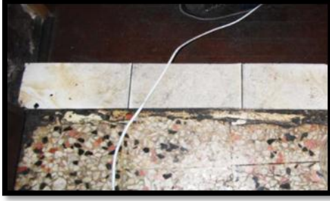
Resim 4.34. Z-05c mekânı zemin kaplaması [Gül, 2012]
