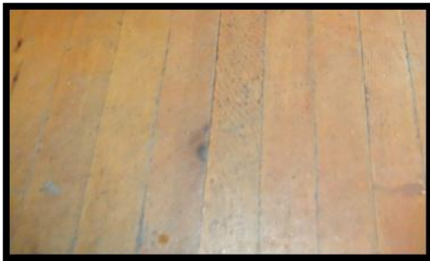
Resim 4.52. 1-12 mekânı zemin kaplaması [Gül, 2012]
