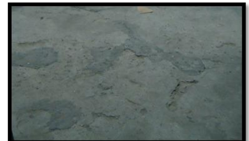
Resim 4.47. 1-08 mekânı zemin kaplaması [Gül, 2012]
