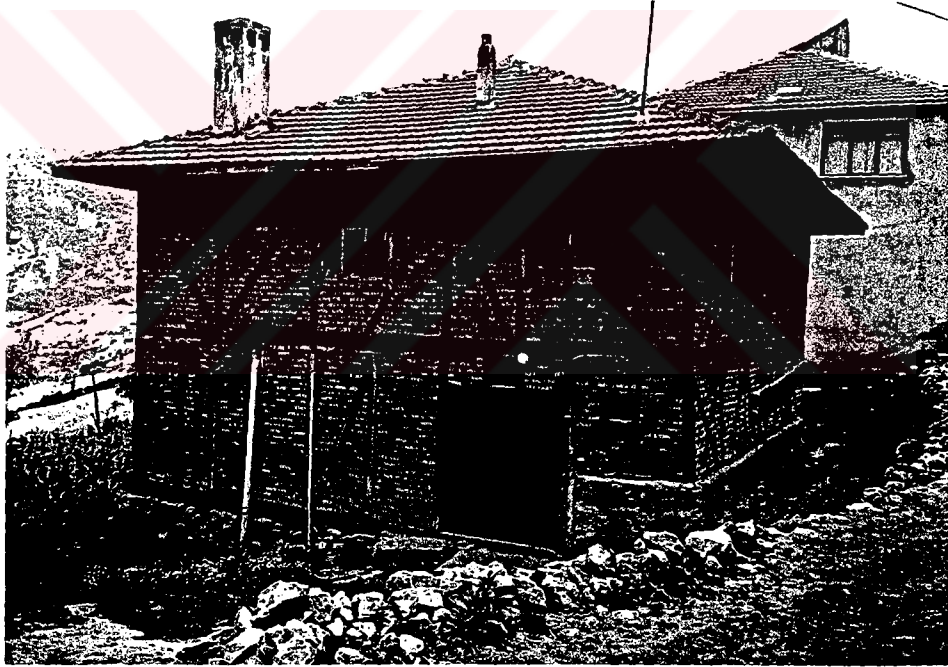
Foto: 27- Araştırma alanının doğusundaki dağlık kesimde yer alan Ören köyüne bağlı Sıralı mahallesinde ahşap iskeletin arasına tuğlaların doldurulması ile inşa edilmiş bir konut.
