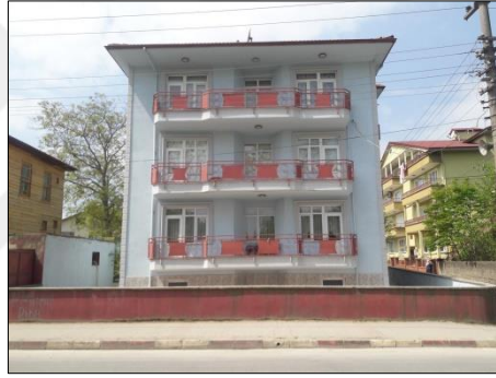
Şekil 4.34: Üç katlı yapı örneği (Orijinal, 2018).
