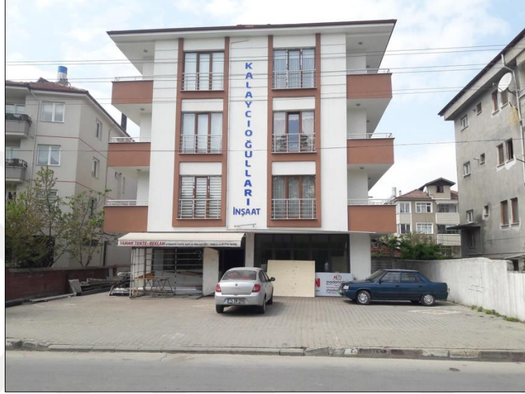
Şekil 4.44: Betonarme yapı örneği (Orijinal, 2018).
