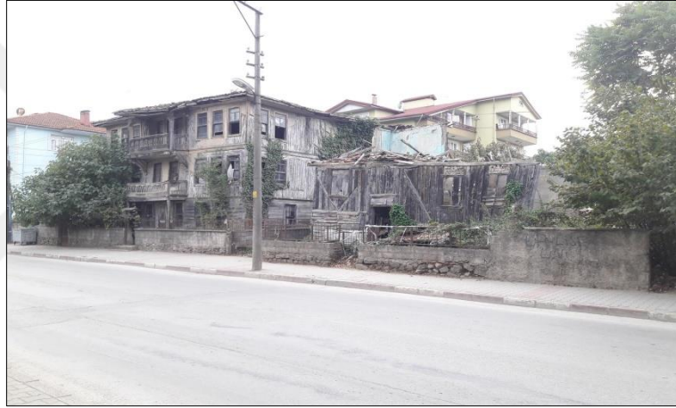
Şekil 4.47: Yıkılmış tescilli yapı örneği (Orijinal, 2018).
