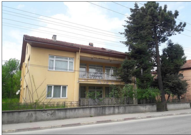
Şekil 4.38: Zemin kat konut kullanım durumu örneği (Orijinal, 2018).
