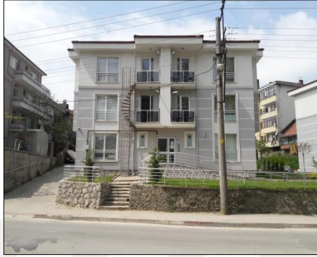
Şekil 4.40: “İyi” durumdaki yapı örneği (Orijinal, 2018).
