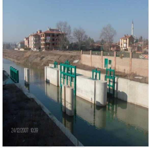
Ek 39: Porsuk Çayı Su Seviye Kontrol Yapısı
