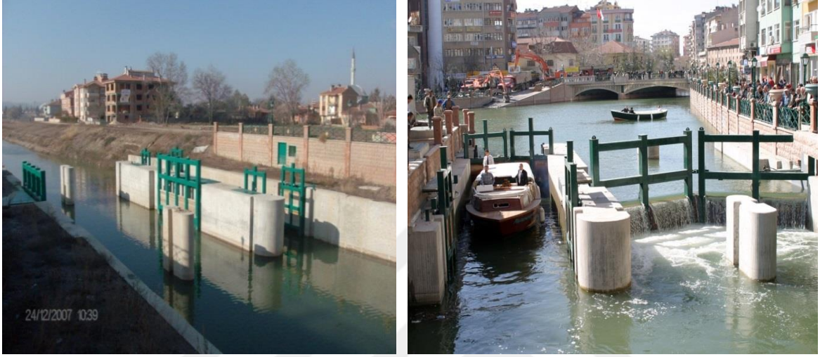
Şekil 34:Porsuk Çayı'nda Su Seviye Kontrol Yapıları
