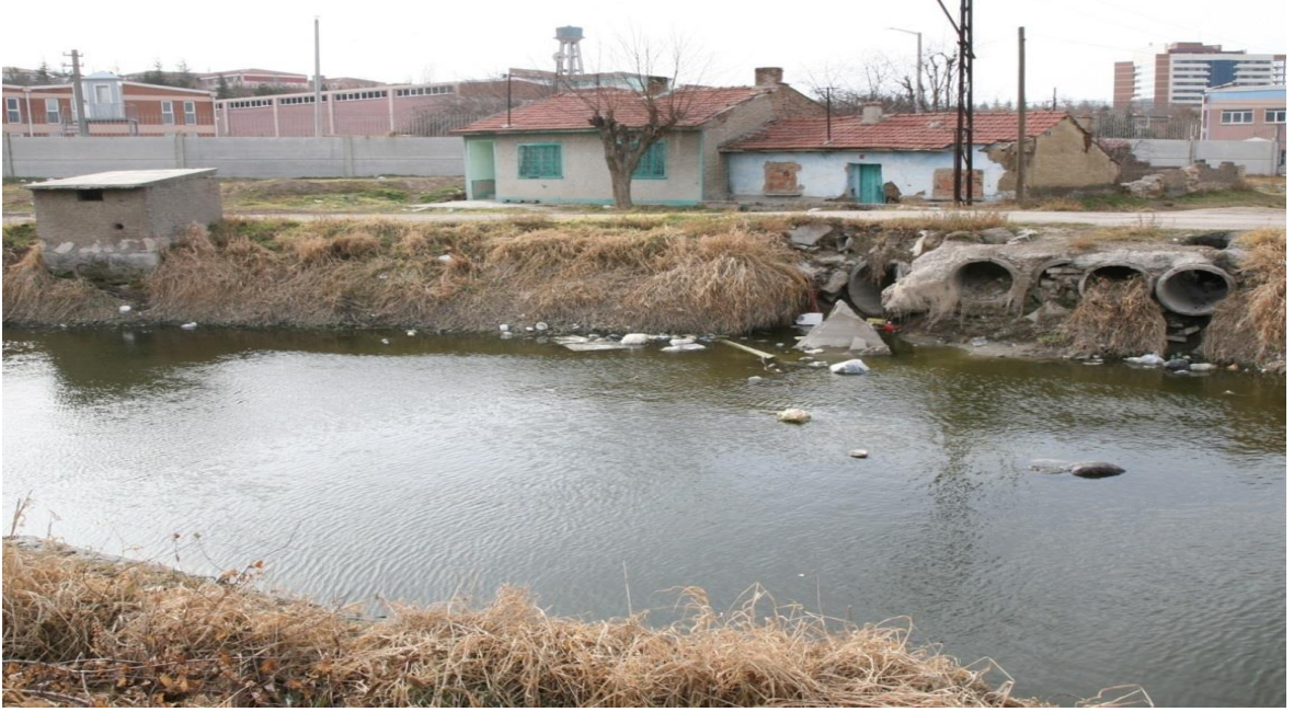
Şekil 33: Porsuk Çayı'nda Bulunan Eski Sulama Kanalları
