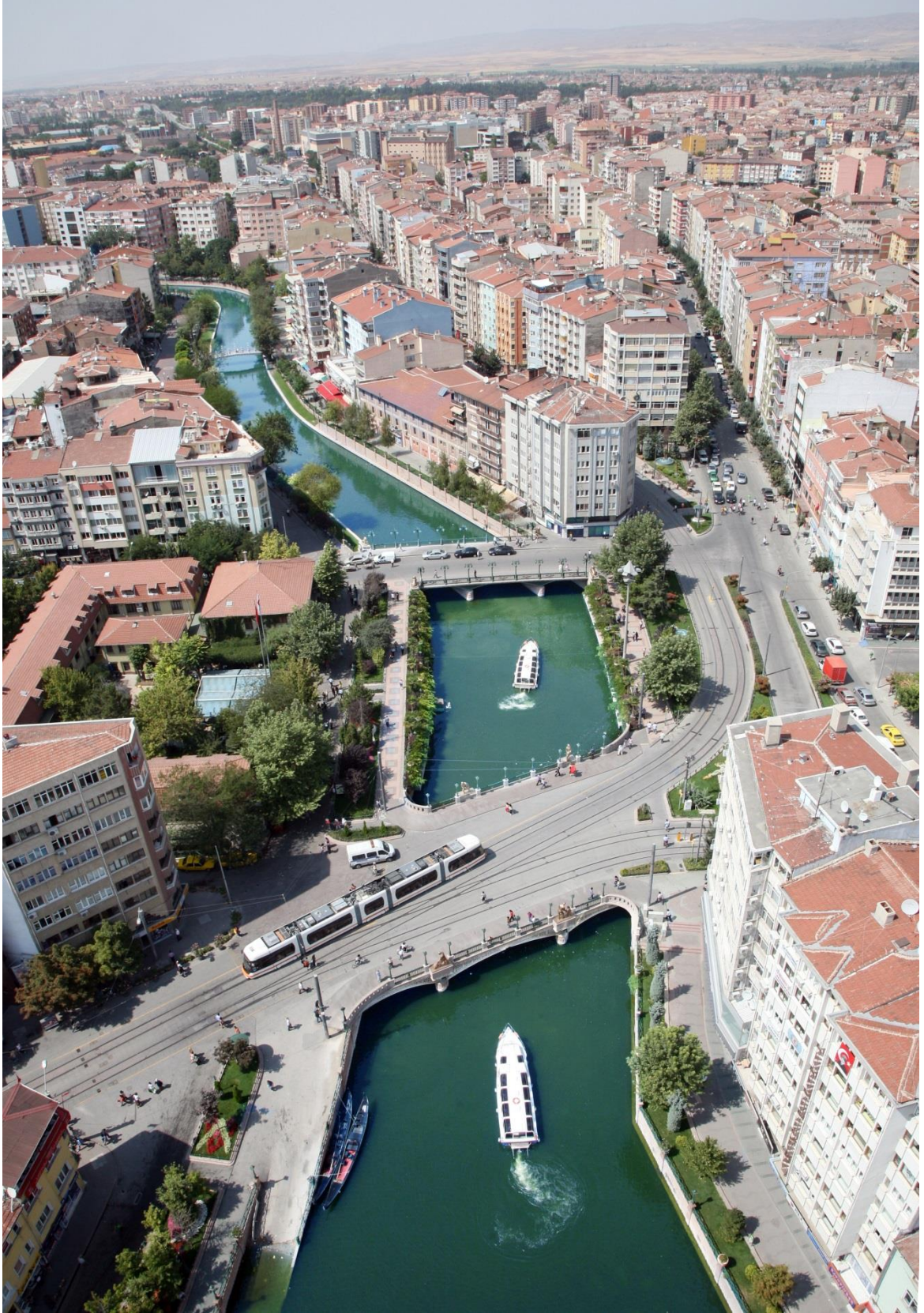
Kaynak: Eskişehir Büyükşehir Belediyesi.
