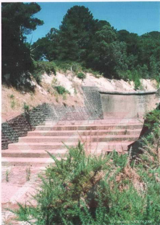
Şekil 4.7 Malmsbury Barajı - Avustralya
