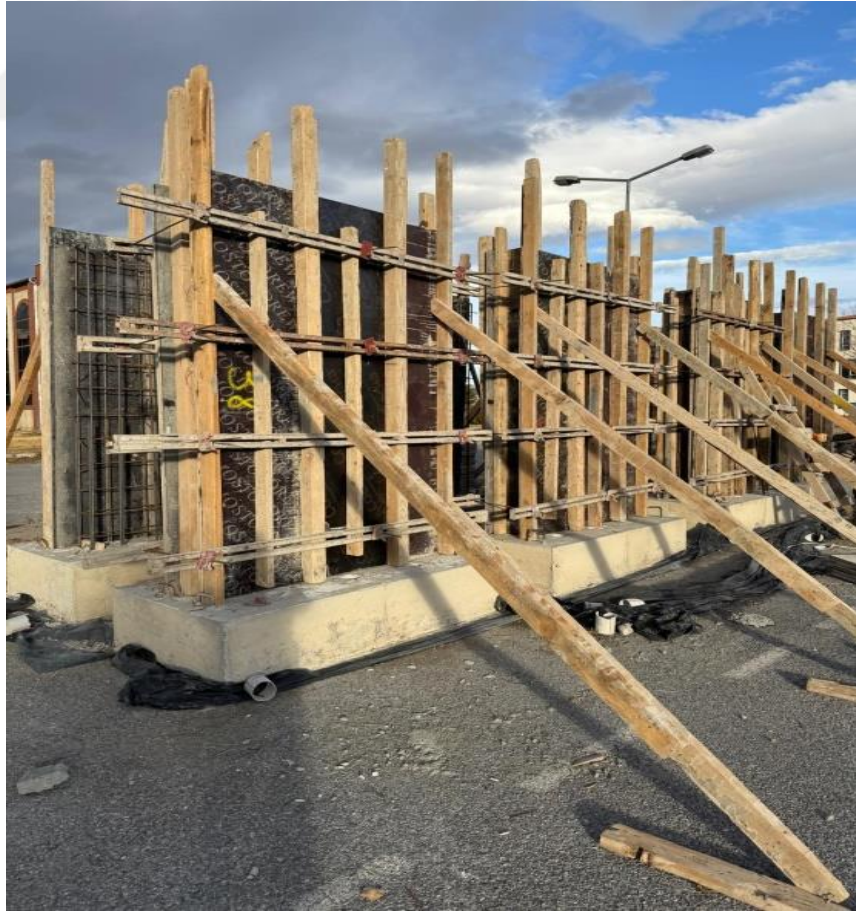
Şekil 22. Perde Kalıp İmalatı
