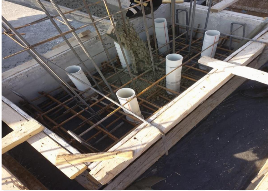
Şekil 16. Temel Beton Dökümü
