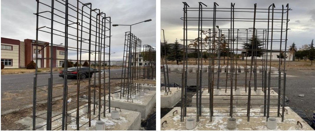
Şekil 21. Perde Donatı Yerleşimi
