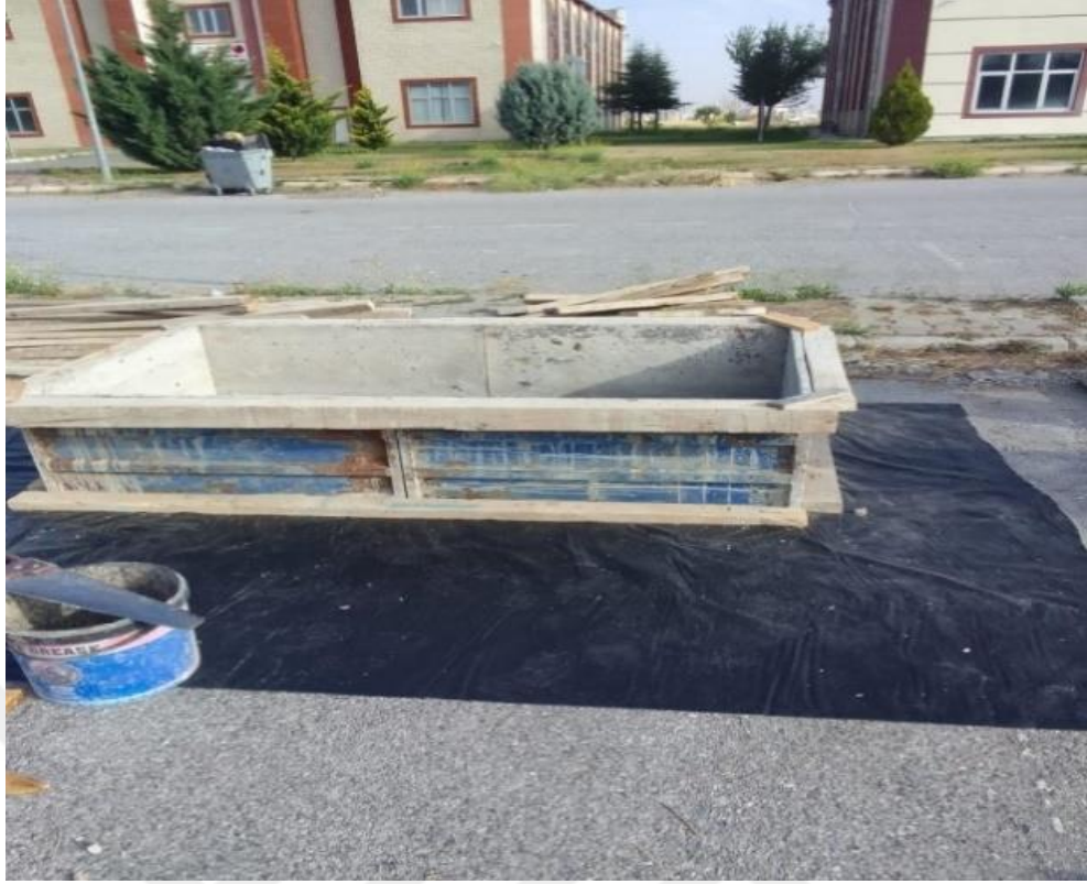
Şekil 14. Temel Kalıp İmalatı
