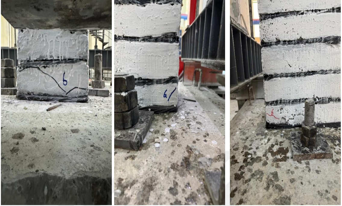
Şekil Ek2-1. 6. Adımda İlk Oluşan Çatlaklar
