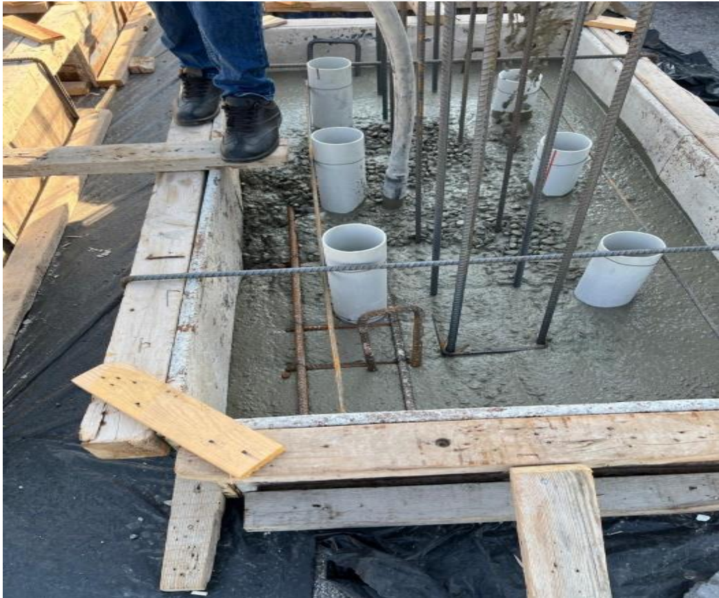
Şekil 19. Temel Beton Dökümü
