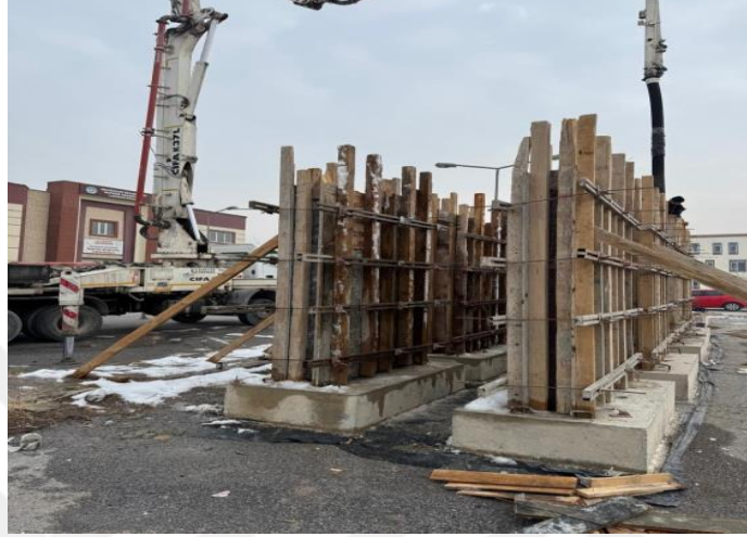
Şekil 23. Perde Beton Dökümü
