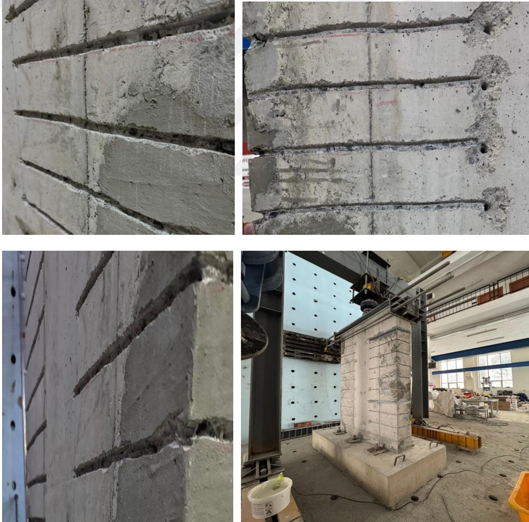
Şekil 40. CFRP Demet Uygulama Hazırlığı Görünümü
