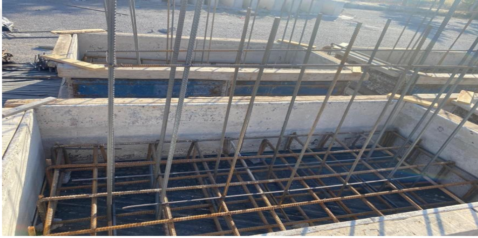
Şekil 15. Temel Donatı Yerleştirilmesi
