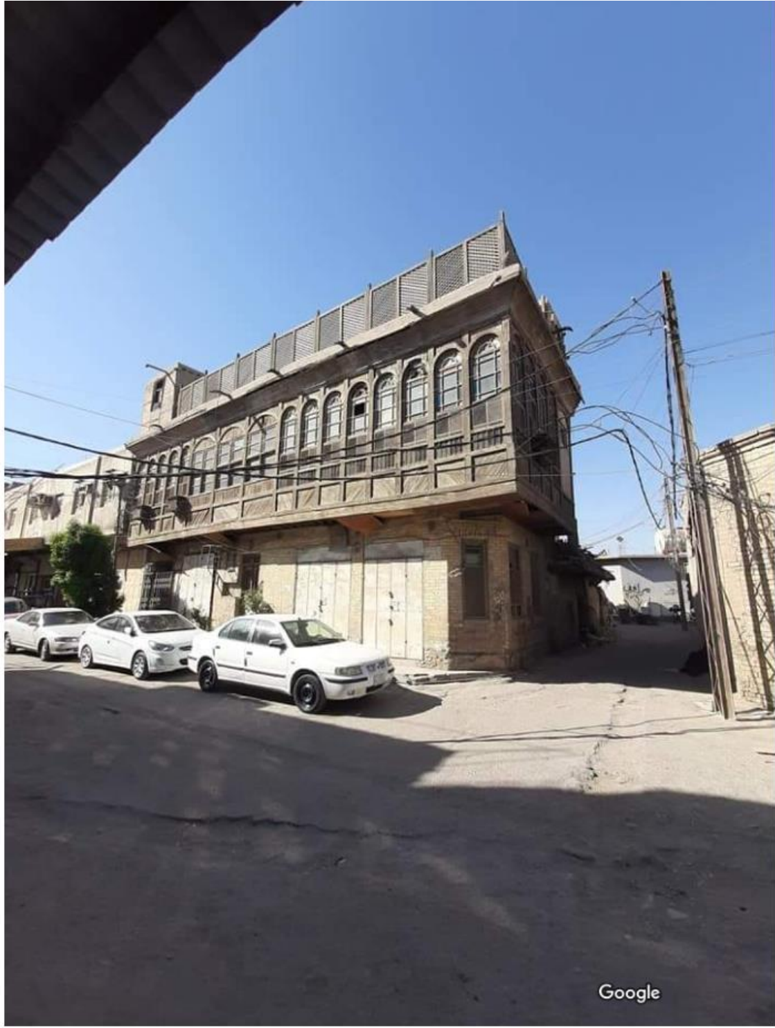
Ek 25. Kattane Camii dış cepheden görünüm 604 .
