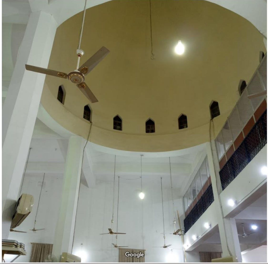
Ek 14. Cezire/Kuds Camii kubbesinin içten görünümü 593 .
