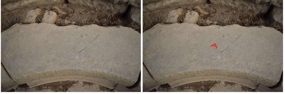
Şekil 4.32 Küçük eksedra elemanlarında sıralama belirten A harfli taşçı işareti (Kişisel arşiv, 2017)
