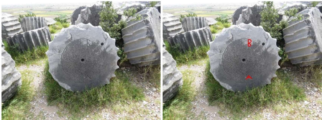
Şekil 2.29 Priene Athena Tapınağı sütun tamburlarında yerleştirme yönlerini gösteren izler (Kişisel arşiv, 2016)
