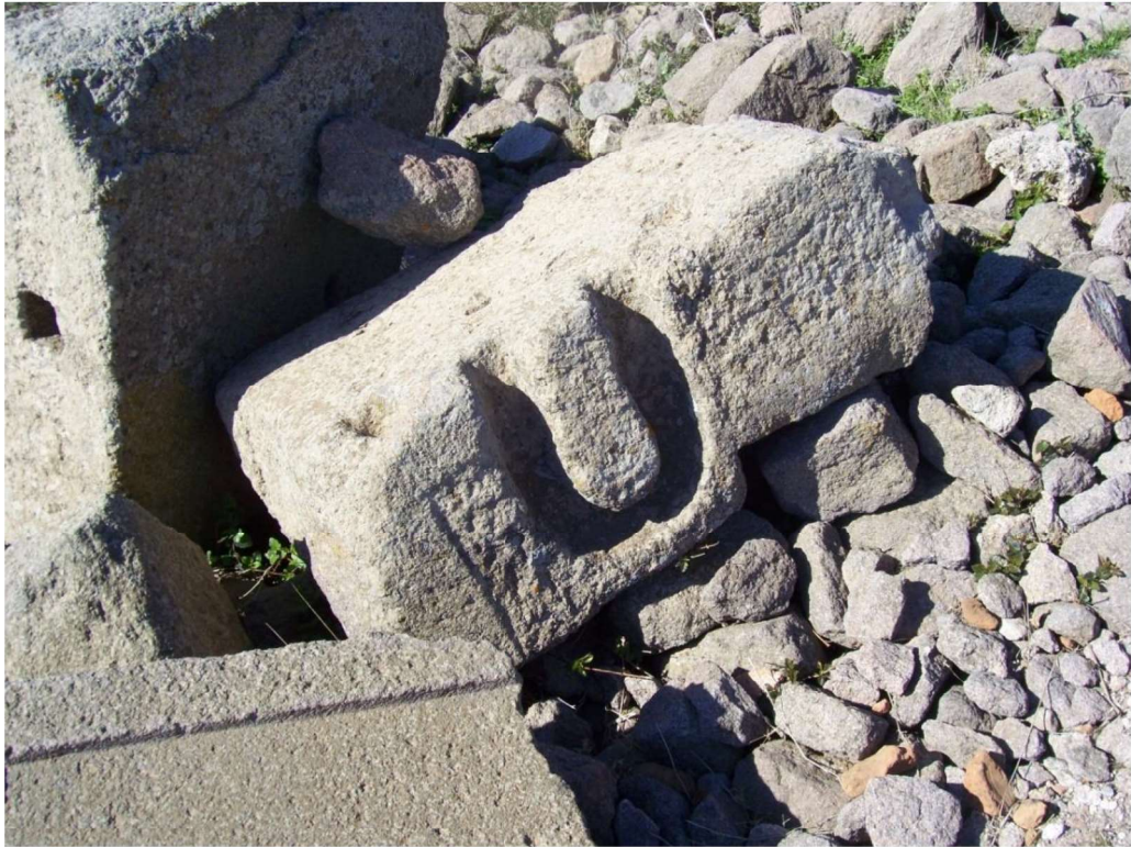
Şekil 2.8 Assos Athena Tapınağı'nda yan U oluk izinin görüldüğü bir mimari eleman (H. İbrahim Alpaslan kişisel arşivi, 2004)
