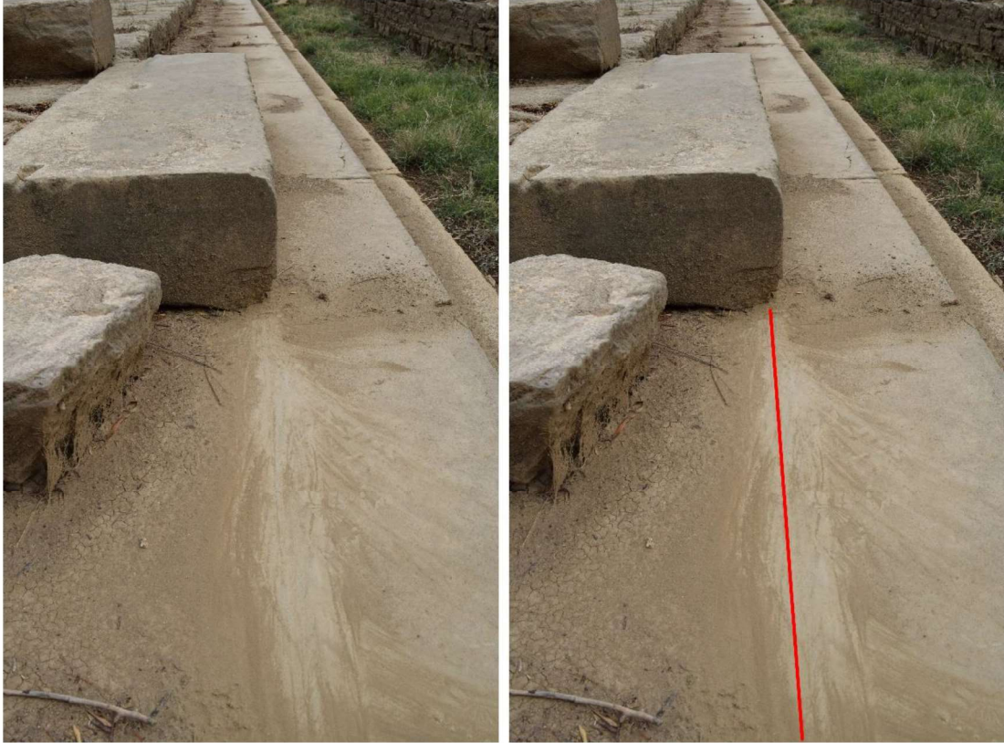
Şekil 4.39 Krepis bloklarında gözlemlenen yerleştirme çizgileri (Kişisel arşiv, 2017)
