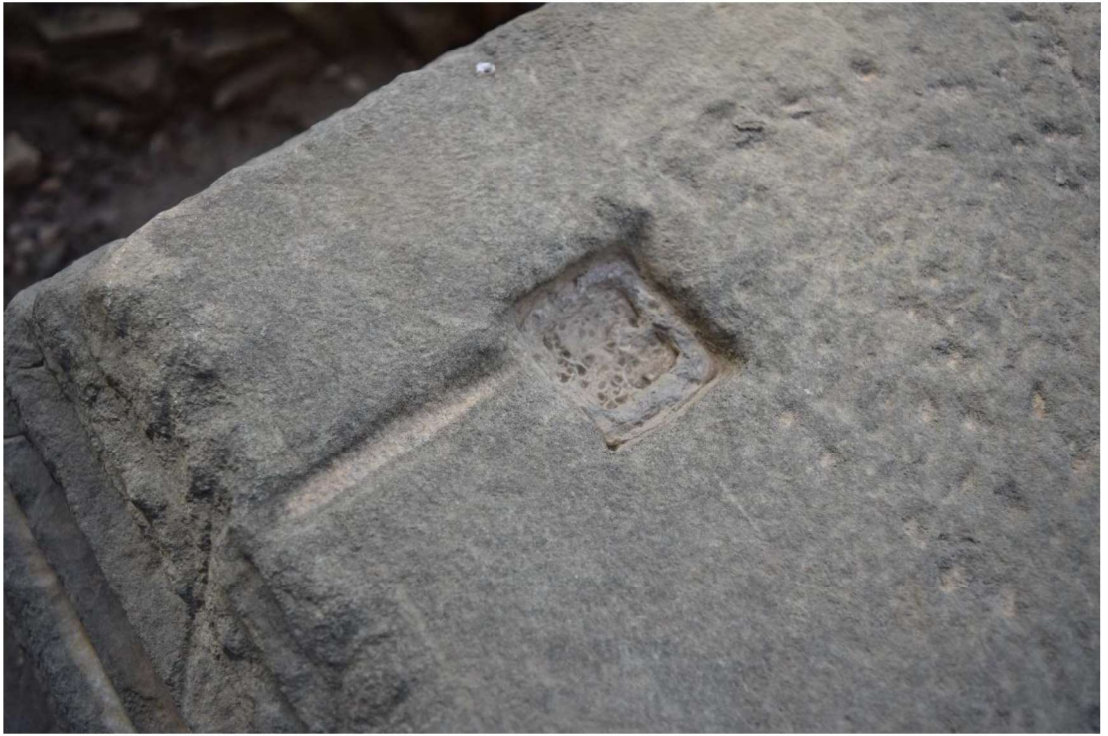
Şekil 4.11 Büyük Eksedra’da gözlemlenen zivana elemanı ve akıtma kanalına ait izler (Kişisel arşiv, 2017)
