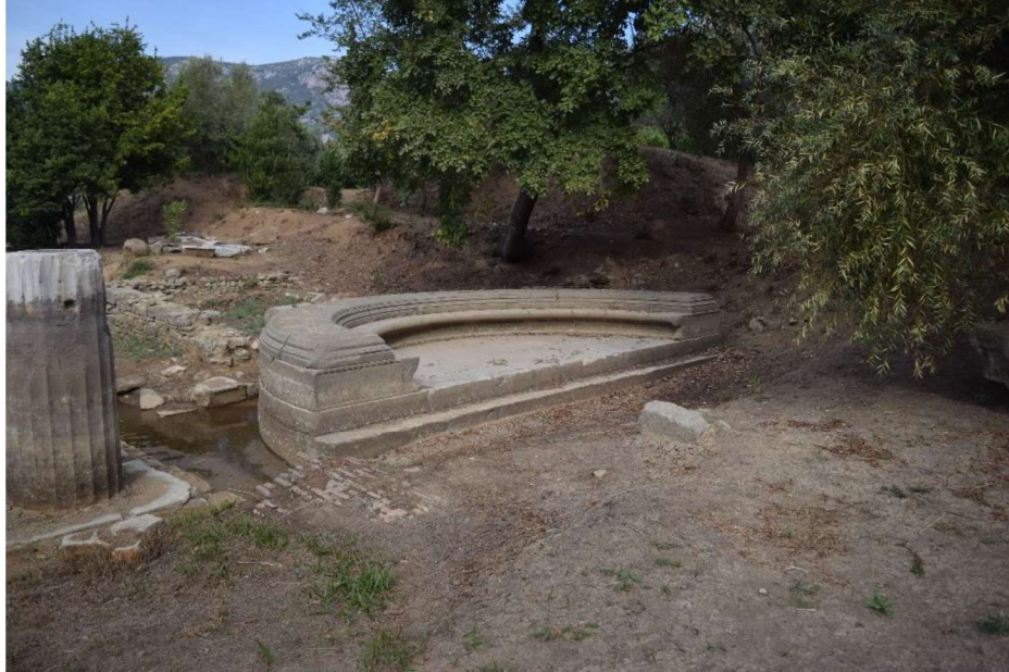
Şekil 4.5 Büyük Eksedra yapısının görünüşü (Kişisel arşiv, 2017)
