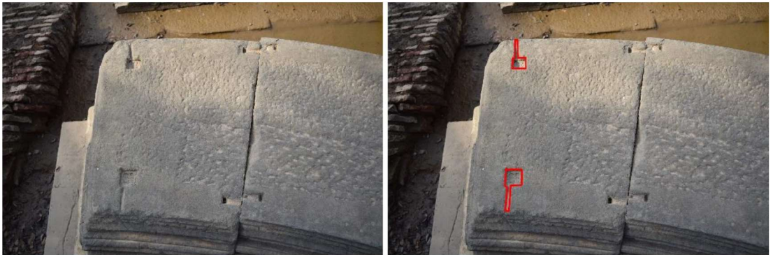
Şekil 4.9 Büyük Eksedra’da gözlemlenen zıvana yuvası ve akıtma kanalı izleri (Kişisel arşiv, 2017)
