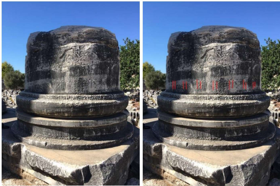
Şekil 2.24 Didyma Apollon tapınağı sütununda görülen açılacak olan yivlerin konumlarını gösteren çizgiler (H. İbrahim Alpaslan kişisel arşivi, 2017)
