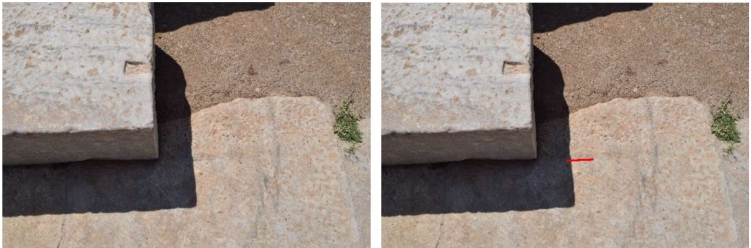
řekil 2.23 Sardis Artemis tapınaęı basamaklarında grlen yerleřtirme izgileri (Kiřisel arřiv, 2016)
