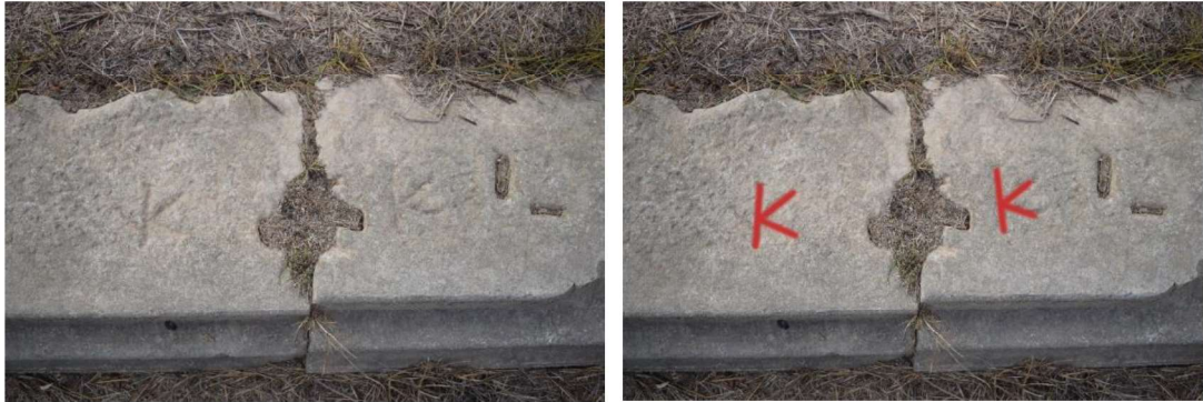
Şekil 2.27 Klaros Artemis Sunağı taşlarının birleşimi için kazınmış taşçı işaretleri (Kişisel arşiv, 2016)
