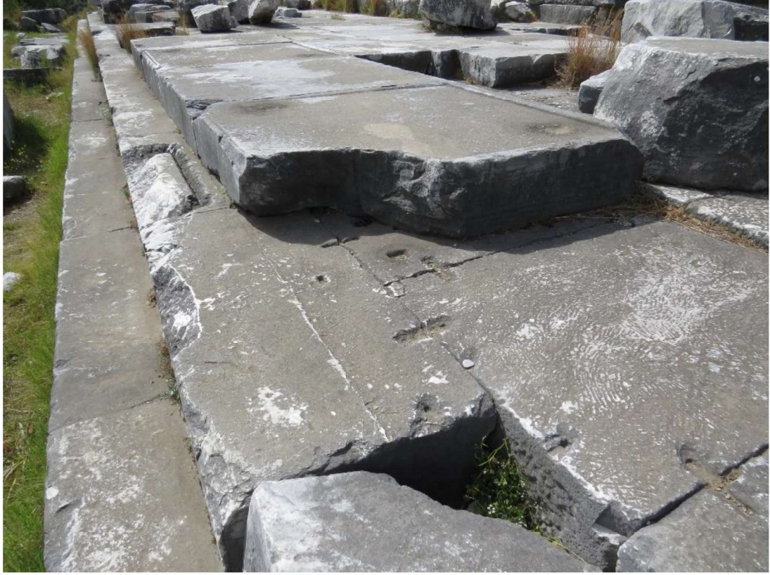
Şekil 3.1 Priene Athena tapınağı stylobat hizasının altında ortaya çıkmış vaziyette bulunan taş elemanlarda bağlantı ve yerleştirme çizgileri (Kişisel arşiv, 2016)
