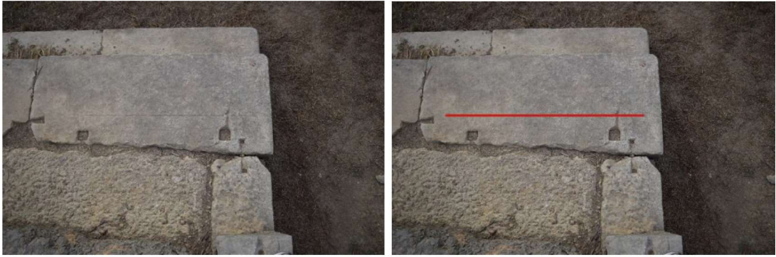
řekil 2.22 Klaros Apollon Sunaęı basamaklarında grlen yerleřtirme izgileri (Kiřisel arřiv, 2016)
