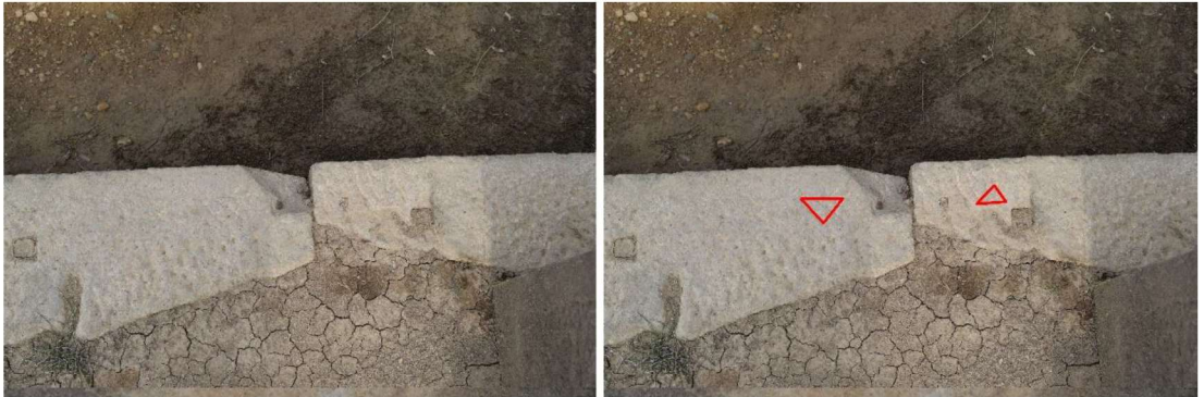
Şekil 4.28 Apollon Sunağı basamaklarında görülen \Delta - \Delta birleşimini gösteren taşçı işaretleri (Kişisel arşiv, 2017)
