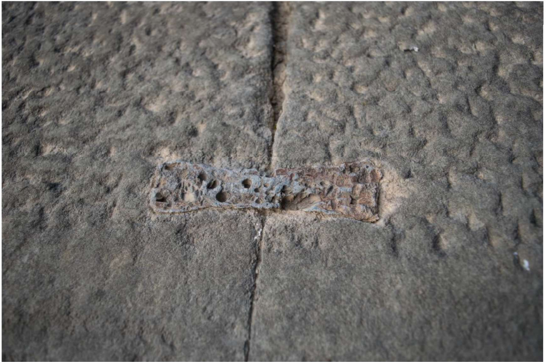
Şekil 4.8 Büyük Eksedra’da gözlemlenen kenet ve kurşun kalıntısı (Kişisel arşiv, 2017)
