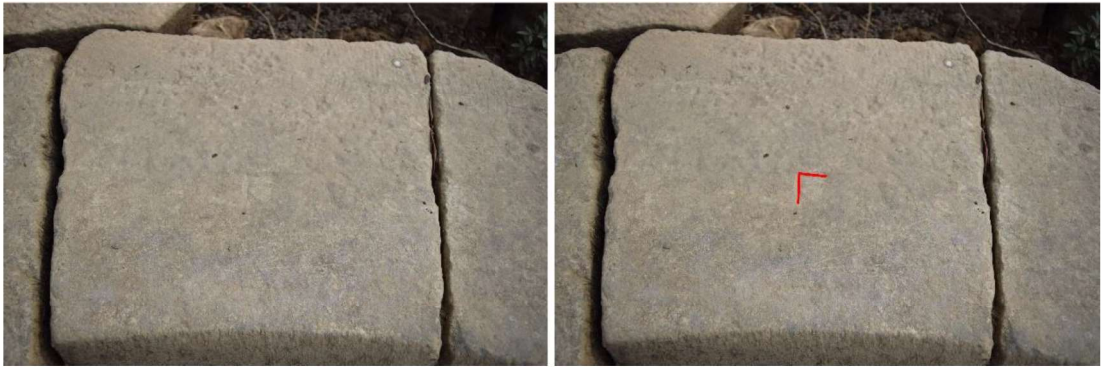
Şekil 4.34 Küçük eksedra elemanlarında sıralama belirten \Gamma harfli taşçı işareti (Kişisel arşiv, 2017)
