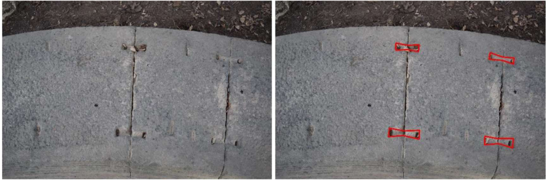
Şekil 4.6 Büyük Eksedra’da gözlemlenen kırlangıç kuyruğu biçimli kenet izleri (Kişisel arşiv, 2017)
