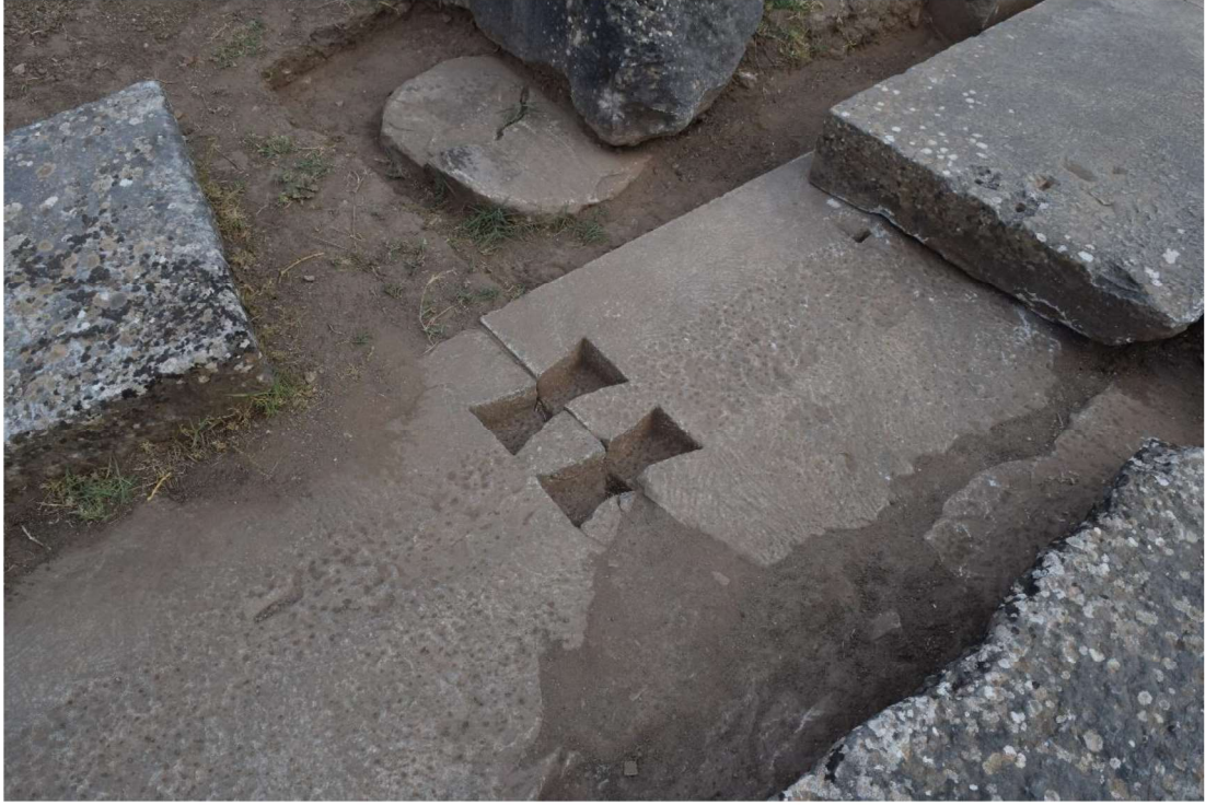
Şekil 2.17 Euromos Zeus tapınağında gözlemlenen kırkangıç kuyruğu kenet izleri (Kişisel arşiv, 2016)
