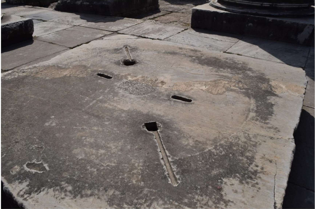
Şekil 2.20 Didim Apollon tapınğı sütun kaidesinde görülen zıvana ve akıtma kanalı izleri (Kişisel arşiv, 2016)
