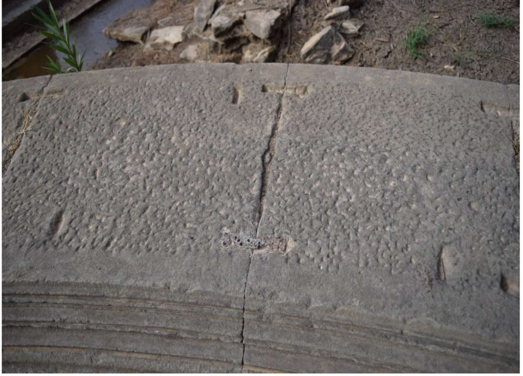
Şekil 2.18 Klaros Exedra yapısında görülen bağlantı izleri (Kişisel arşiv, 2016)
