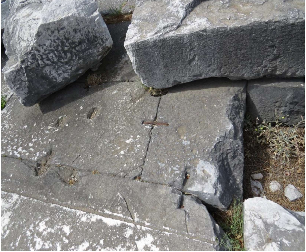
Şekil 2.19 Priene Athena Tapınağında görülen bağlantı izleri (Kişisel arşiv, 2016)
