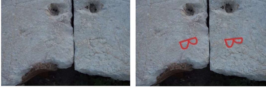
Şekil 2.28 Knidos'ta bir mimari elemanın birleşimi için kazınmış taşçı işaretleri (Kişisel arşiv, 2016)
