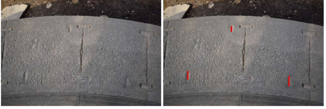
Şekil 4.12 Büyük Eksedra’da gözlemlenen küskü yuvası izleri (Kişisel arşiv, 2017)
