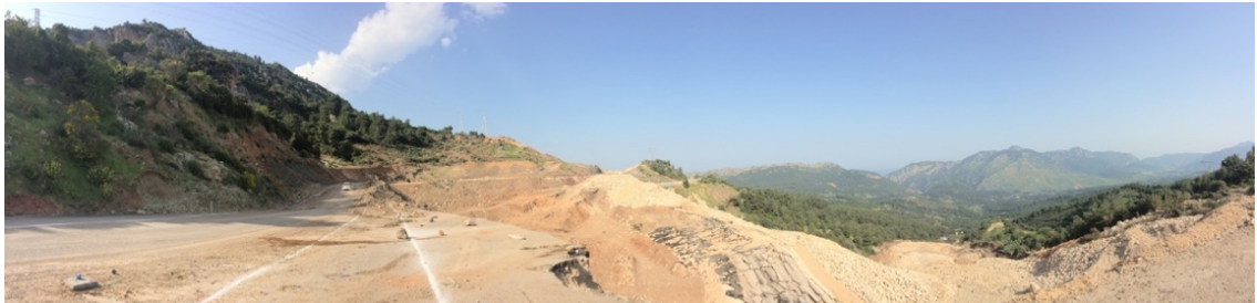
Şekil 4.2. 25 Şubat 2018 tarihinde Yenbey Mevki’ndeki heyelanın yarattığı tahrip
