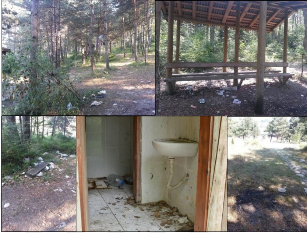
Şekil 13: Bolu Kent Ormanı'ndaki hasarlar.
