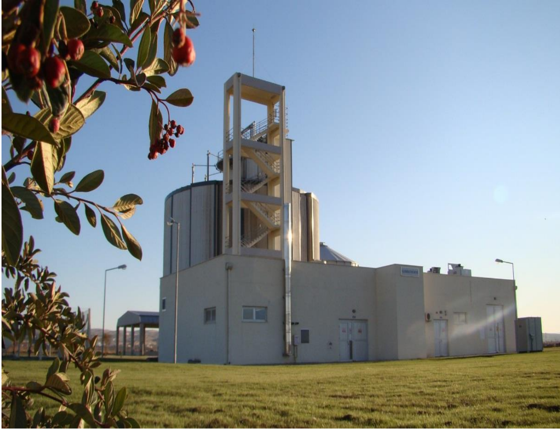
Şekil 5.1. Batman belediyesi atık su arıtma tesisi (AAT)
