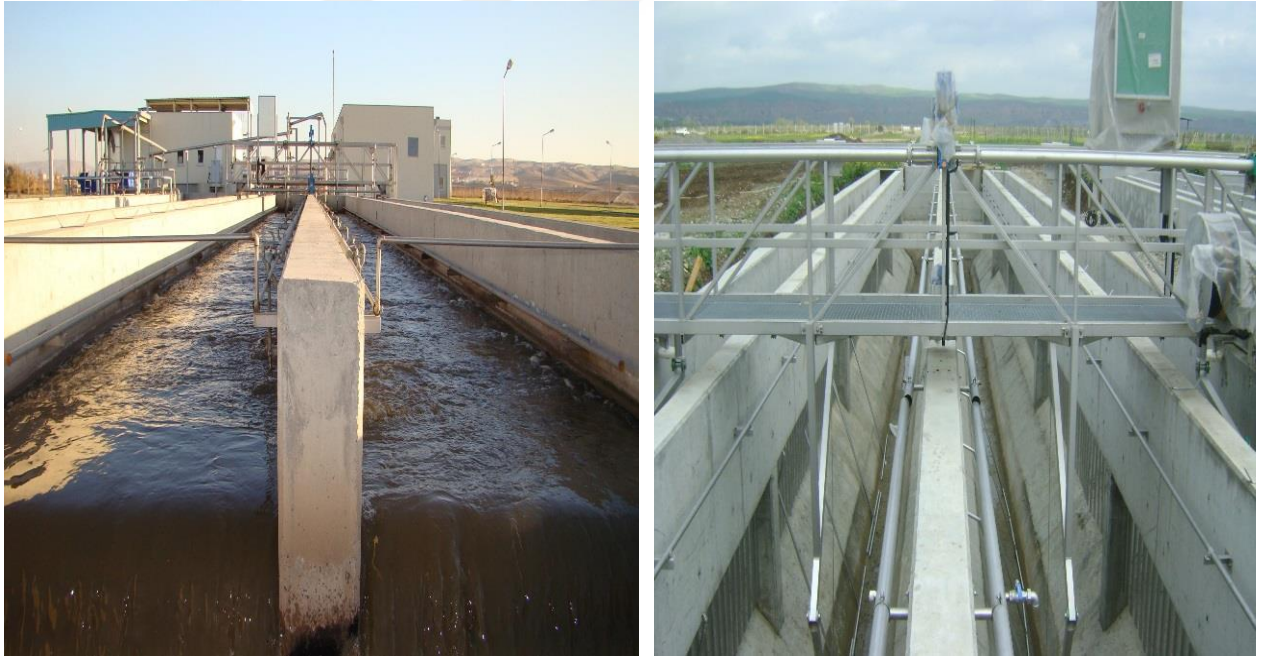
Şekil 5.6. Kum ve yağ tutucu ünitesi
