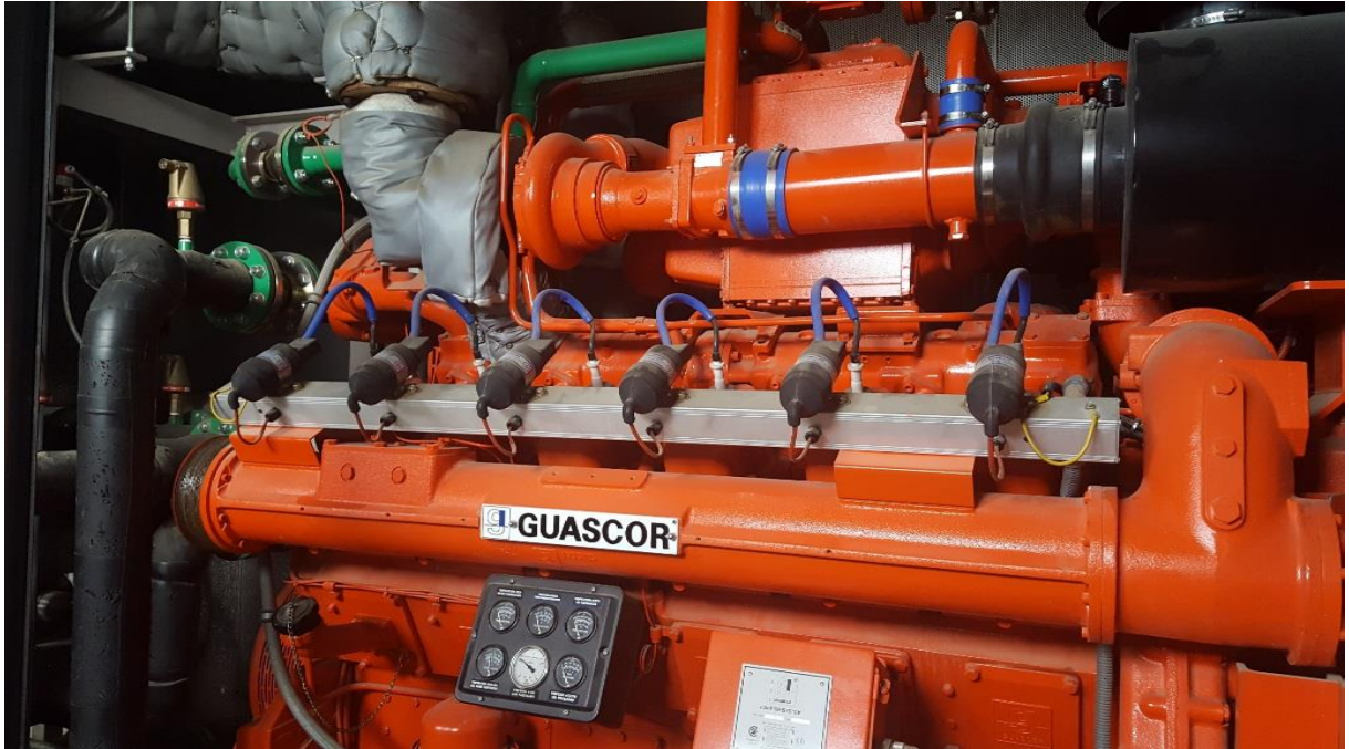
Şekil 5.15. GUASCOR FGLD 360 tipinde biyogaz yakıtlı gaz motoru
