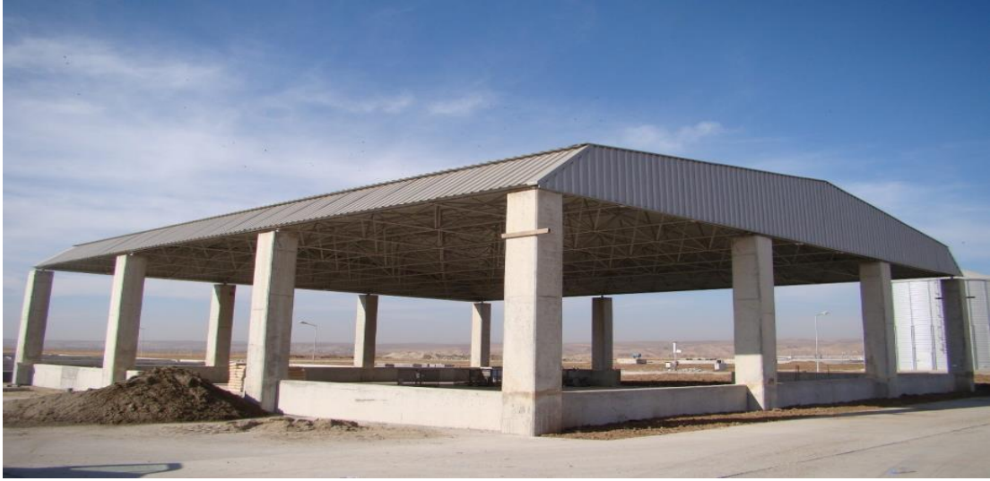
Şekil 5.13.Kurutulmuş çamur toplama deposu
