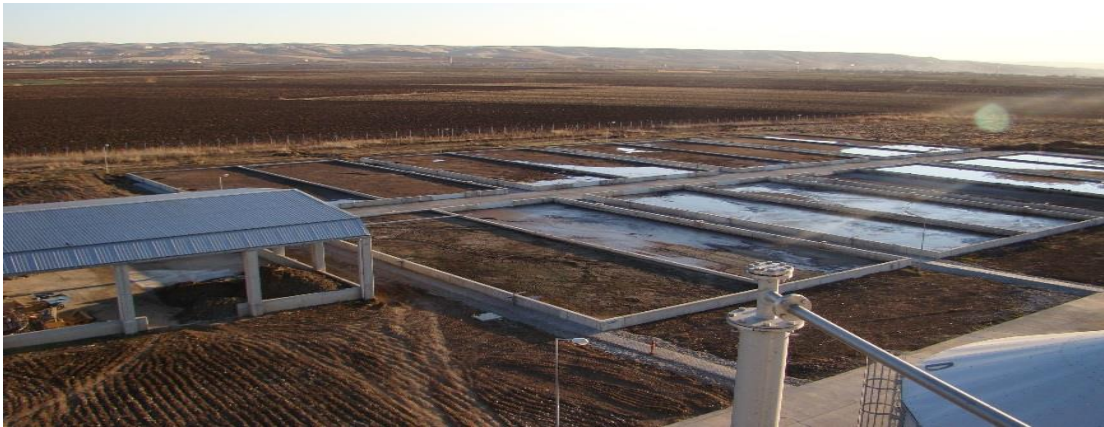
Şekil 5.12. Çürütülmüş çamur kurutma yatakları
