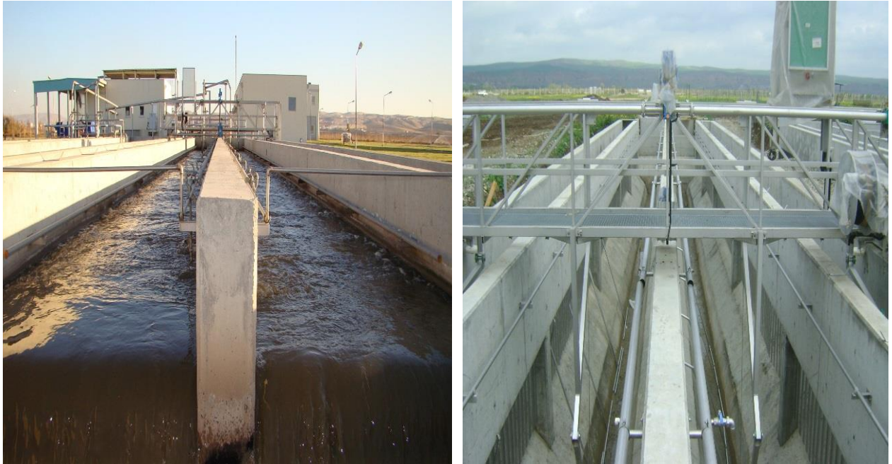
Şekil 5.6. Kum ve yağ tutucu ünitesi
