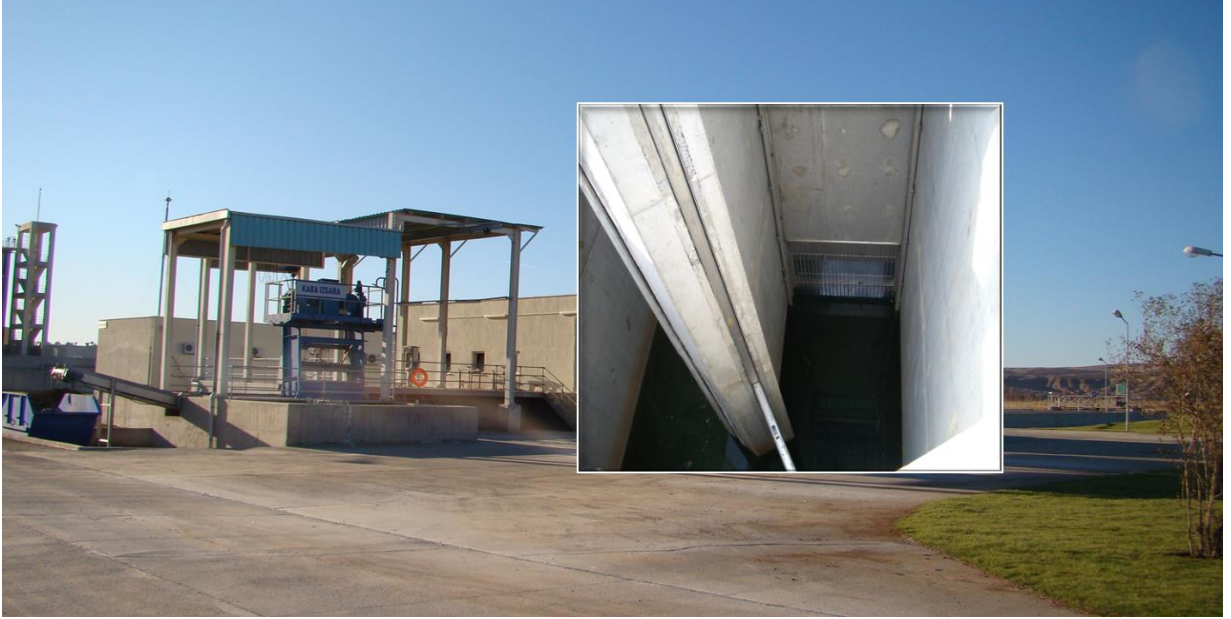
Şekil 5.4. Kaba ızgara ünitesi
