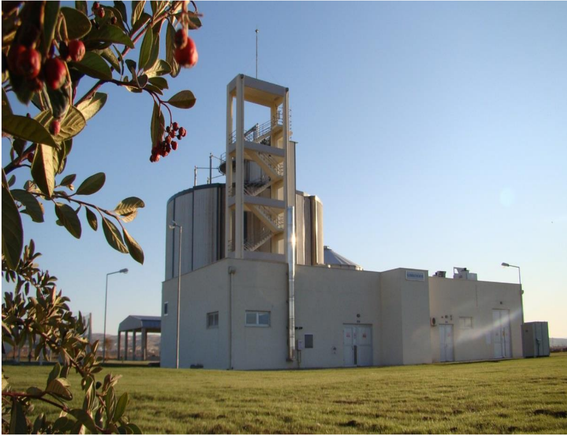
Şekil 5.1. Batman belediyesi atık su arıtma tesisi (AAT)
