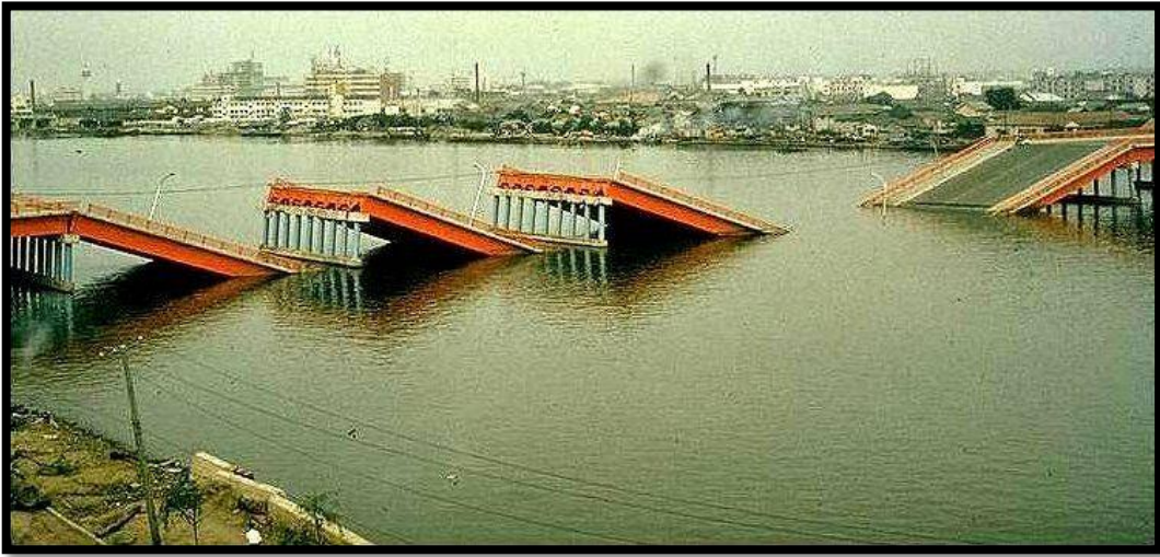
Şekil 4.10. 16 Haziran 1964 Niigata (Japonya) depremi sırasında çöken Showa Köprüsü. (Fotoğraf: EERC, University of California, Berkeley’deki Godden Collection’den) ( https://www.usgs.gov/science-explorer-results?es=liquefaction )
