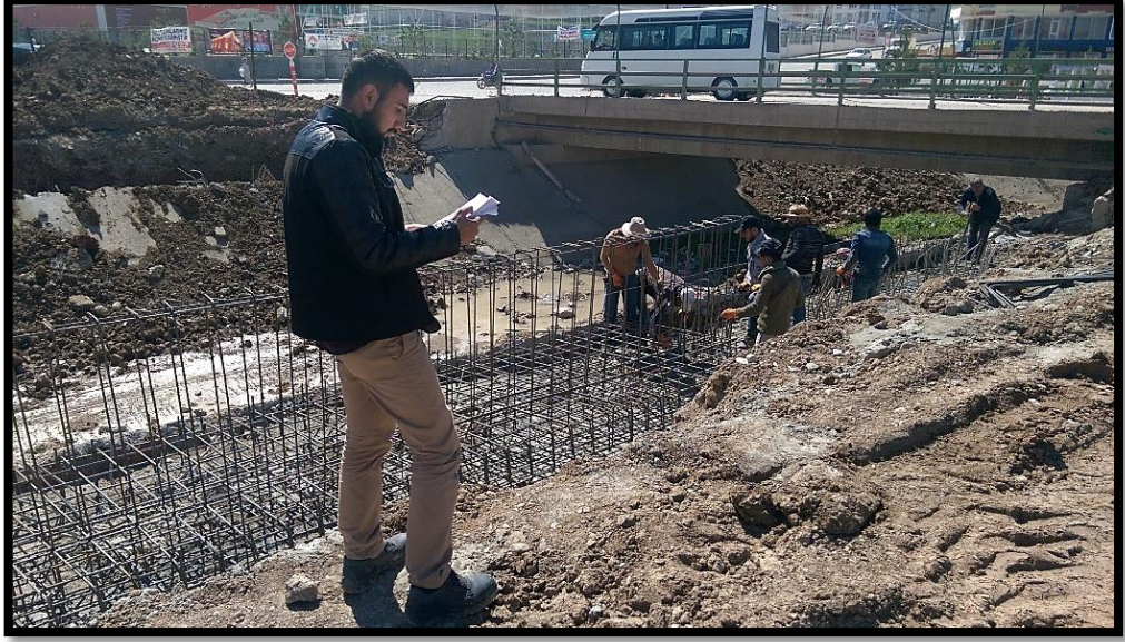
Şekil 5.25. Fore Kazık filizlerinin Temelle birleştirilmesi.
