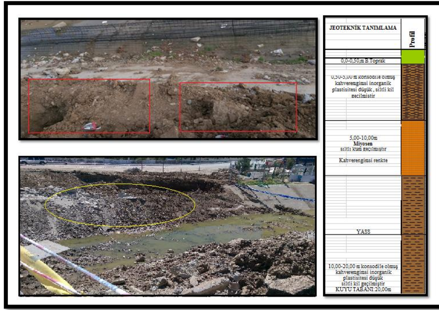
Şekil 5.3. İnceleme alanındaki zemin görünümü ve zemin profili.
