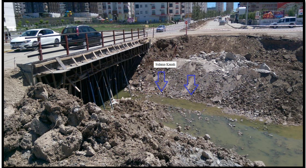
Şekil 5.2. İnceleme alanında bulunan sulama kanalı
