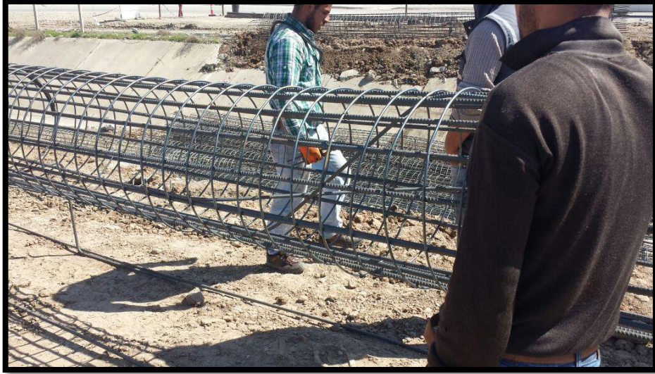
Şekil 5.23. Daire kesitli donatılar.
