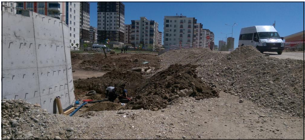
Şekil 5.4. İnceleme alanında yapılan istinat duvarı görüntüsü.
