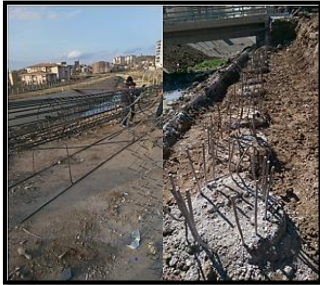
Şekil 5.24. Baca kazılarının içine yerleştirilmiş donatılar.
