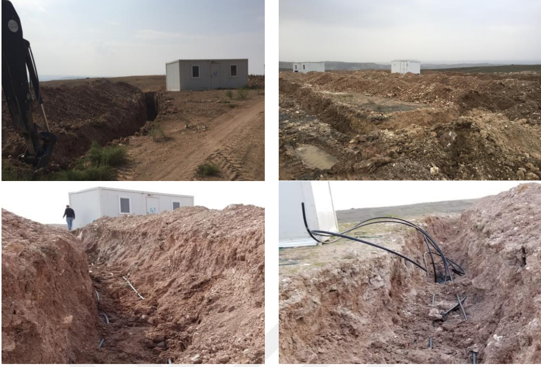
Şekil 3.5. Konteyner kurulumu ve toprak ısı değıştirgeci yapım aşamaları
