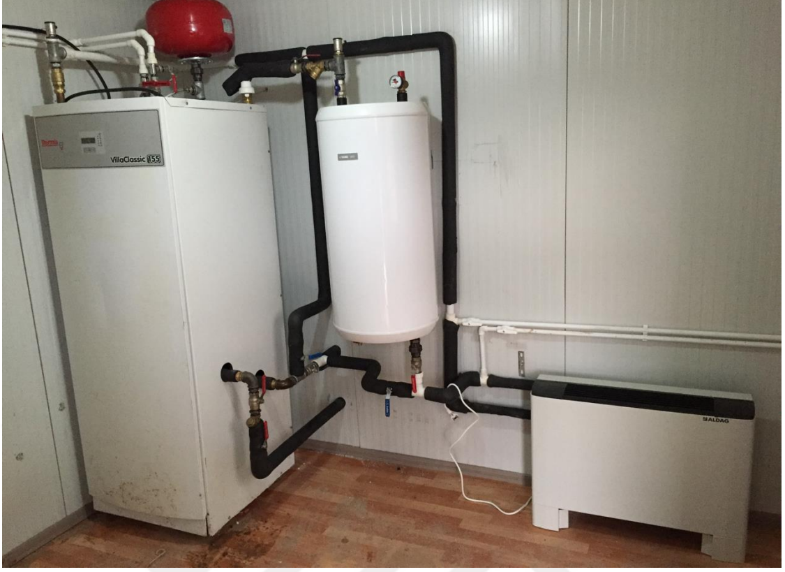
Şekil 3.8. Isı pompası sistemi
