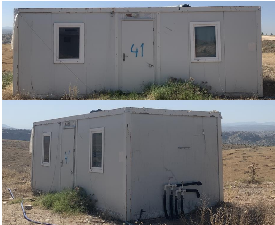
Şekil 3.4. Konteyner kurulumu ve toprak ısı değiştirgeci yapım aşamaları
