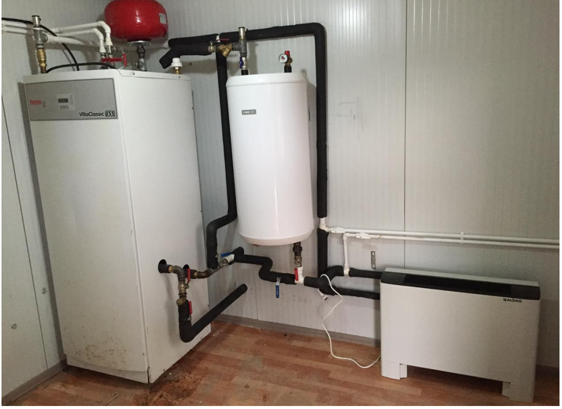
Şekil 3.8. Isı pompası sistemi
