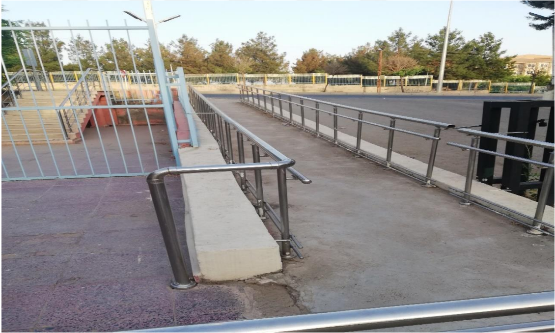
Resim 5.2. Kamu spor tesisinde erişilebilir bina giriş düzenlemesi örneği
