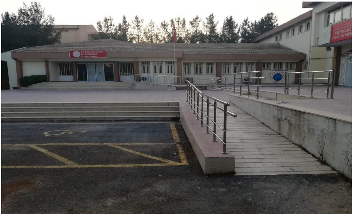
Resim 5.1. Kamu spor tesisinde erişilebilir otopark düzenlemesi örneği
