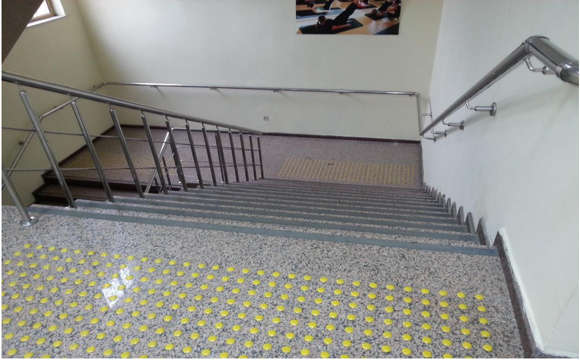
Resim 5.8. Kamu spor tesisinde erişilebilir merdiven düzenlemesi örneği
