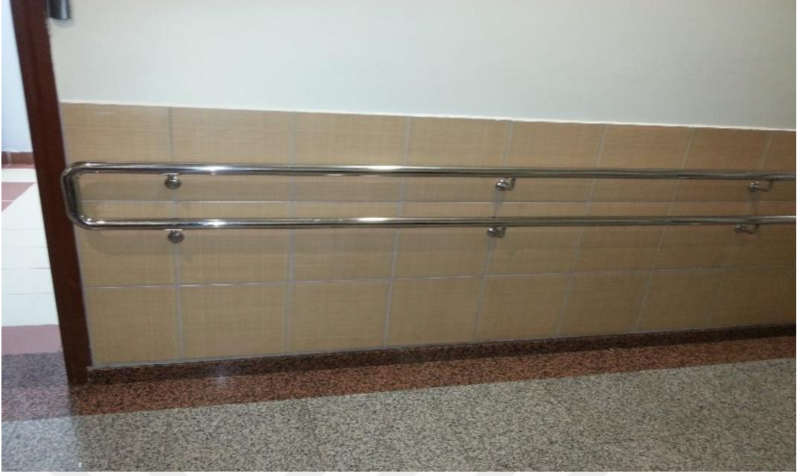
Resim 5.5. Kamu spor tesisinde erişilebilir koridor düzenlemesi örneği
