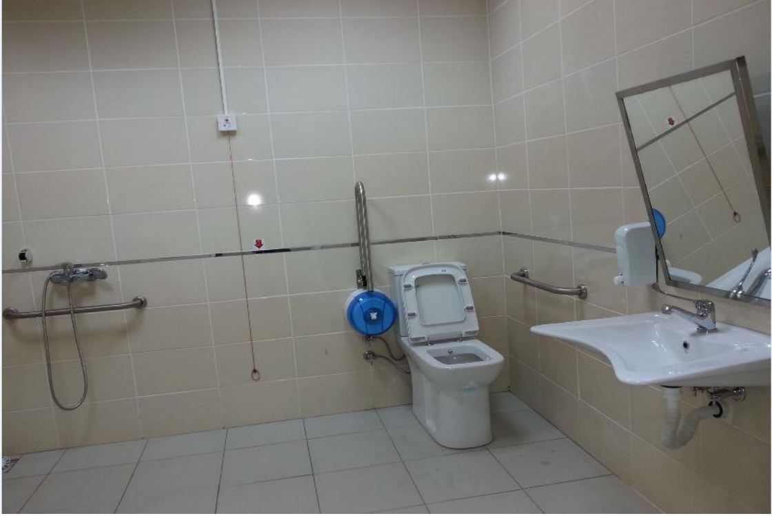
Resim 5.4. Kamu spor tesisinde erişilebilir tuvalet düzenlemesi örneği
