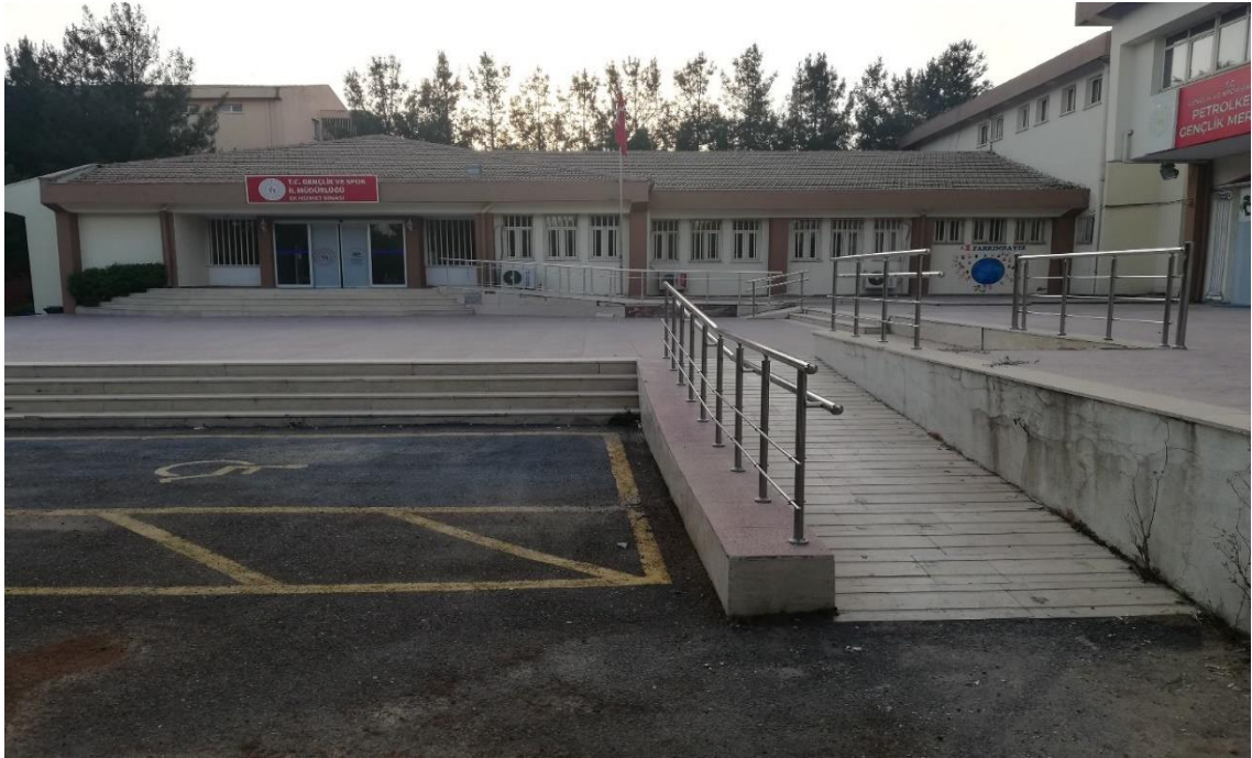
Resim 1: Kamu spor tesisinde erişilebilir otopark düzenlemesi örneği
