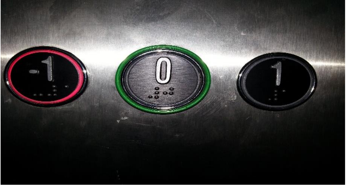
Resim 7: Asansör kabin içi Braille alfabesi örneği
