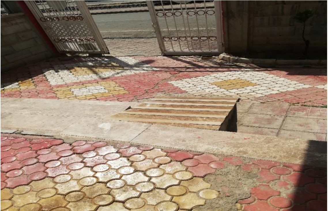
Resim 3: Erişilebilir standartlarına uygun olmayan rampa örneği
