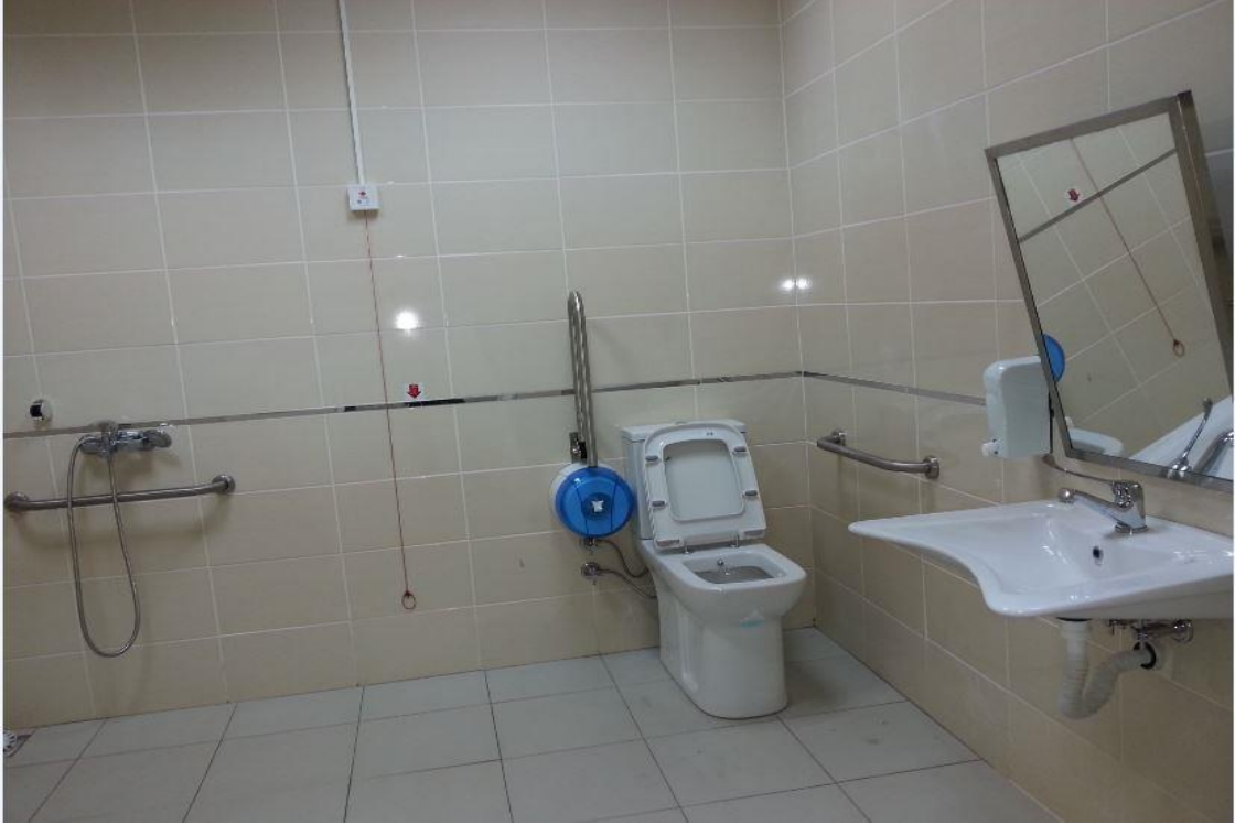
Resim 4: Kamu spor tesisinde erişilebilir tuvalet düzenlemesi örneği
