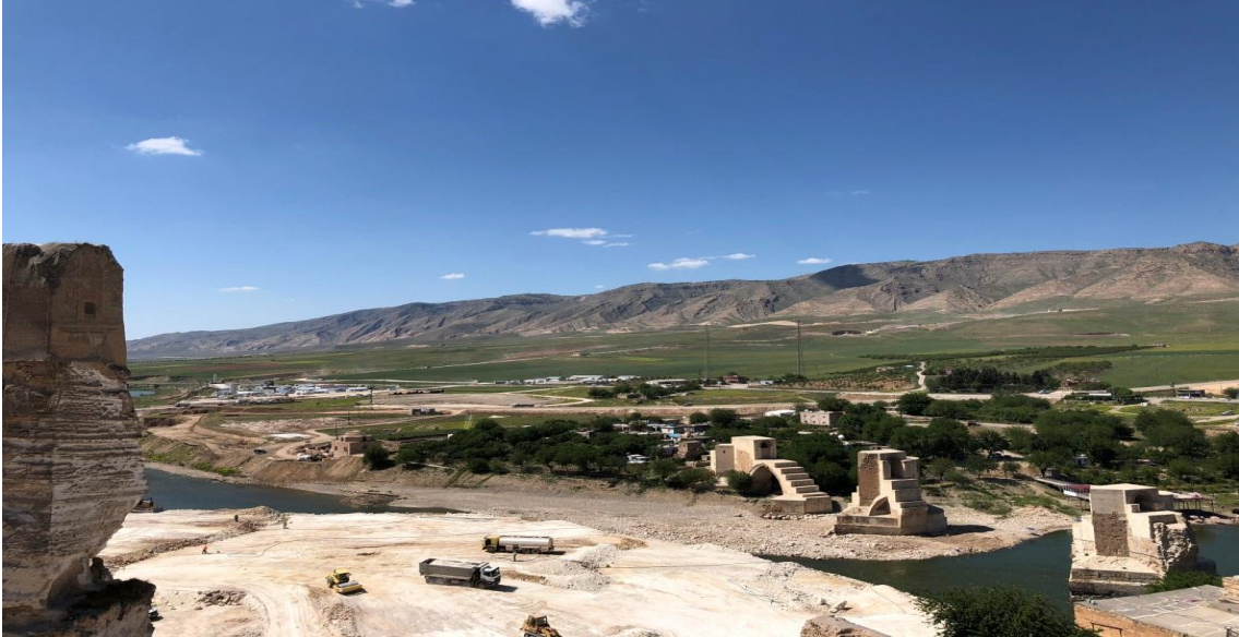
Fotoğraf 2.12. Ilısu Barajı restorasyon çalışmaları
