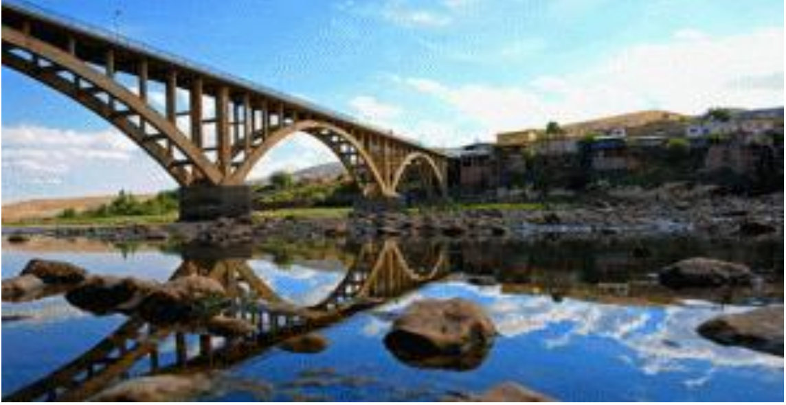
Fotoğraf 2.19. On Kemerli DDY Köprüsü
