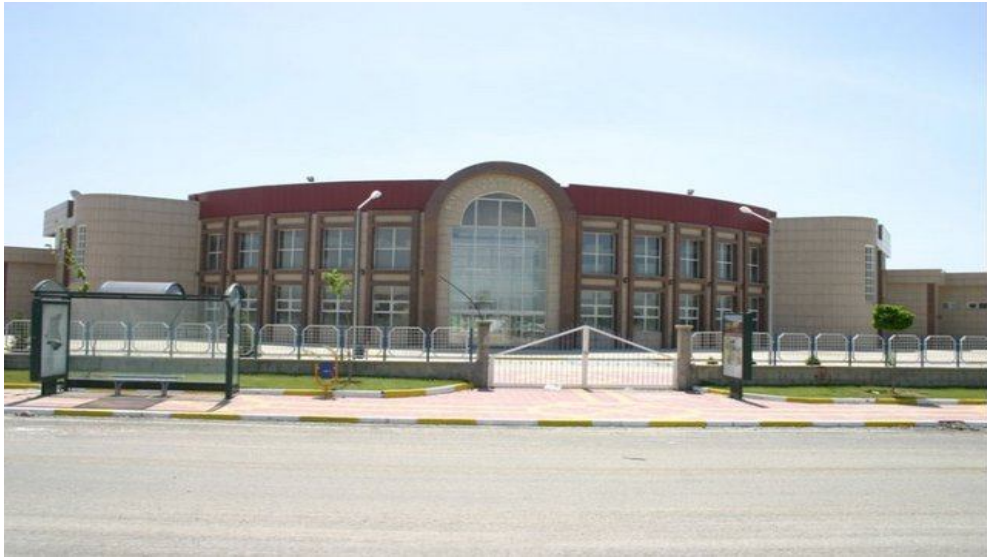
Foto 43: Batman Şehirler Arası Otobüs Terminalinden Bir Görünüm
