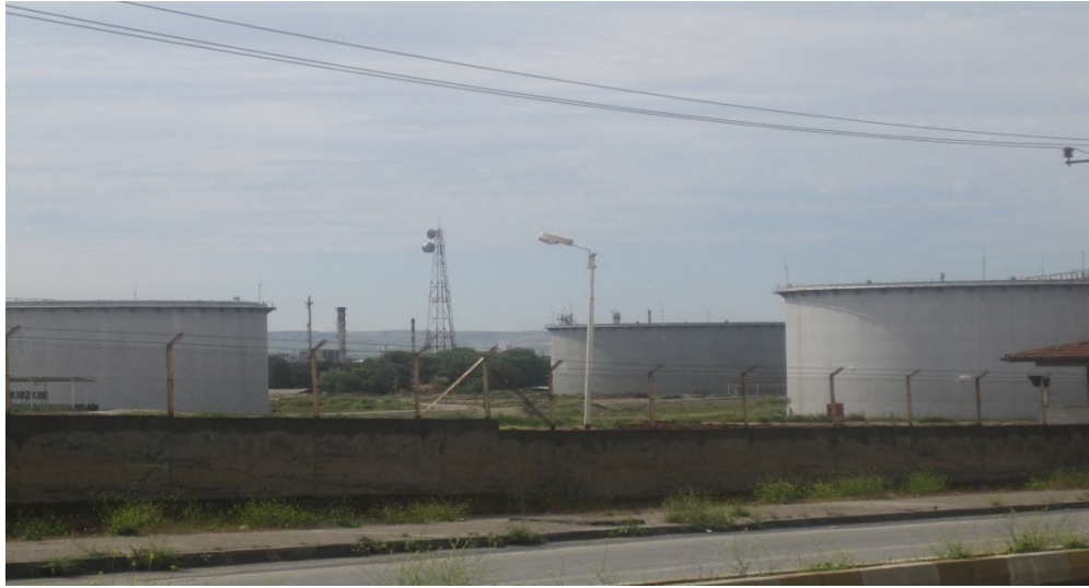
Foto 40: Tüpraş Ham Petrol Depolama Tanklarından Bir Görünüm
