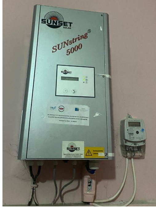
Şekil 3.7. Çok kristalli silisyumlu PV sistemde kullanılan SunString5000 eviricisi
