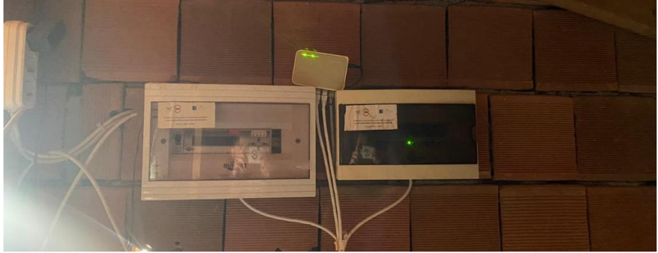
Şekil 3.8. PV sistemimiz tarafından üretilen güç değerlerini kaydeden SUNlogXL cihazı
