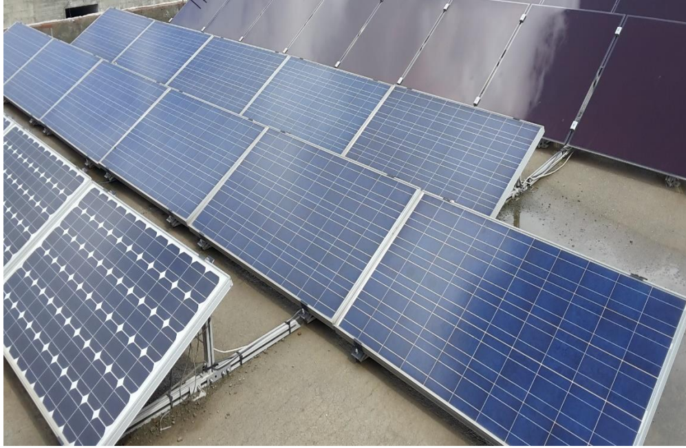
Şekil 3.9. Çok kristalli silisyum modüllerden elde edilmiş PV sistemimiz (ortada)
