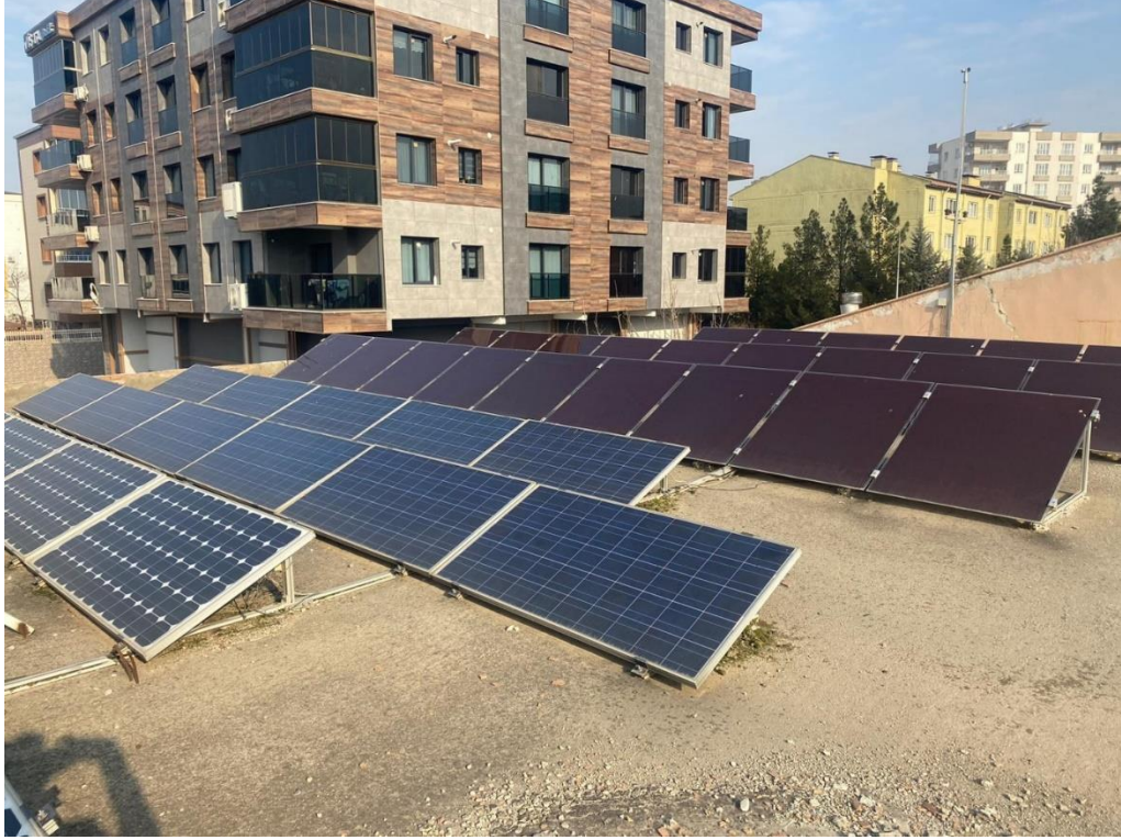
Şekil 3.6. Batman Gltepe Simya Koleji bina çatısına kurulu fotovoltaiik sistem
