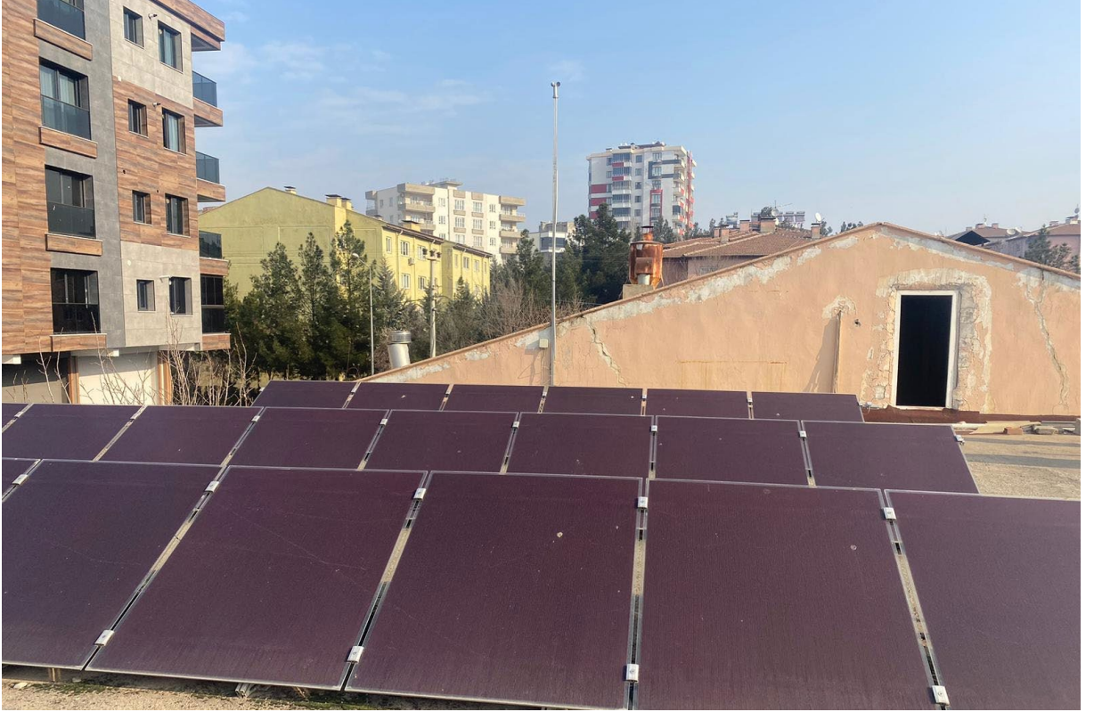
Şekil 3.9. İnce film a-Si modüllerden oluşan PV sistemimiz
