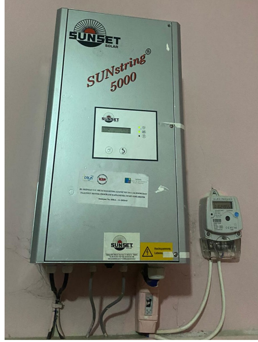
Şekil 3.7. a-Si teknolojiye sahip PV sistemde kullanılan Sunset firmasına ait SunString 5000 eviricisi
