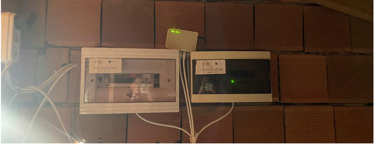
Şekil 3.8. Modüllerden elde edilen verileri kayıt altına alan SUNlog XL cihazı
