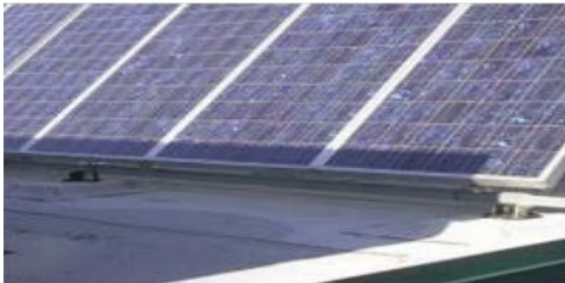
Şekil 2.29. Modüller üzerinde gölgelemeye örnek
