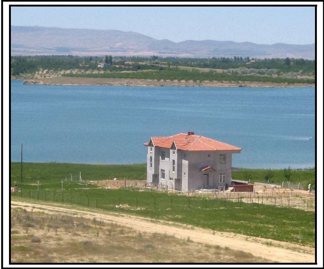
Foto: 3.10. Baraj kıyısında tuğla malzeme ve betonarme tekniği ile inşa edilmekte olan bir mesken örneği. İlçede mevsimlik olarak kullanılan, bazen sayfiye amacı da taşıyan evler oldukça yaygındır. Bu tür meskenlerde daha ziyade tuğla malzeme ve betonarme inşa tekniği kullanılmaktadır (2005).
