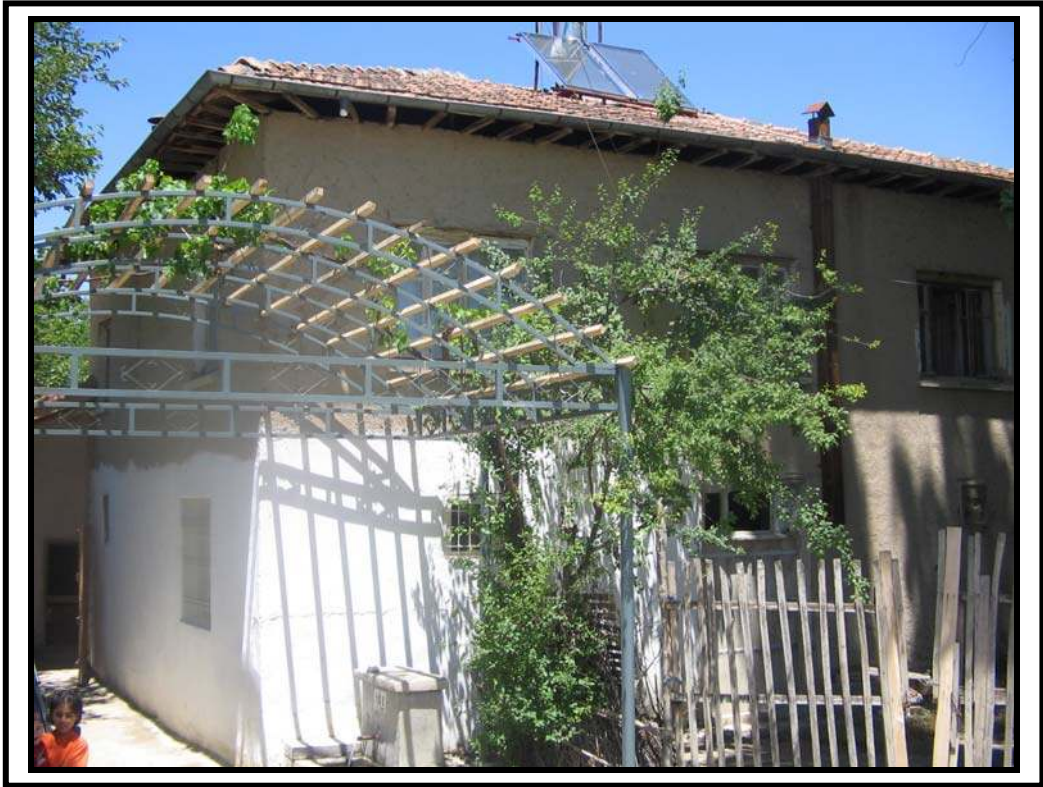
Foto: 3.7. Toygar köyünde iki katlı kerpiç bir mesken örneği. İlçe genelinde en yaygın kullanılan yapı malzemesi kerpiçtir. Daha ziyade tek katlı yapılan kerpiç meskenler, ekonomik düzeye ve aile büyüklüğüne bağlı olarak zaman zaman iki katlı olarak da karşımıza çıkabilmektedir (2005).
