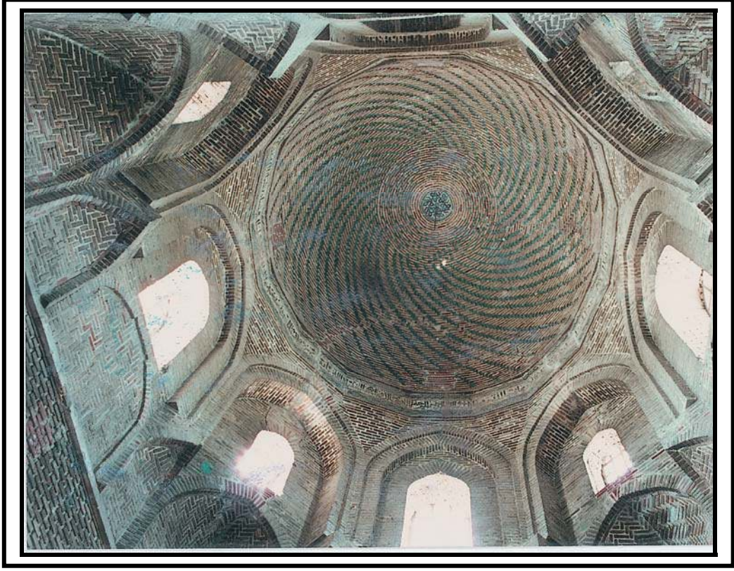
Foto: 4.14. Ulucamii kubbesinden bir görünüm. Tamamen tuğladan yapılmış olan yarım küre biçimindeki kubbe, üç dilimli yonca biçiminde tromplarla sekizgen bir tambur üzerine oturmaktadır. Tromplardan başlayarak, tuğlaların değişik renklere göre dizilmesi ile zengin bir görünüş elde edilmiş, bunlar kubbenin içinde spiral bir örnek meydana getirerek ortasına patlıcani ve firuze mozaik çinilerden altıgen yıldızlı bir Mühr-ü Süleyman işlenmiştir (a: Battalgazi Kültür Envanteri 2006).
