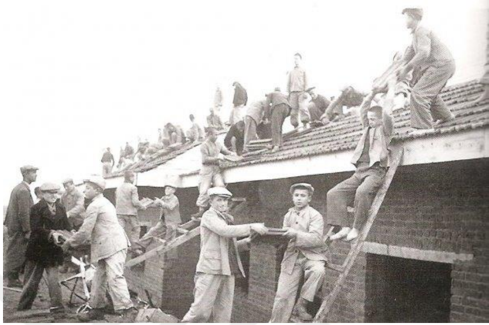
Resim 52: Enstitü binası yapımına yardım eden öğrenciler
