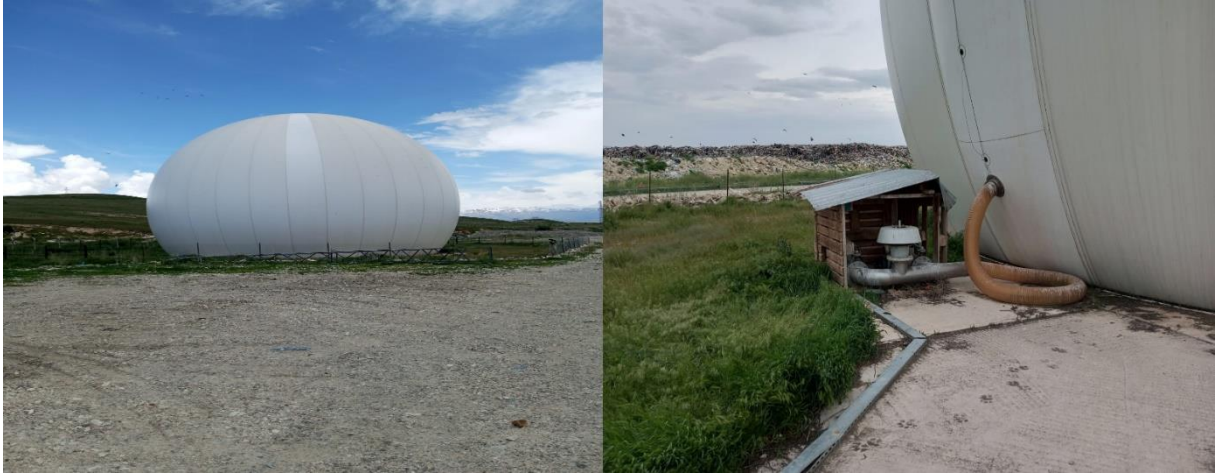
Şekil 11: BAY-GÜ-KAB Tesisinde Bulunan Gaz Depolama Tankı
