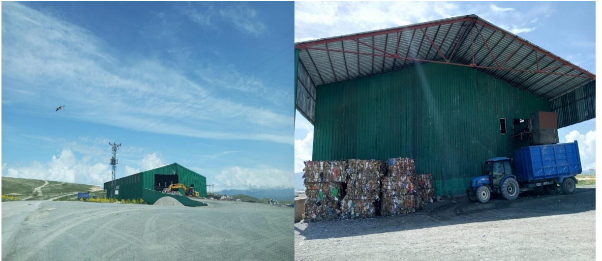
Şekil 7: BAY-GÜ-KAB Tesisinin Katı Atık Ayrıştırma Bölümü
