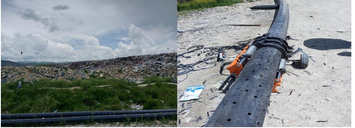
Şekil 8: BAY-GÜ-KAB Tesisinin Katı Atık Depolama Sahası ve Kullanılan Borular
