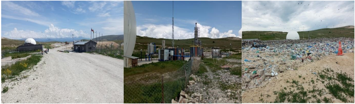
Şekil 4: Bayburt Düzenli Katı Atık Depolama Tesis
