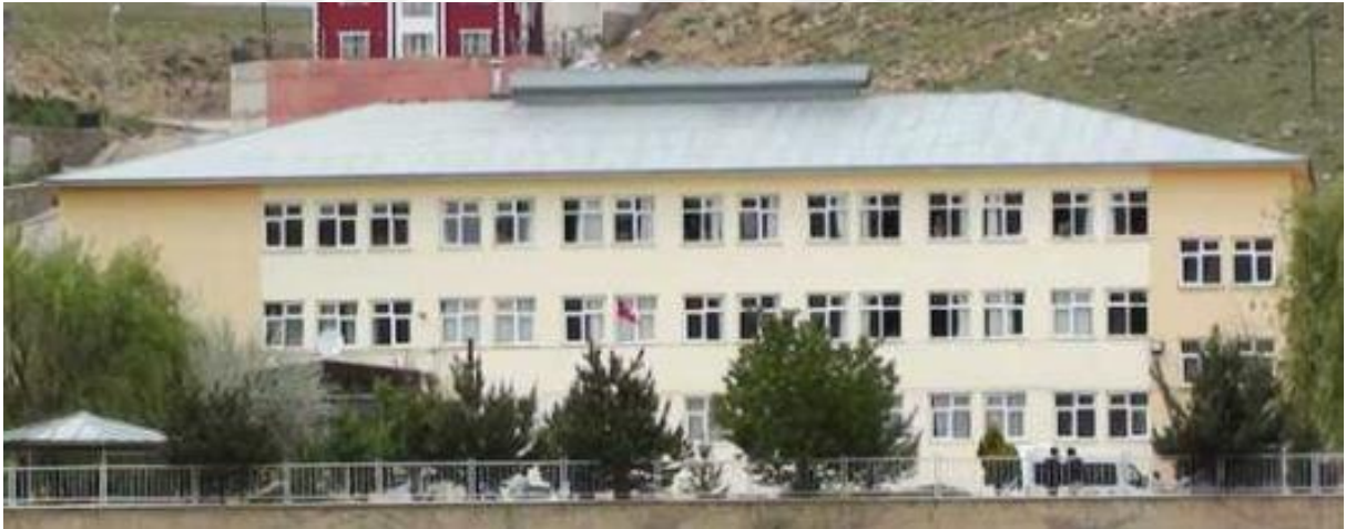
Şekil 7. Bayburt Rekabet Kurumu Kız Anadolu Lisesi Ortaokulu genel görünüşü.
