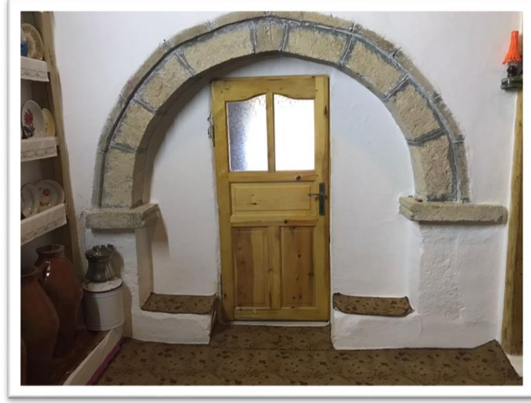
Şekil 32. Daha sonra odaya dönüştürülmüş bir tandirevinin taş kemer.
