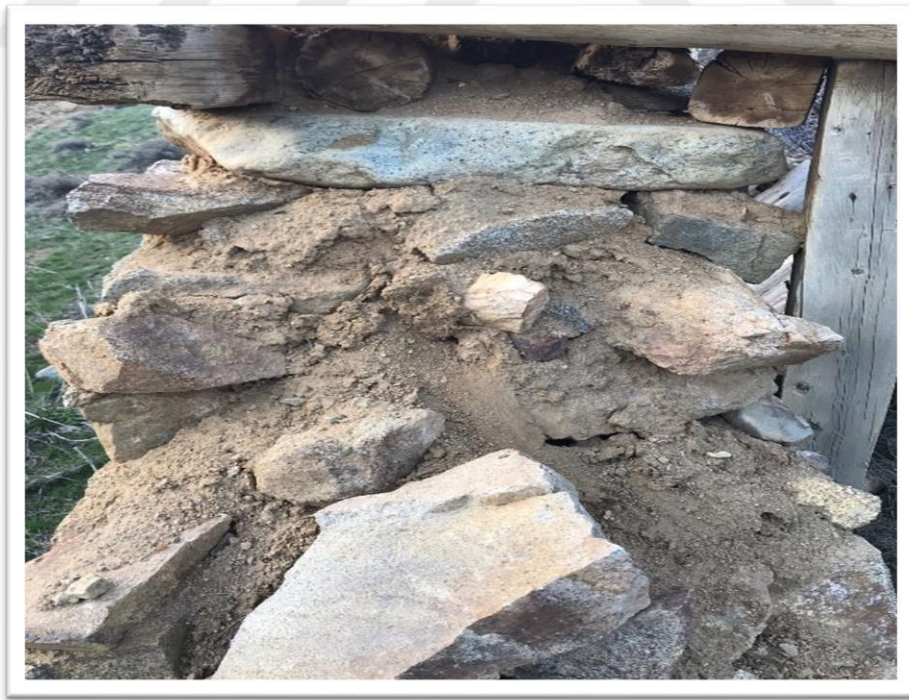
Şekil 65. Taş duvarı bağlamak için bazı taşlar yatay koyulmaktaydı.
