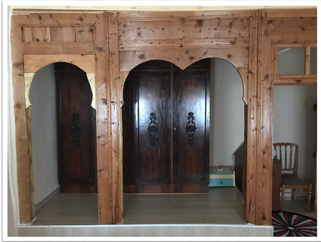
Şekil 13.Sonradan değiştirilmiş banyo(solda) ve yüklük(sağda)dolapları.
