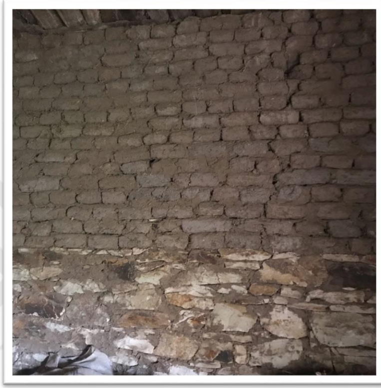
Şekil 64. Yarisı taşla diğer yarisı kerpiçle yapılmış duvar.
