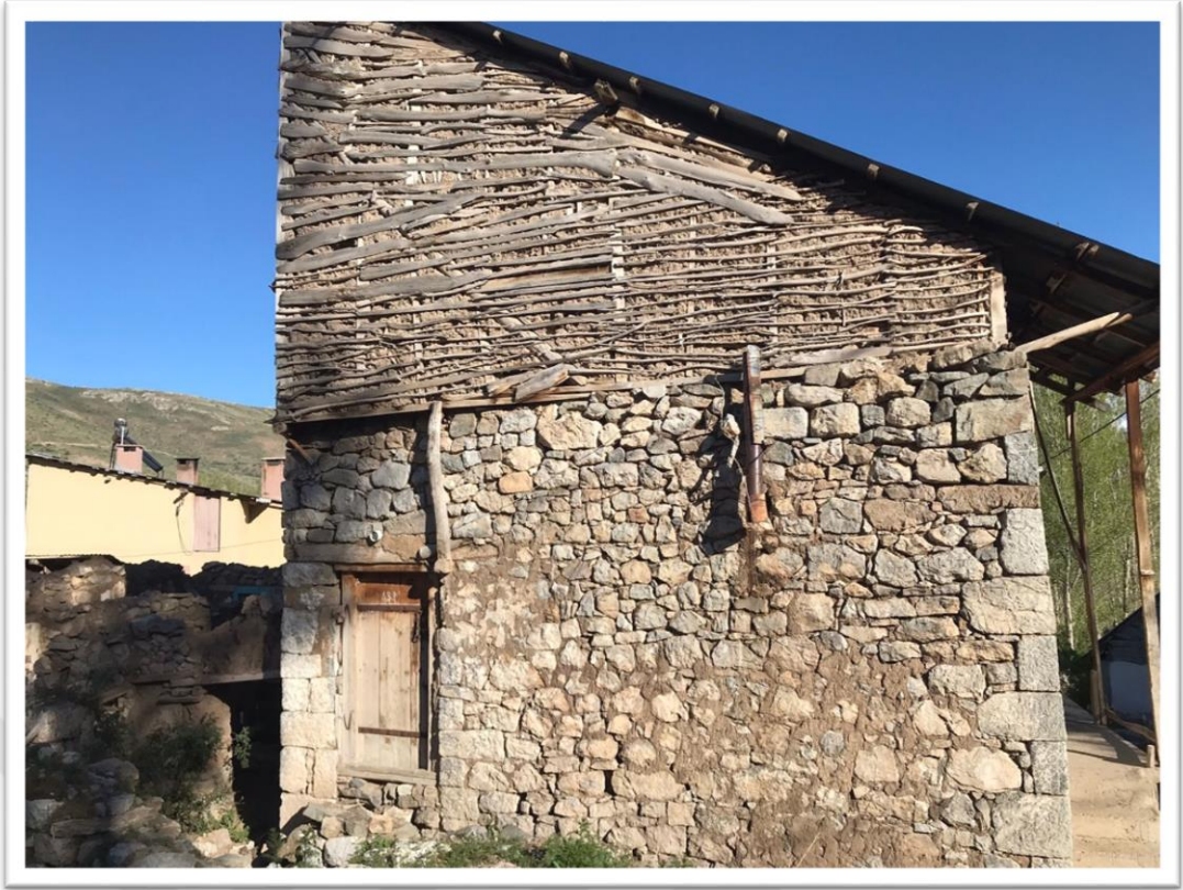
Şekil 67. Taş duvar üzerine harpuşka duvar.
