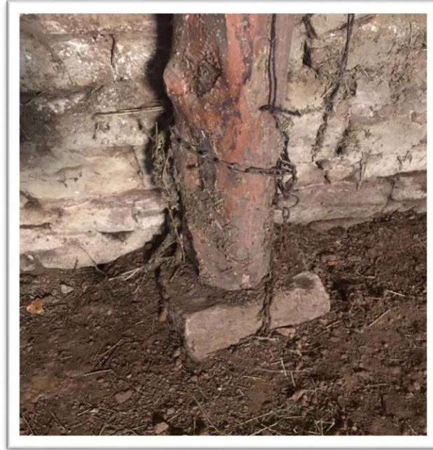
Şekil 62. Direğin altına yerleştirilmiş taş.
