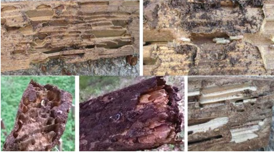
Şekil 7. EN 252 (1989) testi sonrasında örneklerin durumu ve zararlı degradasyonu (Knapic vd. 2018)
