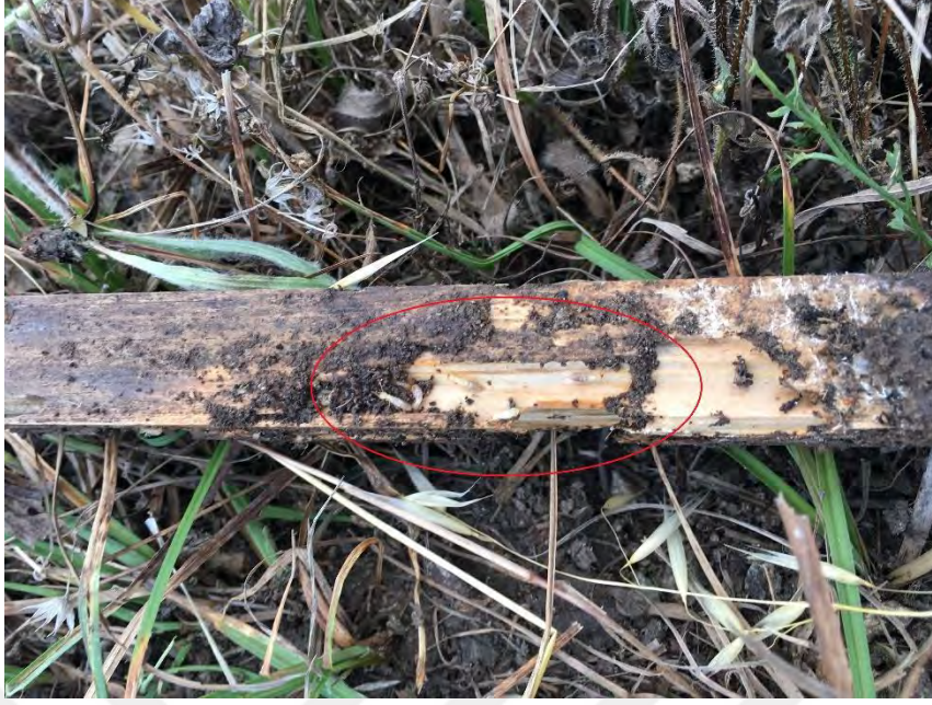
Şekil 3. Termit zararlısı ve degradasyonu
