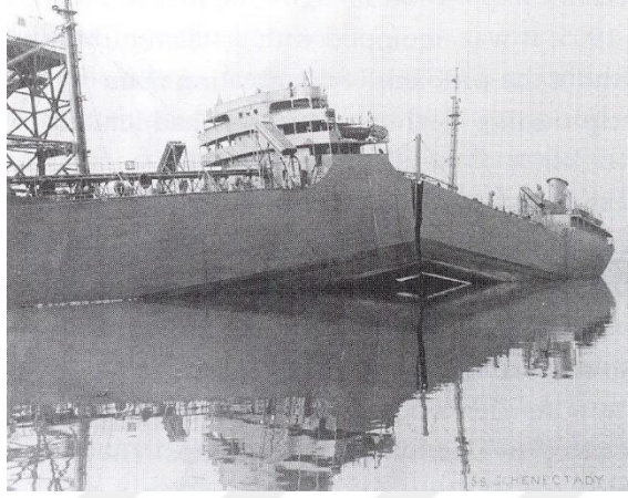
Şekil 5.2 Schenectady adlı tankerin ağır hasarlı hali [47]
