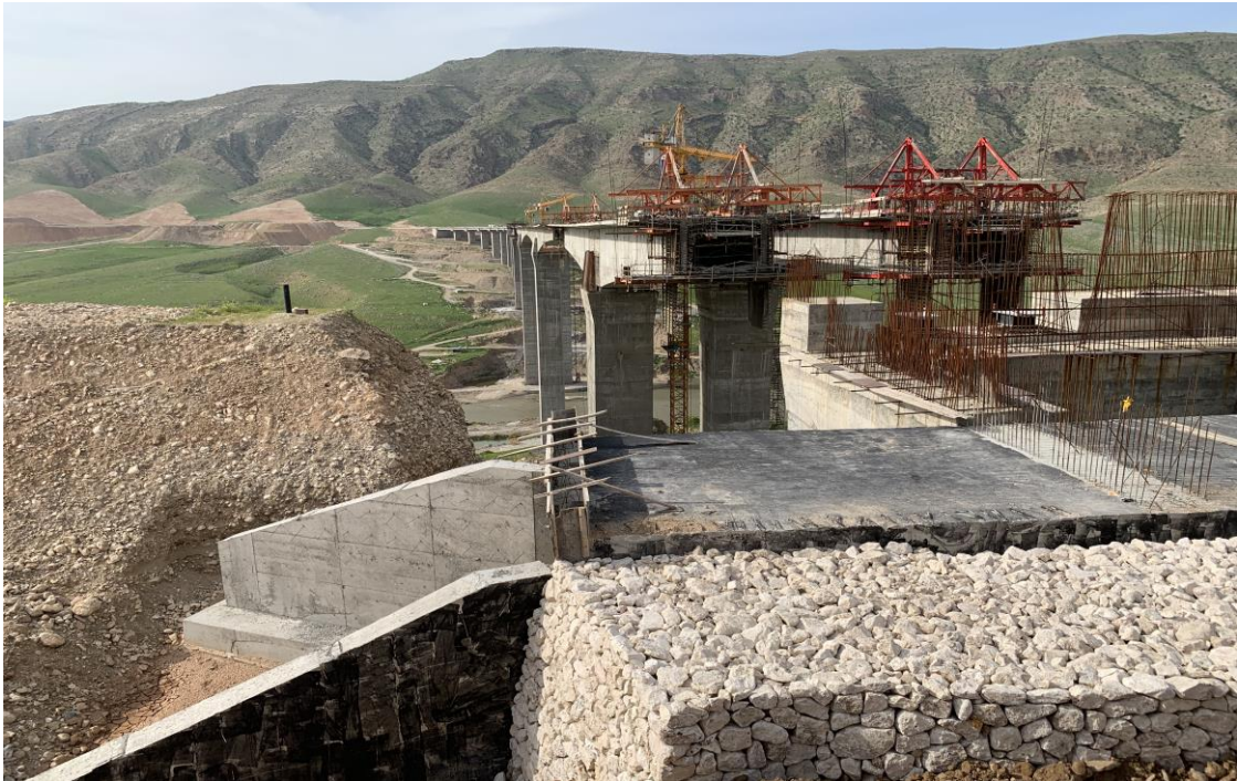
Şekil 4.1 Altyapı çalışmalarından bir görüntü
