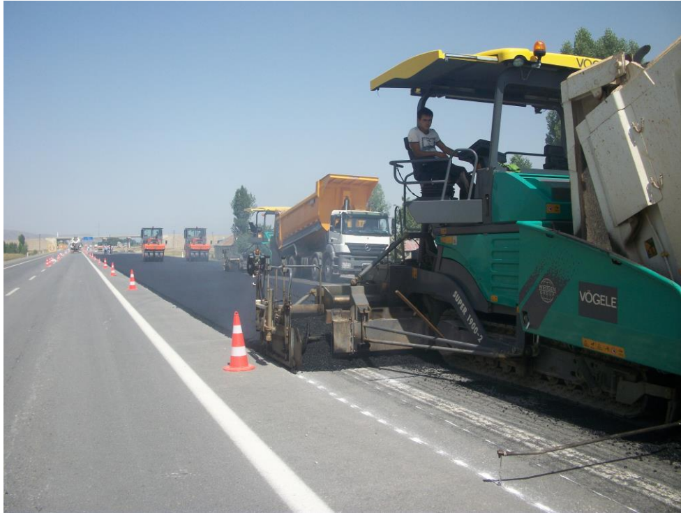
Şekil.4.2. Bitümlü sıcak karışımların serim aşamasından.
