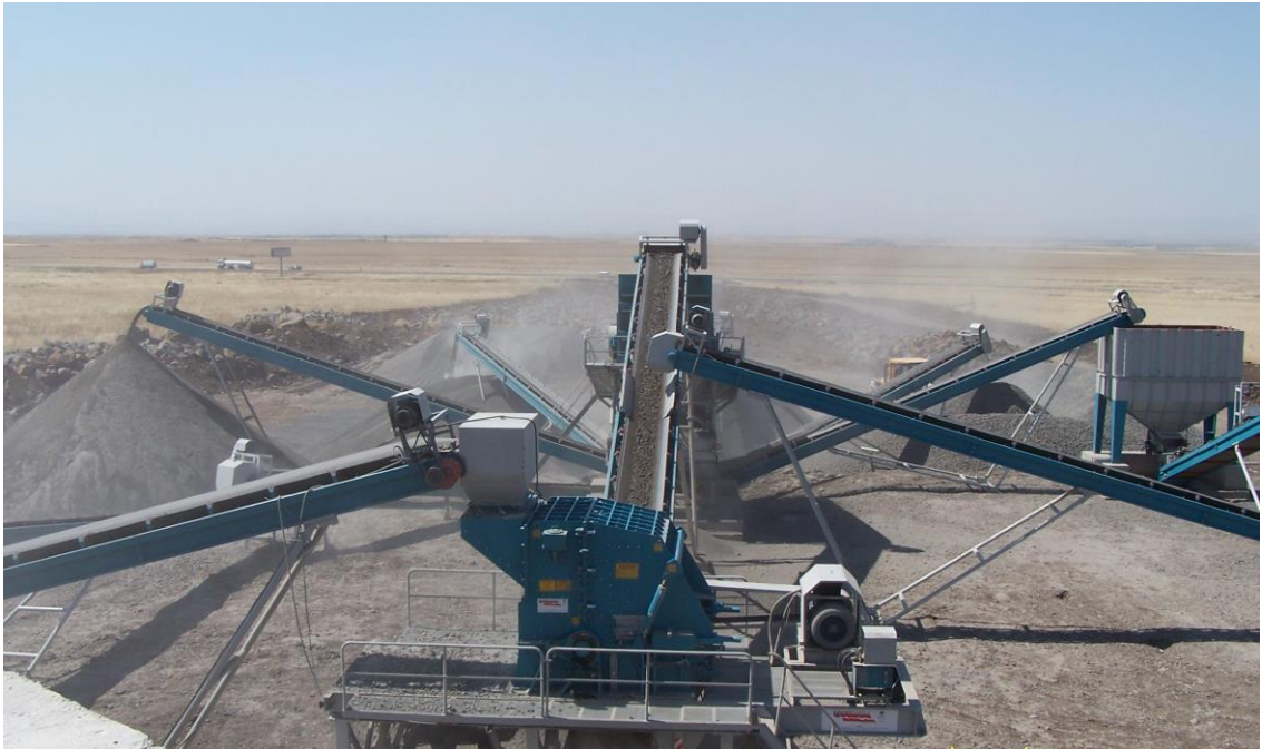
Şekil.5.1. Kırma eleme konkasör tesisinden agrega üretimi aşaması.
