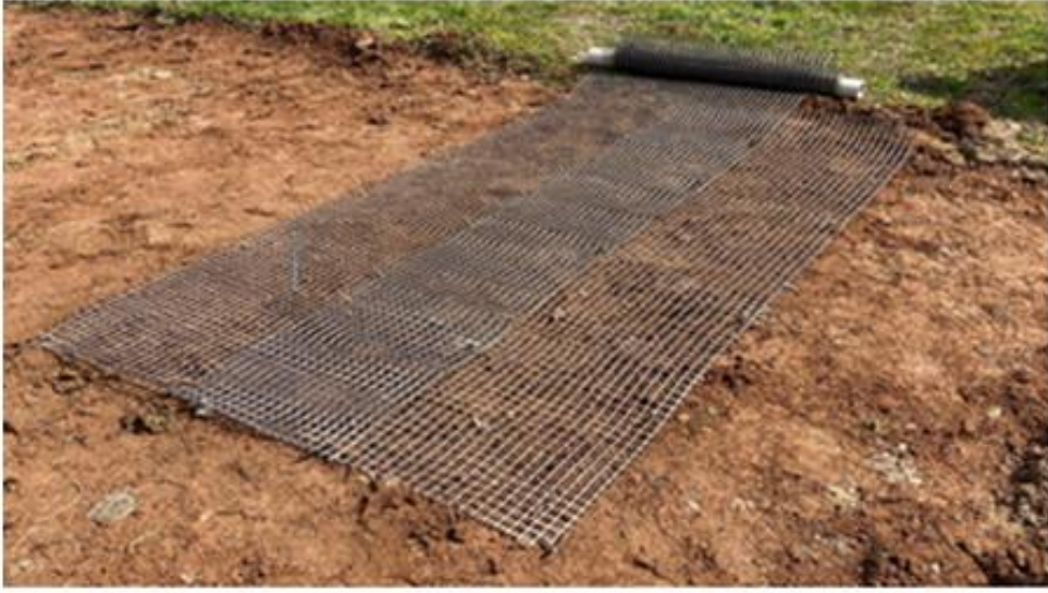
Şekil 5.11. Bazalt geogridin yerleştirilerek sabitlenmesi.
