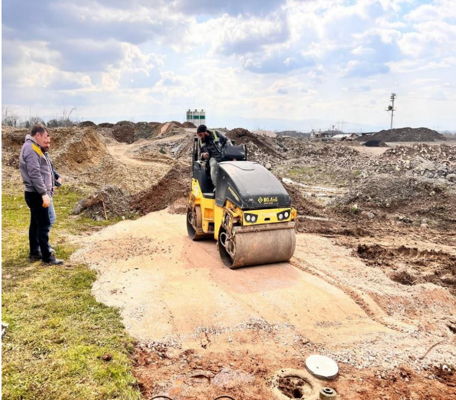
Şekil 5.12. Dolgu malzemenin serilmesi ve sıkıştırılması
