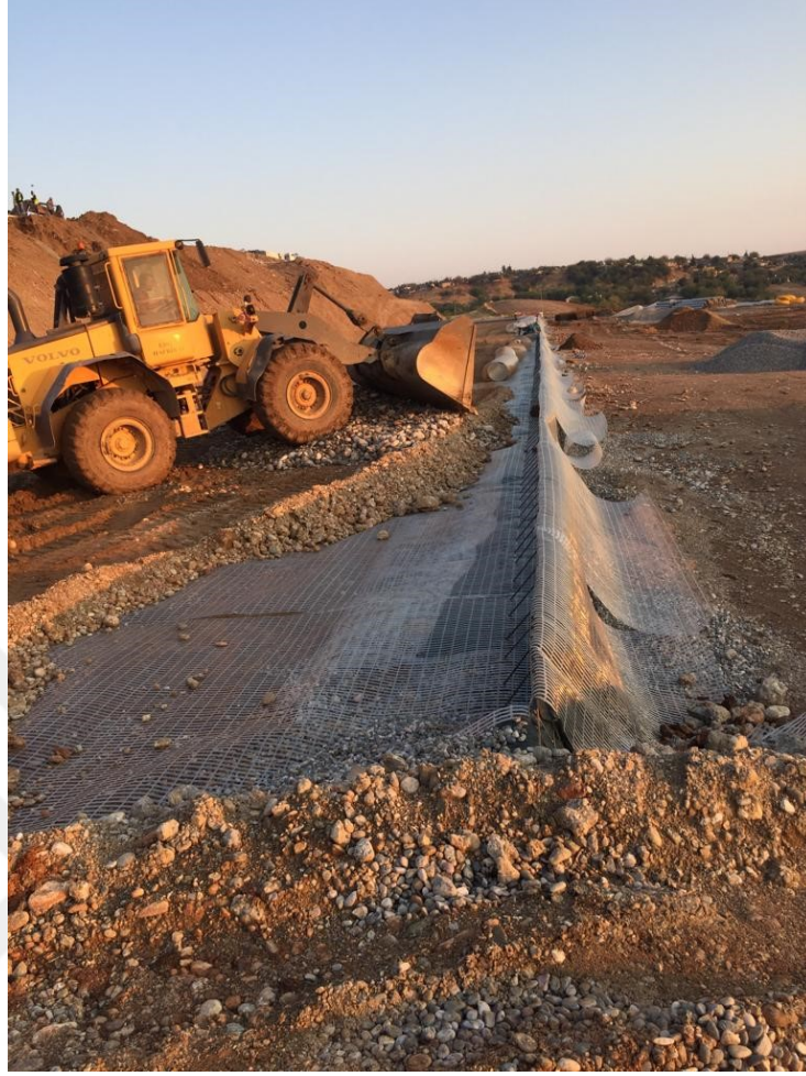
Şekil 2.1. Geogrid donatılı duvar imalatı
