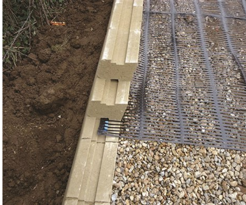
Şekil 2.2. Tek eksenli geogridle duvar imalatı (URL-2)
