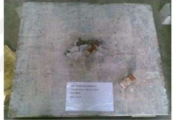
Şekil 2.10. Lifli GB'nin darbe altında çatlak hasarı (K vd., 2014)
