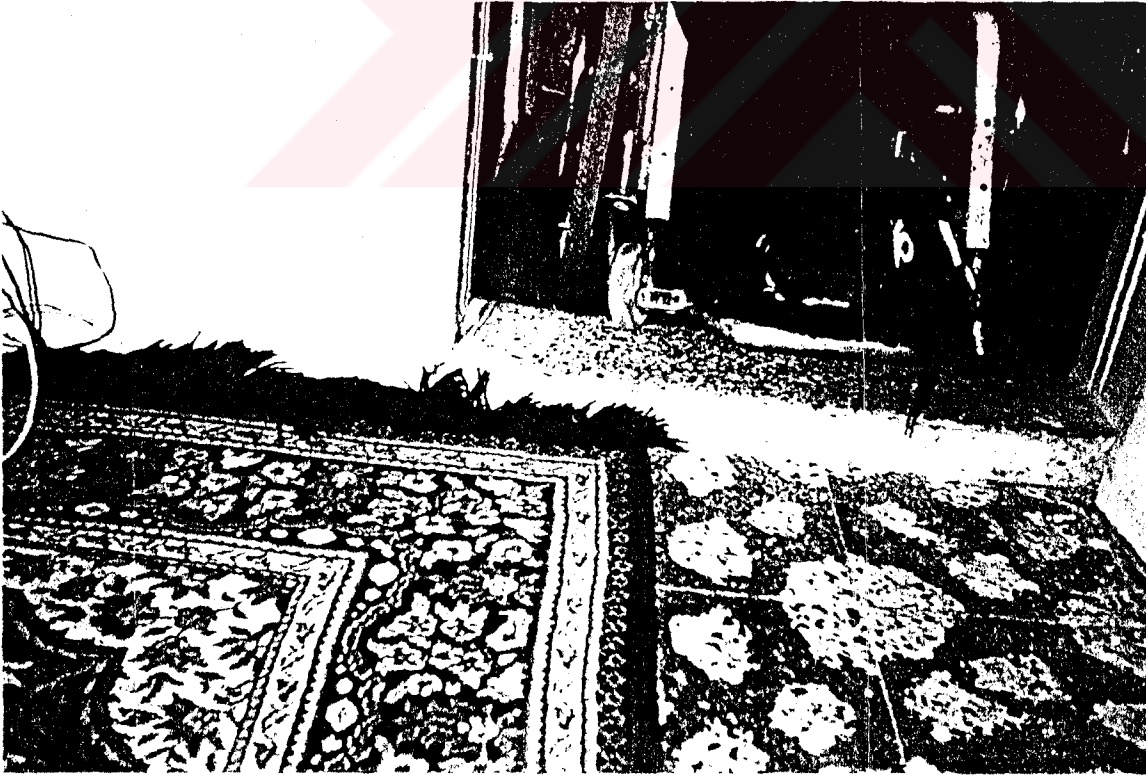
Resim 10 : Kapıda Standarda Uymayan Eşik Yüksekliği ve Eşik Malzemesinin Cinsi
