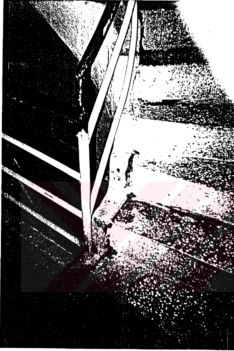
Resim 8 : Uygun Olmayan K pe te Y kseklięi
