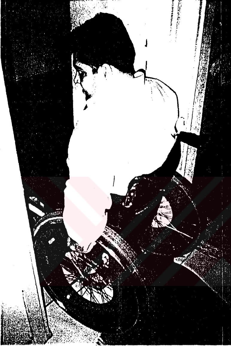
Resim 12 : Uygun olmayan Kapı Geniřlięi
