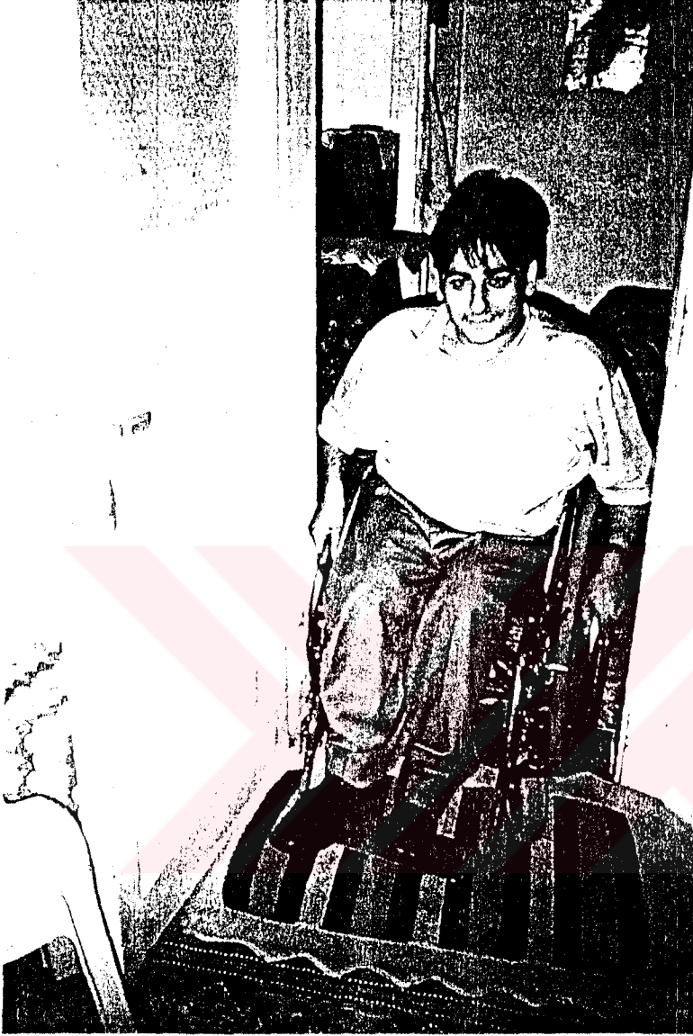
Resim 11: Standarda Uygun Kapı Tipi ve Kavrama Kolu Yüksekliği Standarda Uygun Olmayan Kapı Genişliği
