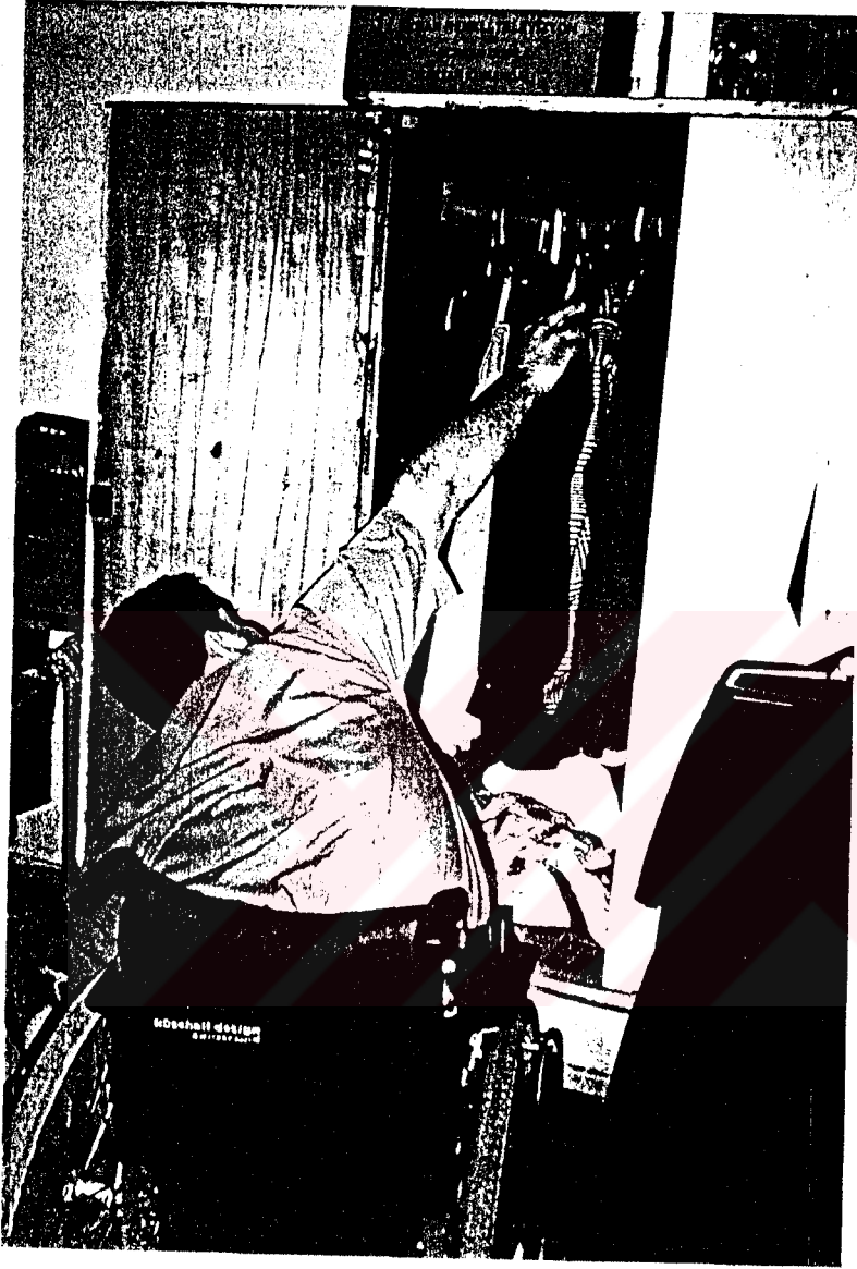
Resim 25 : Uygun Olmayan Elbise Dolabı Kullanım Yüksekliği
