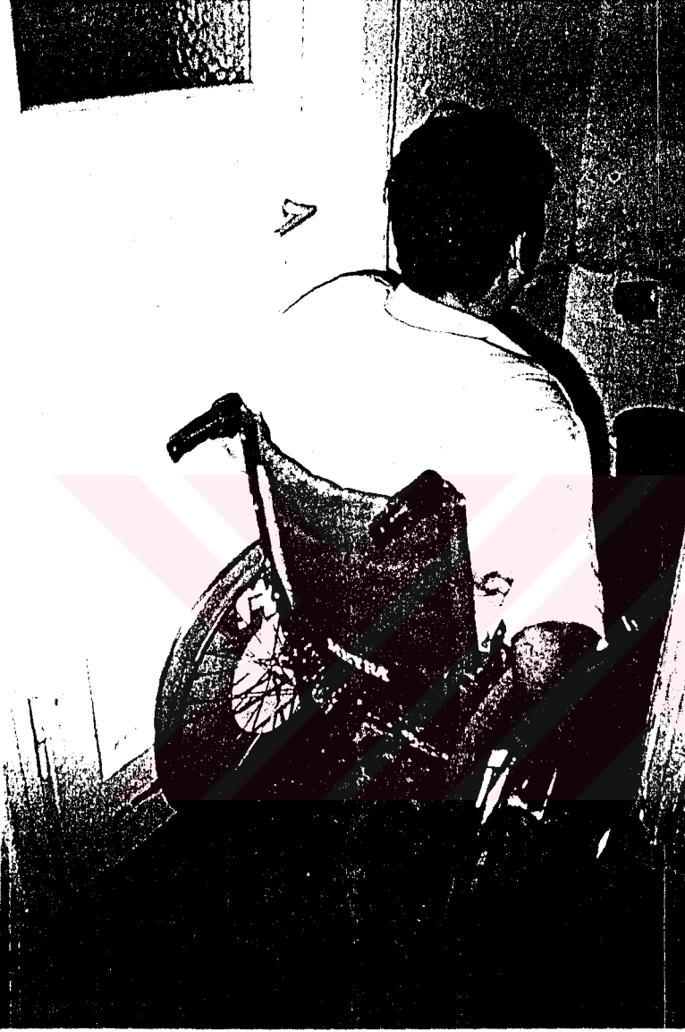
Resim 18 : Uygun Olmayan Tuvalet Kapısı Genişliği
