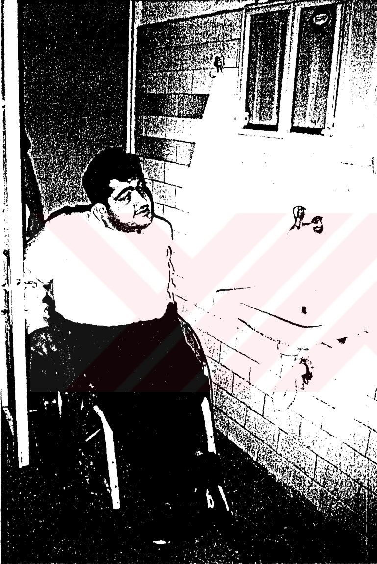
Resim 20 : Uygun Lavabo Yüksekliği, Uygun Olmayan Ayna Yüksekliği
