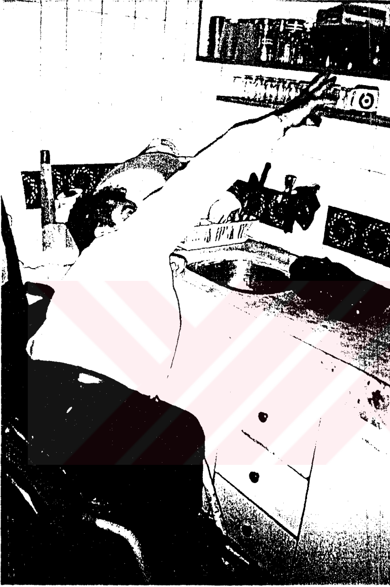
Resim 17 : Uygun Olmayan Tezgah, Eviye ve Raf Yüksekliği
