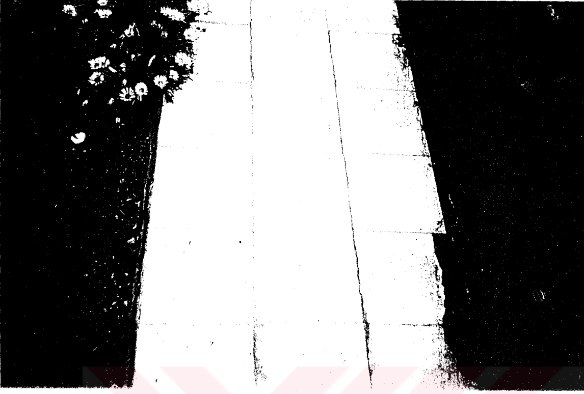
Resim 1. Uygun Olmayan Bahçe Yolu Genişliği, Uygun Yüzey Malzemesi
