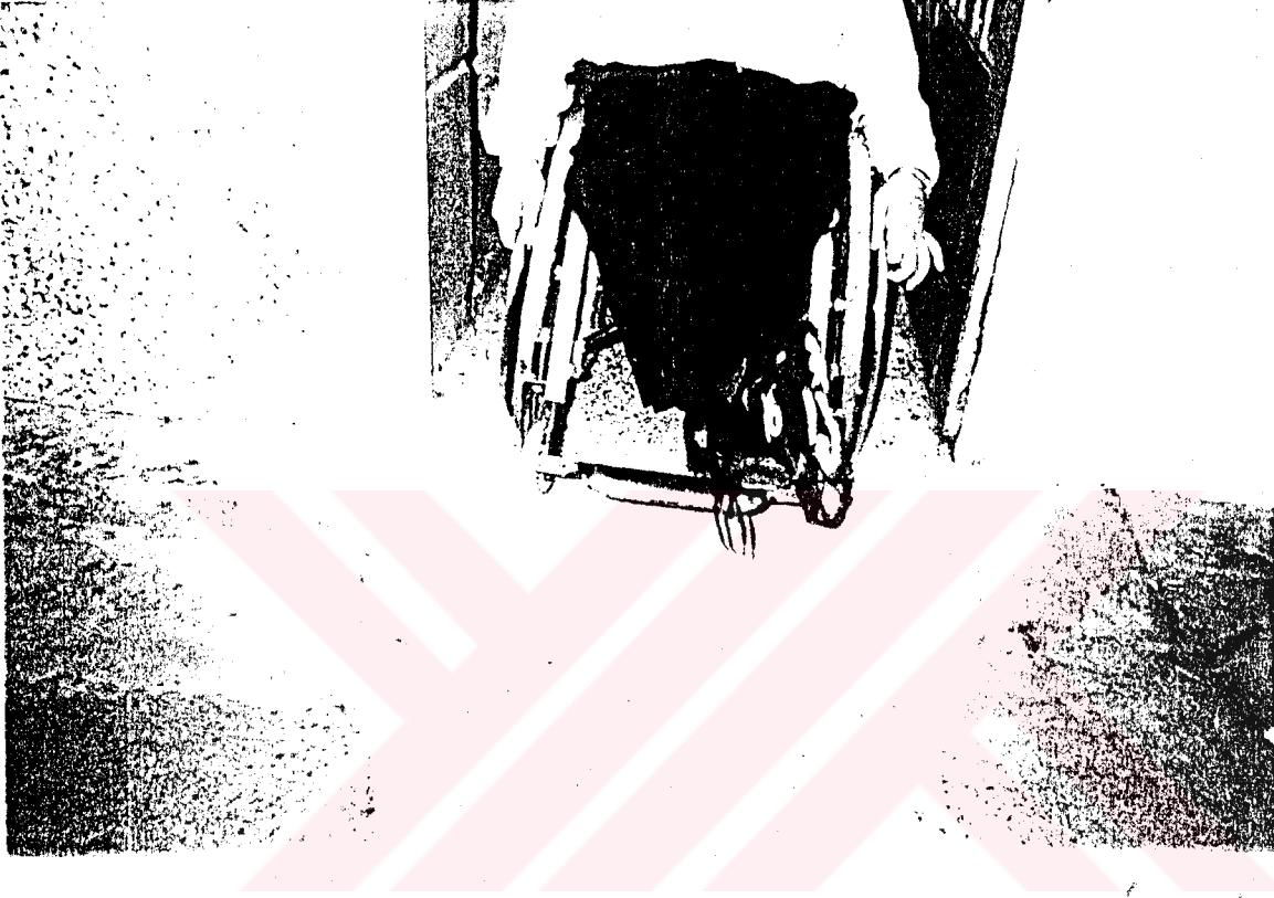
Resim 5: Uygun Olmayan Giriş Kapısı Genişliği
