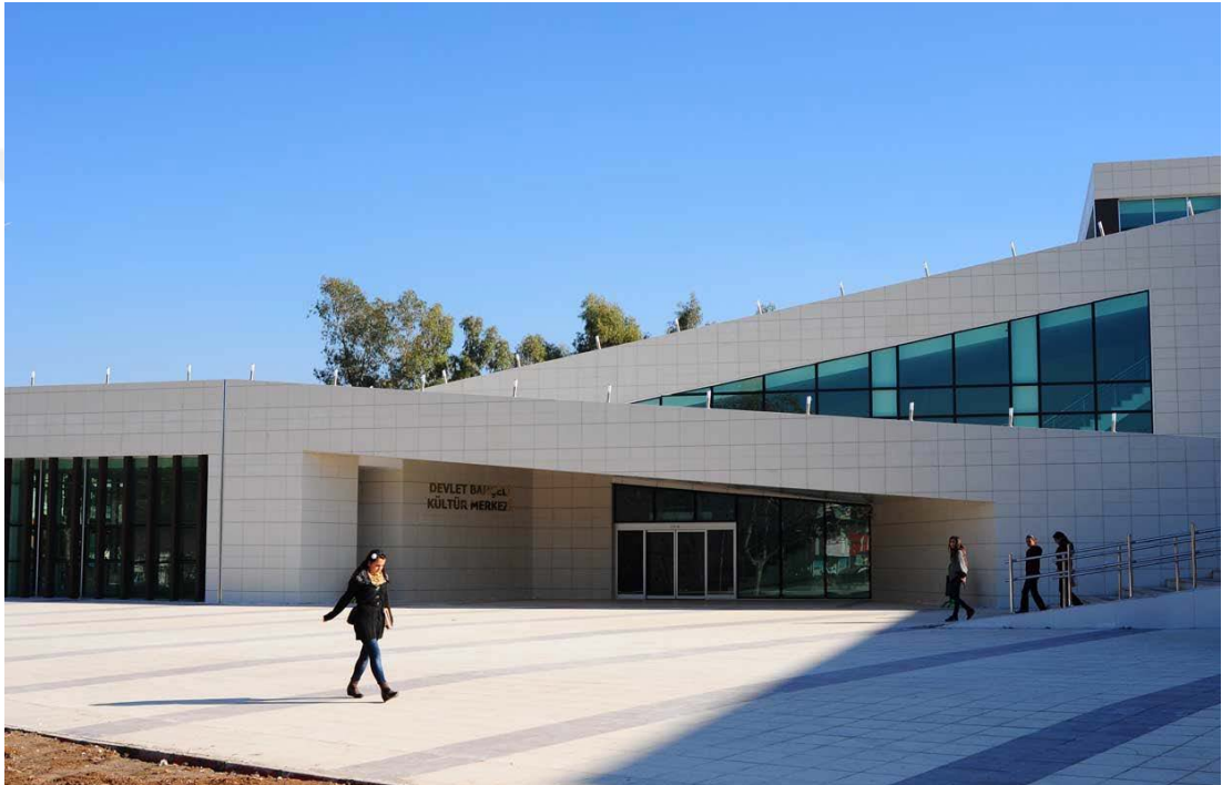
Şekil 4.25 Kadiri Belediyesi Hizmet Binası (İkiartıbir, bt)
