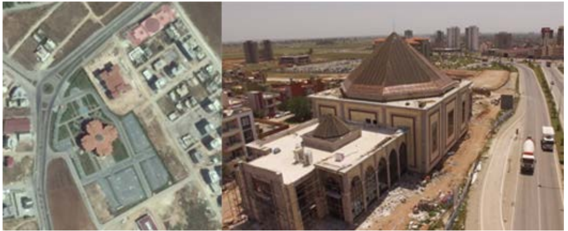
Şekil 4.27 Sarıçam Belediyesi Kültür Merkezi inşaatı (Sarıçam Belediyesi Kültür Merkezi inşaatı, bt)
