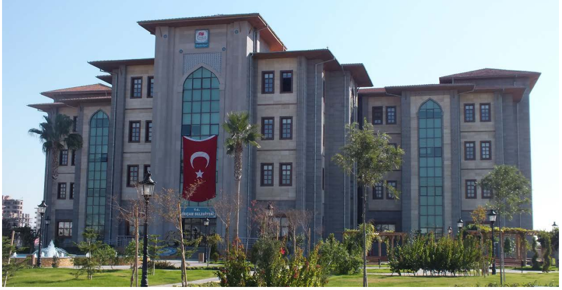
Şekil 4.8 Sarıçam Belediye Hizmet Binası genel görünüm (Kişisel arşiv, 2015)
