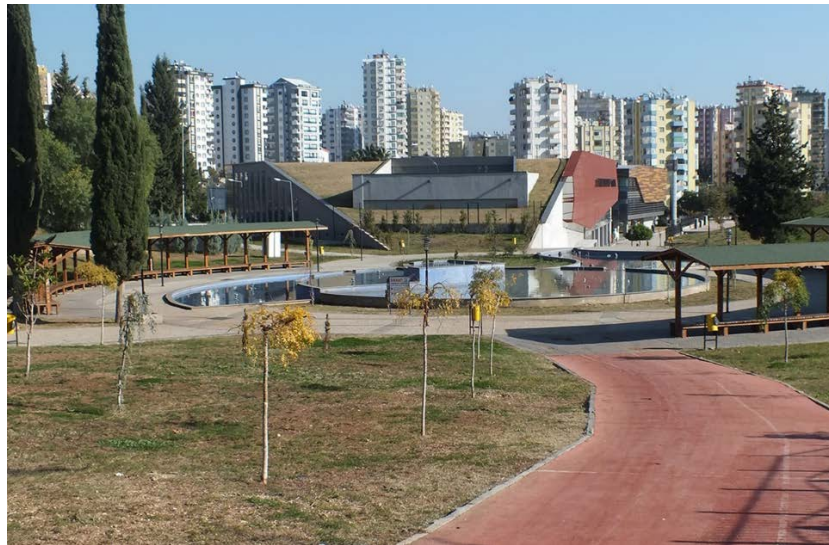
Şekil 4.6 Çukurova Belediyesi Hizmet Binası uygulanan yeşil çatı (Kişisel arşiv, 2015)
