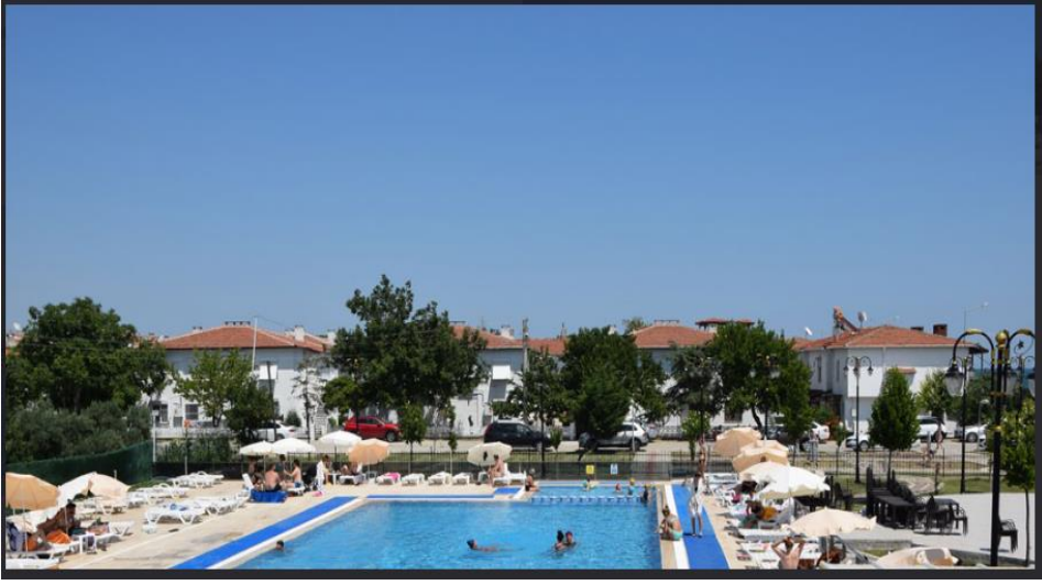
Şekil 5.4. Şarköy Belediyesi Sosyal Tesisleri
