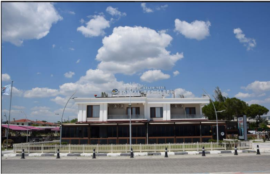
Şekil 5.1. Şarköy Belediyesi Sosyal Tesisleri
