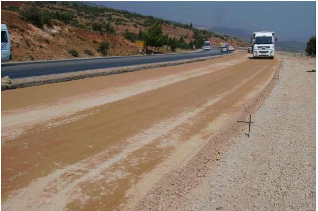
Şekil 3.24. Ofset Kazıkları Üzerinde Gerili 3mm Kalınlıkta Çelik Tel
