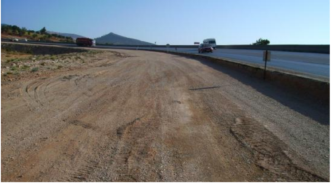
Şekil 3.20. Sulanıp Sıkıştırılan Zemin
