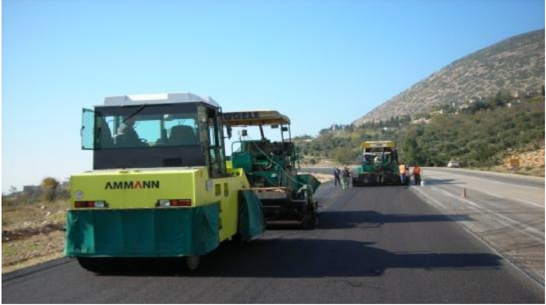
Şekil 3.31. Yolun Uygun Olması ve Çift Finişer ile Çalışma
