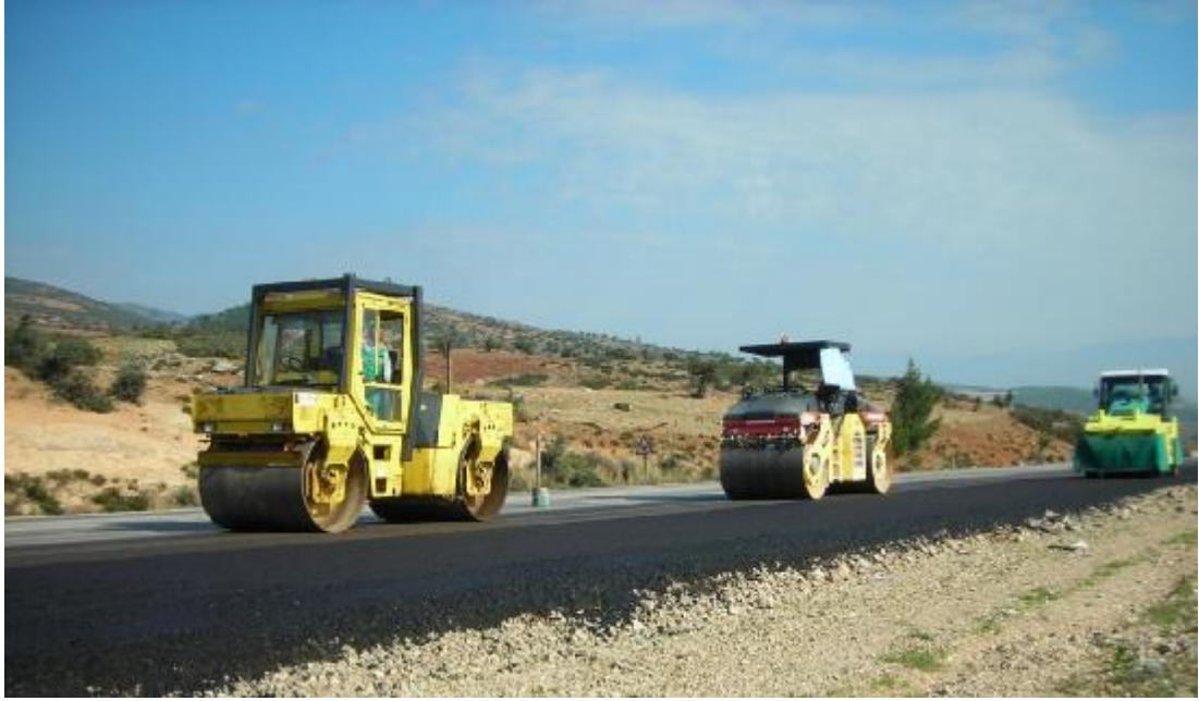
Şekil 3.27. İki Demir Bandajlı Bir Lastik Tekerlekli İle 3 Silindirin Çalışması
