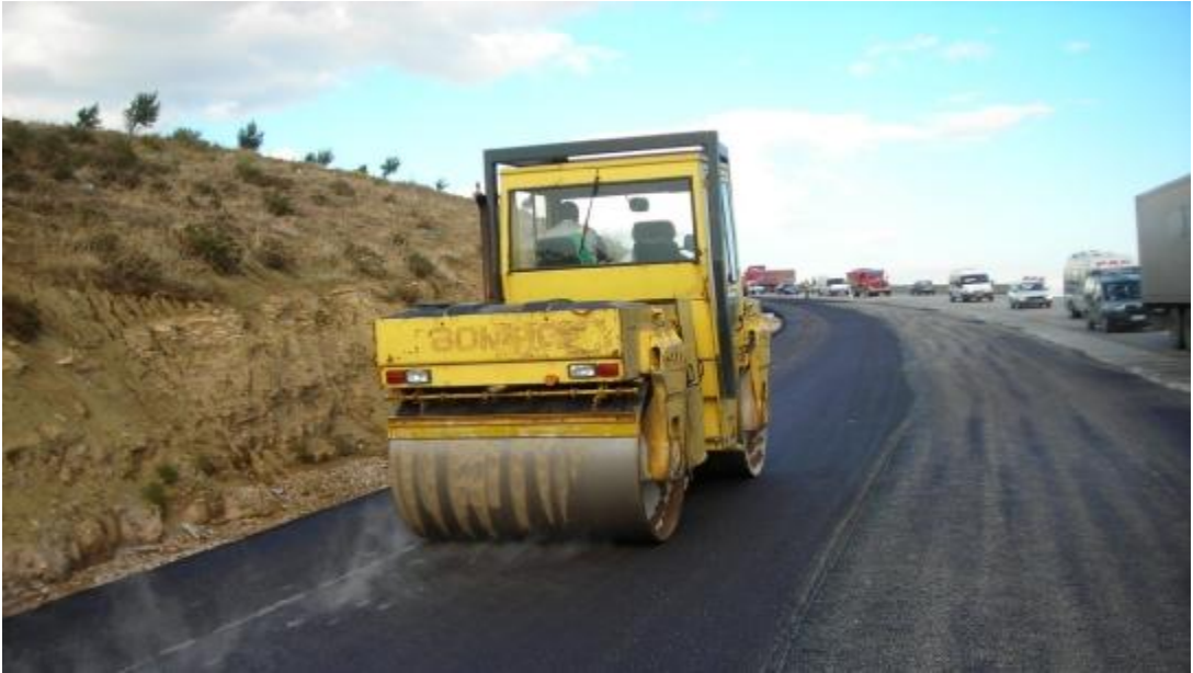
Şekil 3.32. Yapışmayı Önlemek İçin Silindirin Demir Bandajlarına Su Püskürtülmesi
