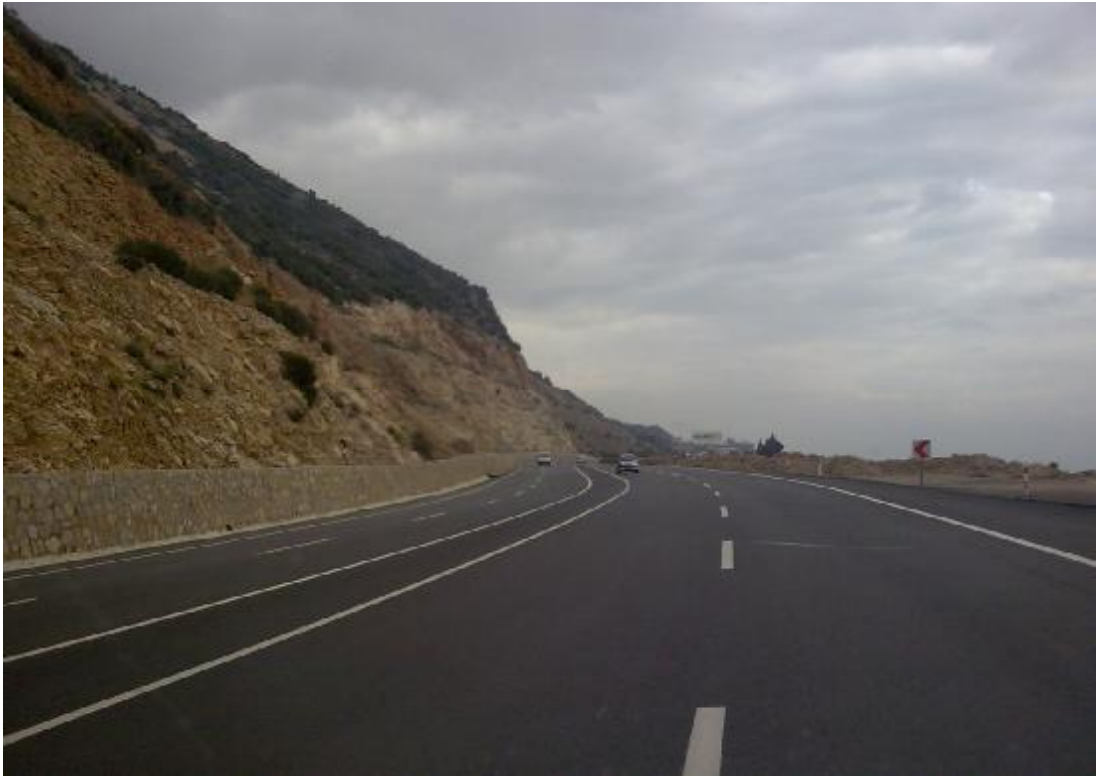
Şekil 3.37. Yapımı Biten Yolun Görünümü
