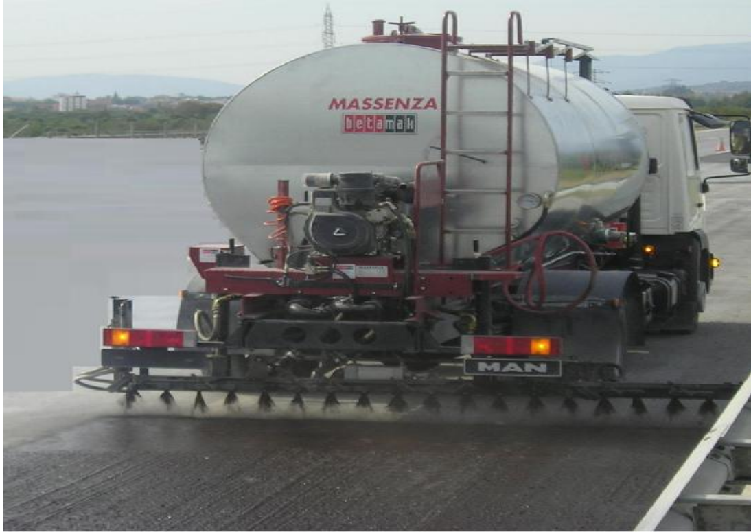
Şekil 3.29. Bitümlü Yapıştırıcının Distüribütör İle Uygulanması
