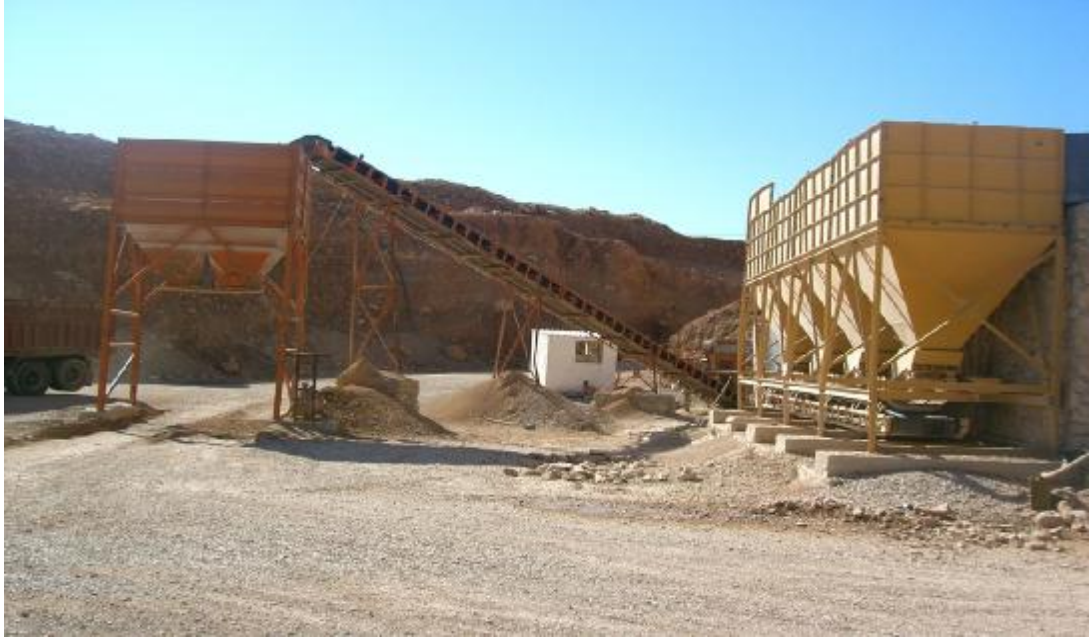
Şekil 3.13. Dört Silodan Oluşan Plent – Miks Temel Üretim Tesisi
