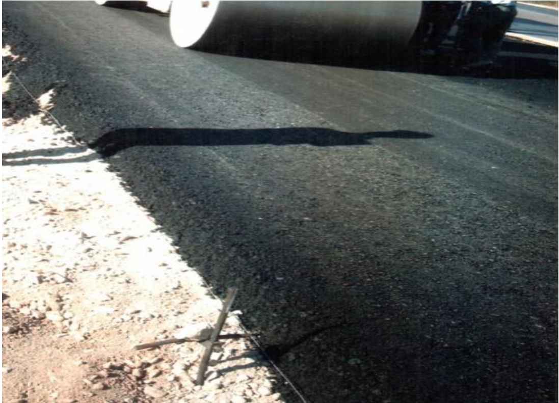
řekil 3.30. Finieřin Asfalt Serme Kalınlıęını Belirleyen elik Tel Sistemi
