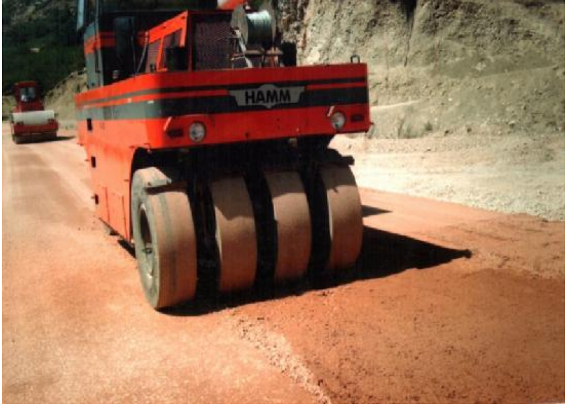
Şekil 3.23. Lastik Tekerlekli Silindir (Vabil) İle PMT Sıkıştırma İşlemi
