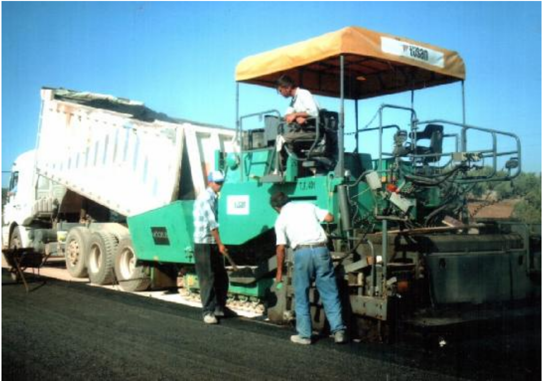
Şekil 3.25. Finişer ile Bitümlü Temel Serimi
