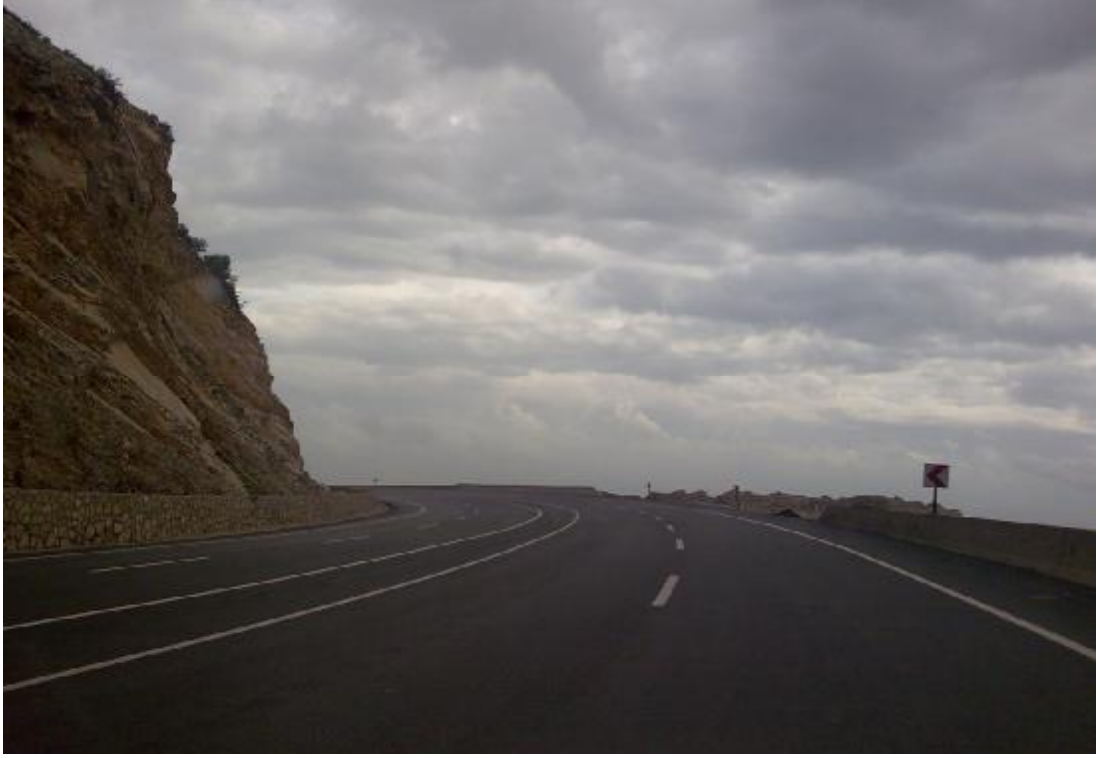
Şekil 3.36. Yapımı Biten Yoldan Genel Görünüm
