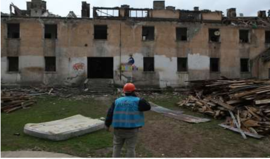
Resim 4.61. Kışla binasının restorasyon çalışması. Serpil Polat Arşivi.2015
