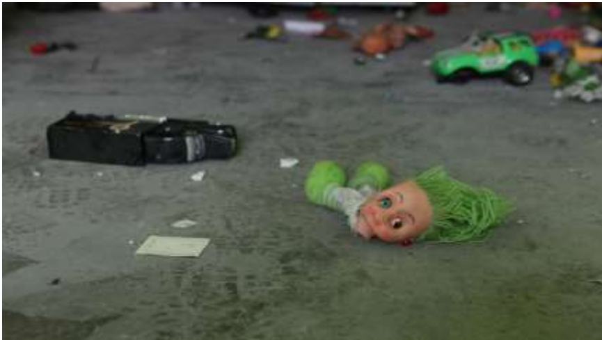
Resim 4.60. Kışla binasının 2015 yılında boşaltılmış ve restorasyon çalışması başlamıştır. Serpil Polat Arşivi.2015
