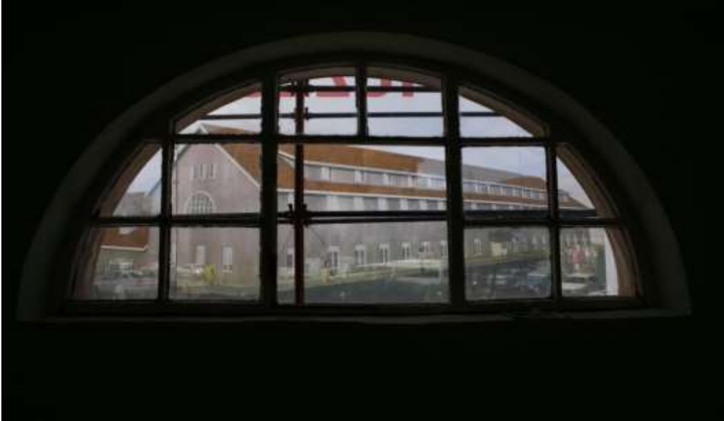
Resim 4.64. Kışla binasının restorasyon çalışması. Serpil Polat Arşivi.2015
