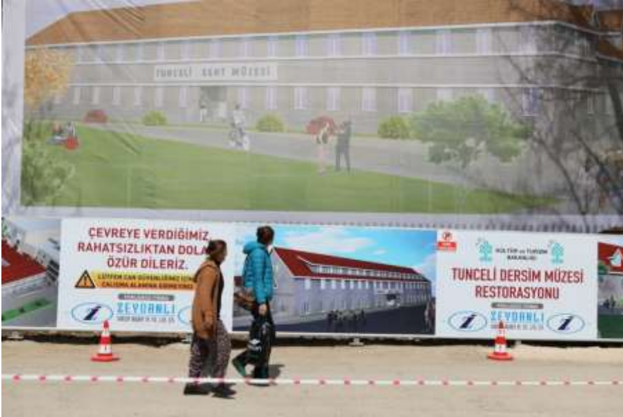
Resim 4.66. Kışla binasının restorasyon çalışması. Serpil Polat Arşivi.2015
