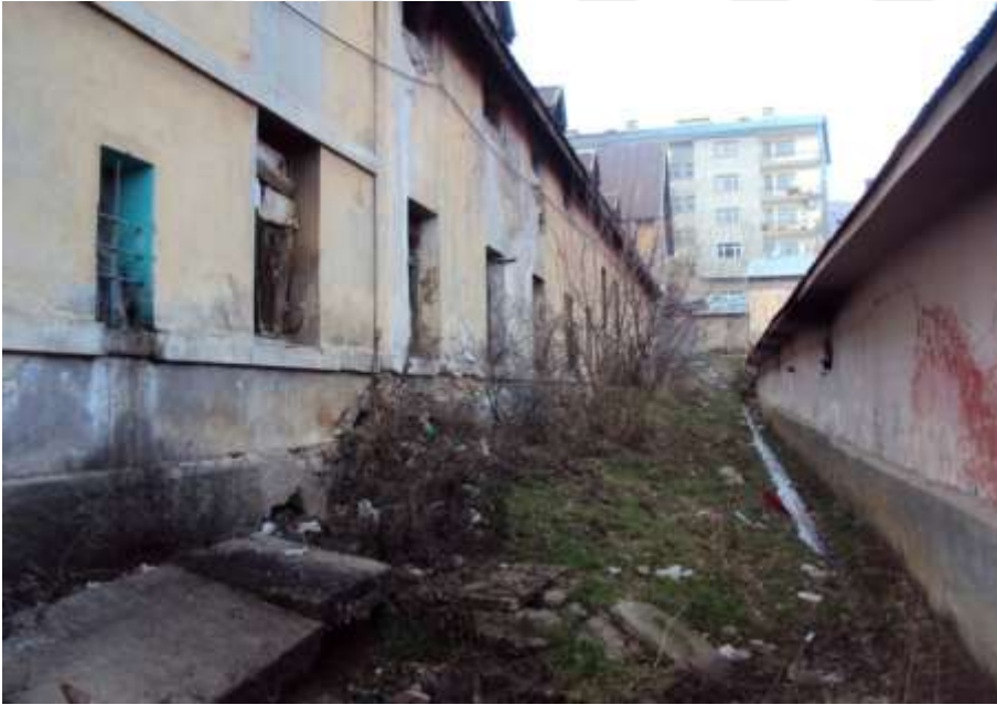
Resim 4.44. Kışla binasının doğu cephesi. Engin Benli arşivi.
