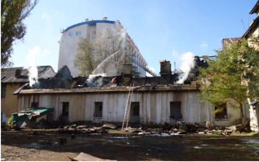
Resim 4.48. Dersim kışla binasının yanan batı cephesi. Yangının ertesi günü çekilmiş bir kare. Kaynak: URL-20, 2010
