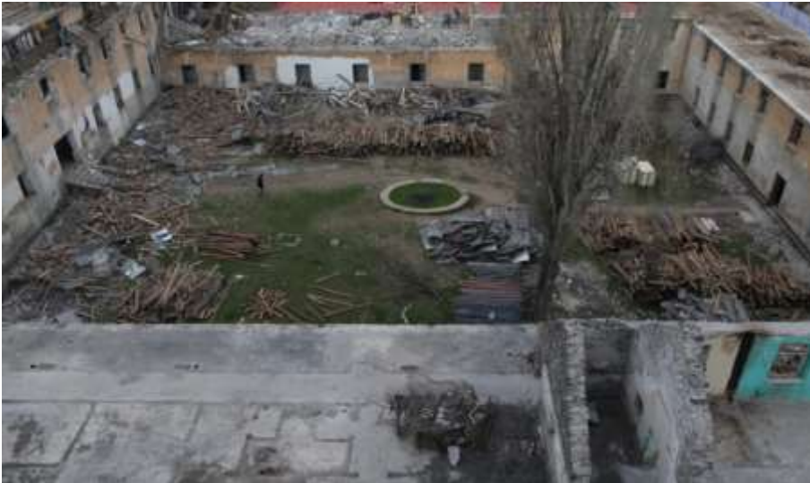
Resim 4.62. Kışla binasının restorasyon çalışması. Serpil Polat Arşivi.2015
