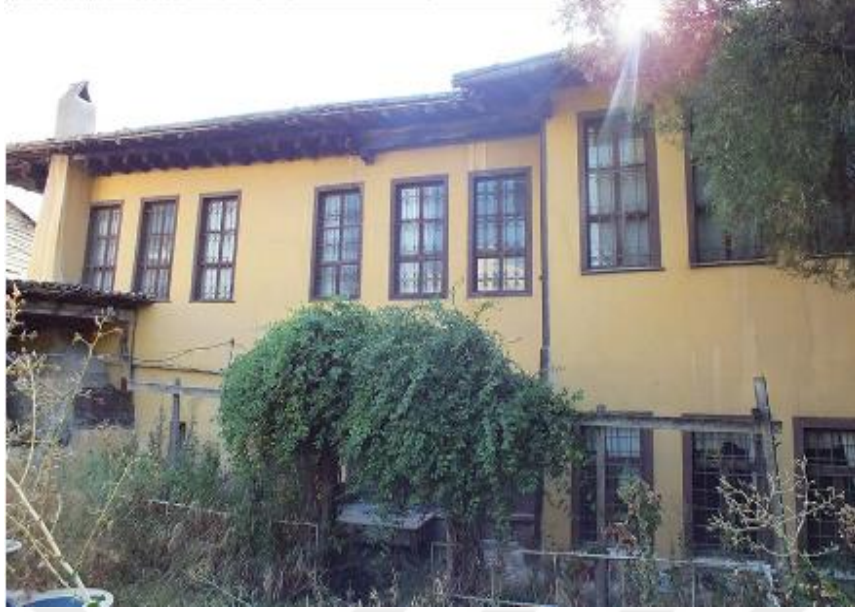
Şekil 5. 102. Canikli Konağı arka cephe [93]
