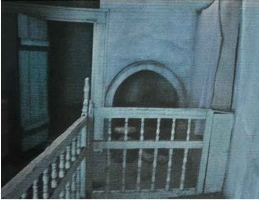
Şekil 5. 133. Canikli Konağı birinci kat sofaya çıkan merdiven [76]
