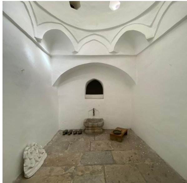
Şekil 5. 36. Latifoğlu Konağı Günlük Odada Bulunan Hamam [79]
