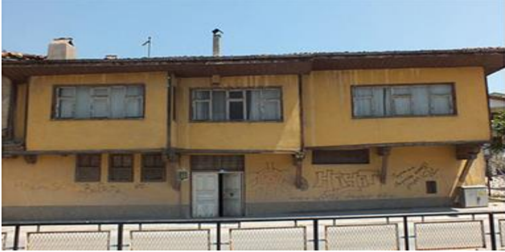
Şekil 5. 100. Canikli konağı çift kanatlı ahşap giriş kapısı-restorasyon öncesi [93]
