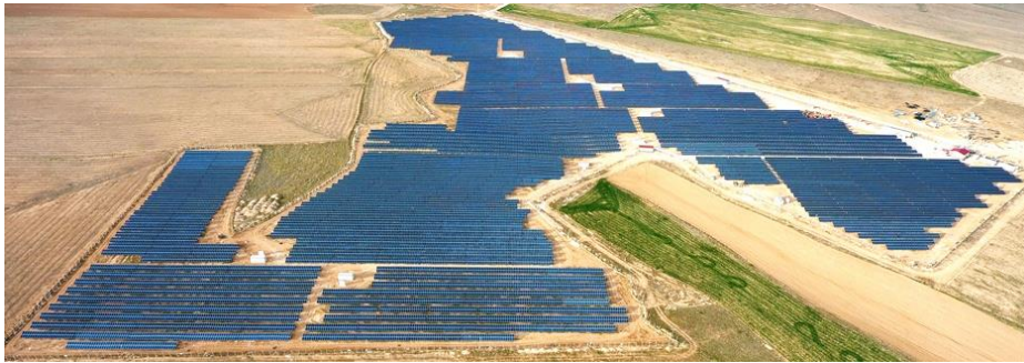
Şekil 3 Örnek Kurulu Fotovoltaik Tesis (12 MW)
