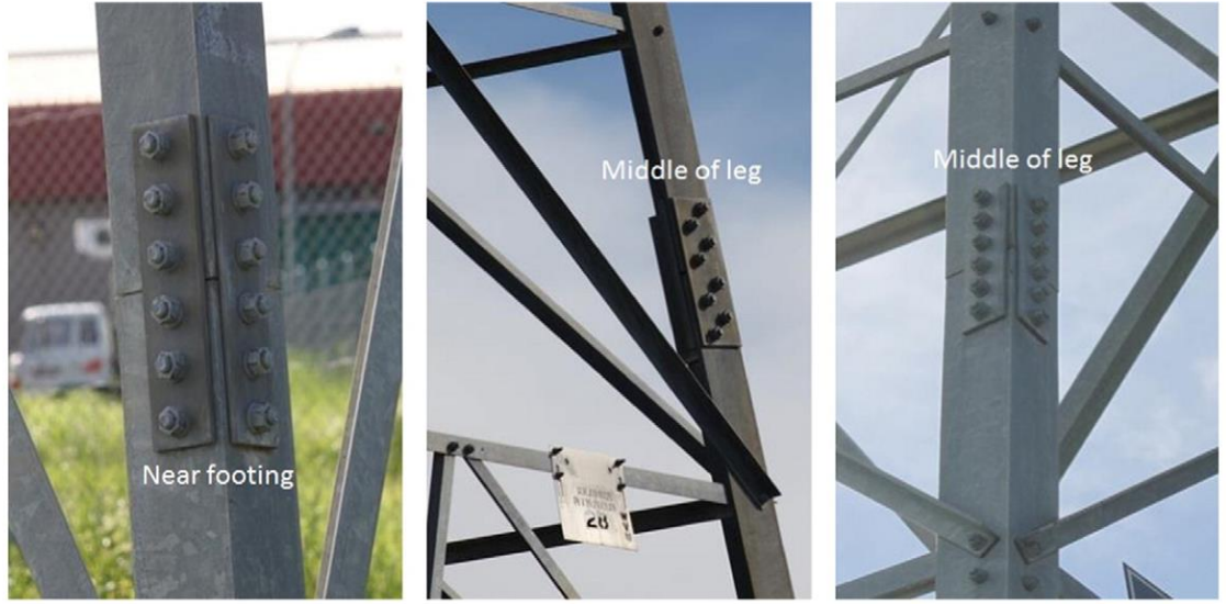
Şekil 2. 6. Kule yapılarının civatalı birleşim konumları Lu (2014)
