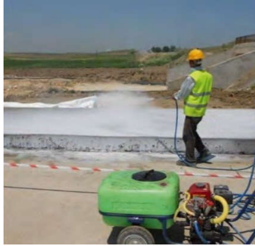
Şekil 3.12 Kür uygulaması (Gülen Şahin, Derin ve Arıkoğlu, 2016)
