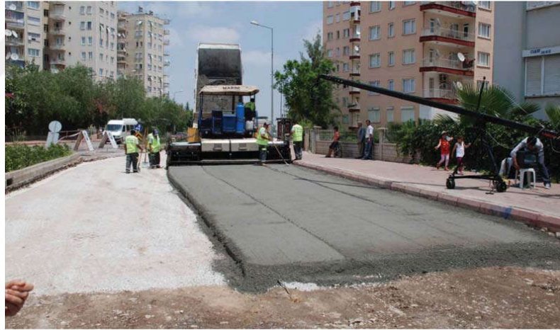
Şekil 3.16 Antalya'daki beton yol çalışmasındaki finişer ve işçiler (Yaman ve Ceylan, 2015)
