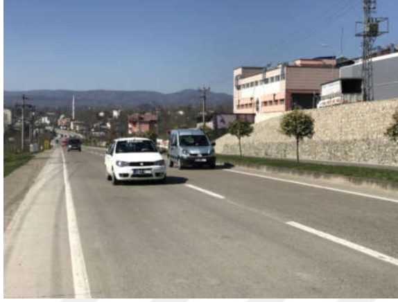
Şekil 3.13 Ordu – Ulubey yolu, beton yol kesimi (İHA, 2019)
