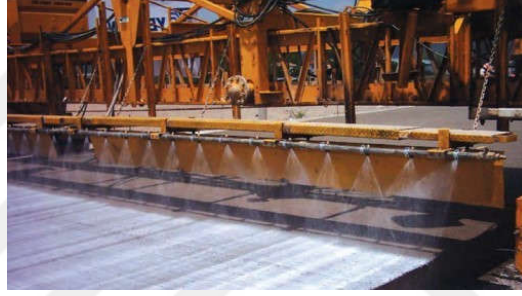
Şekil 3.7 Kür uygulaması (Yeniboğanlı, 2010)
