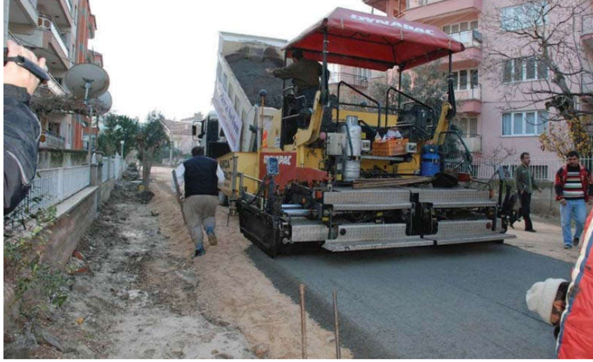
Şekil 3.17 Denizli’deki beton yol çalışmasındaki finişer (Yaman ve Ceylan, 2015)
