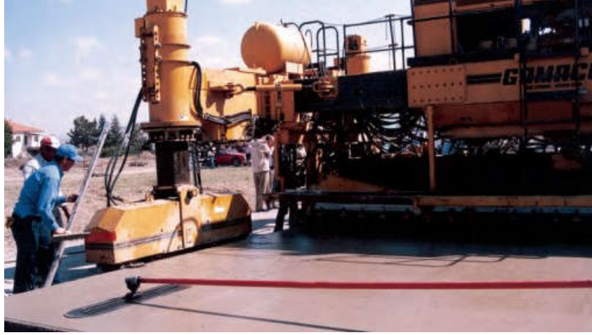
Şekil 3.6 Kaplama yüzeyinin masterlanması (Yeniboğanlı, 2010)
