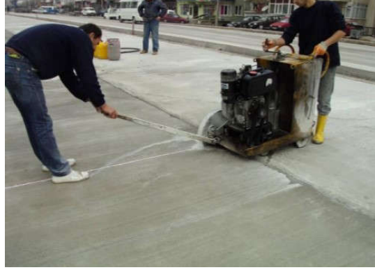
Şekil 3.15 Derz kesimi (Abut, 2018)
