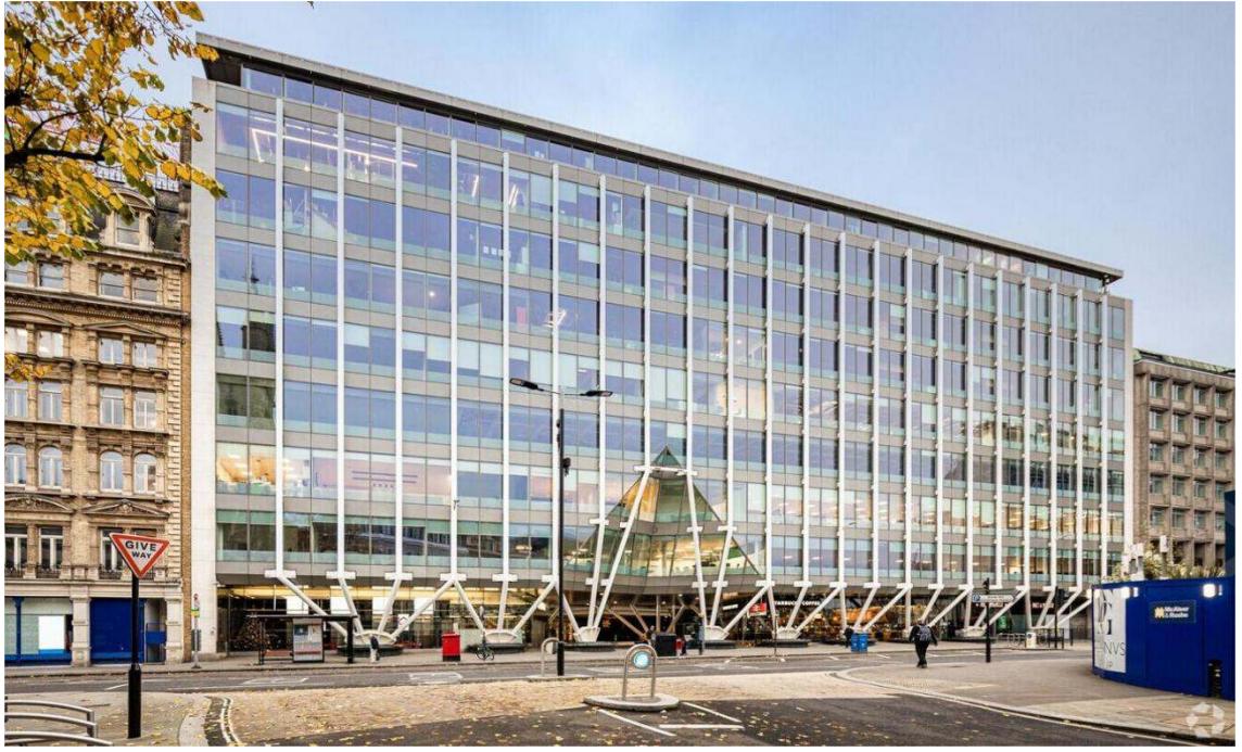
Şekil 2. Fleet Place House Binası, Birleşik Krallık, Londra
