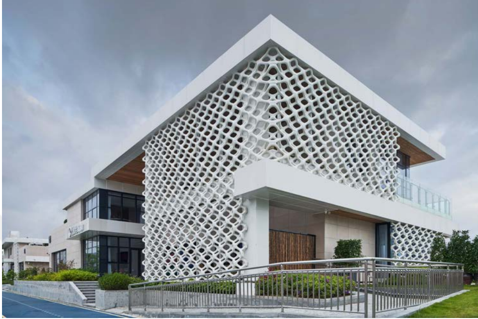
Görsel 2.4. Wenzhou Ou gölü restorandı UHPFRC beton cephe uygulaması, Çin, 2020 16
